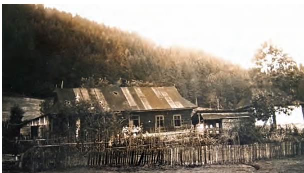
Obr. 9. Historická fotografia hydroelektrárne Banskej a hutnej spoločnosti z 1. polovice 20. storočia, predtým išlo o mlyn rodiny Grohovských. Zdroj: Obrazová kronika obce Hnilčík, diel č. 1.
