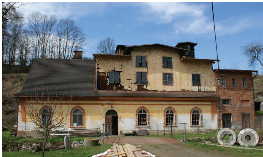
Městská Habrová čp. 734, okres Rychnov nad Kněžnou. Střešní nástavba vybudovaná kvůli instalování uměleckého složení. Mlýnař využil jednoduché a levné řešení v podobě rámové konstrukce opatřené bedněním, na němž je pobitá asfaltová lepenka a opatřená sjednocujícím barevným nátěrem. Foto: Radim Urbánek, 2010
