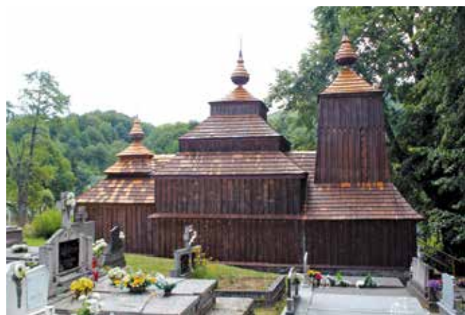
Príkra, drevený gr. k. Kostol sv. Michala, stav po poslednej obnove v roku 2016. Foto: D. Sabol.
