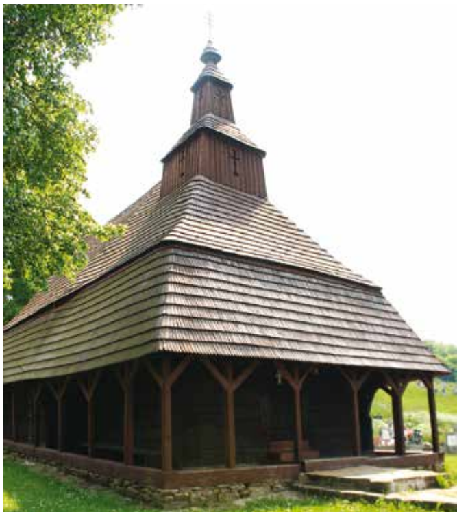
Topoľa, drevený gr. k. Kostol sv. Michala, stav po obnove. Foto: D. Sabol, 2015.
