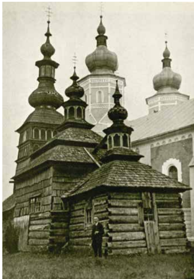
Mikulášová, drevený kostol a novopostavený murovaný kostol, medzi rokmi 1927 – 1935. Repro: SÍČYNSKYJ, Vladimír. Dřevěné stavby v karpatské oblasti. Praha, 1940.
