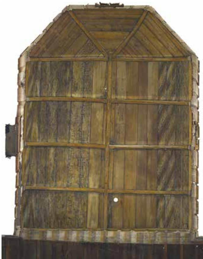
14. Hervartov, Kostol sv. Františka z Assisi, ortosnímk, pohľad zdola na presbytérium kostola zaklenuté drevenou klenbou s ornamentálnou šablónovou maliarskou výzdobou. Vyhotovila M. Mravová. Zdroj: Oddelenie digitalizácie a grafickej dokumentácie PÚ SR.
