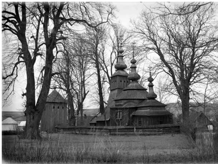
Ladomirová, drevený Kostol sv. Michala Archanjela a zvonica, 1935. Foto: Archív PÚ SR.
