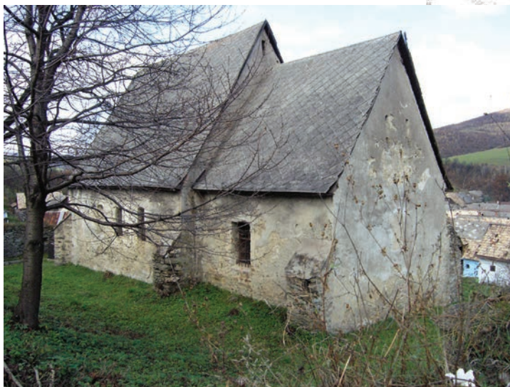
3. Henckovce, južná a východná fasáda kostola. Foto: M. Kalinová, 2004.
