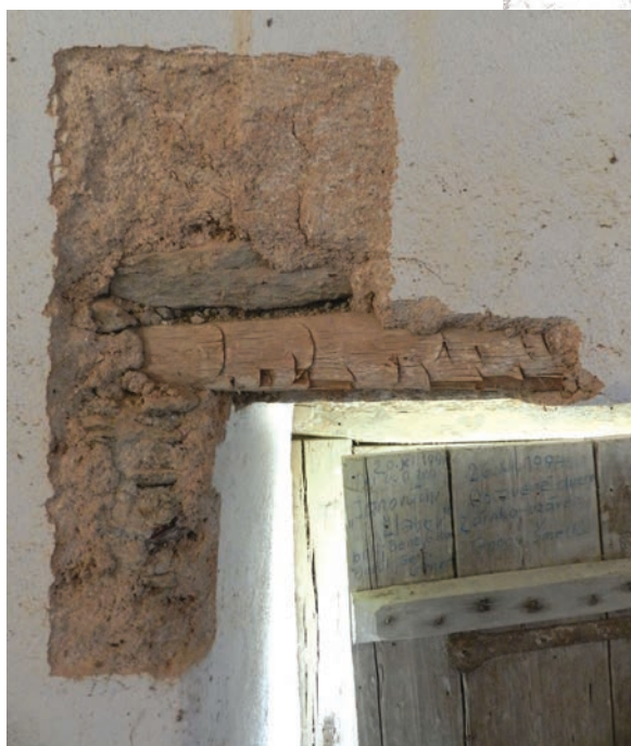
8. Rakovnica, Kostol sv. Márie Magdalény, interiérový drevený preklad západného vstupu. Foto: M. Kalinová, 2019.
