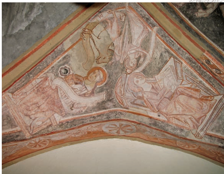
◀◀ 11. Klenbové pole svätyne s čiastočným prekrytím cementovým tmeľom. Foto: M. Janšto, 2005.
