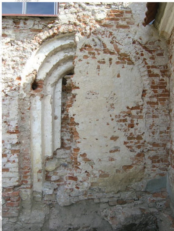
16. Šaštín-Stráže, Kostol sv. Alžbety Uhorskej, hlavný južný portál v čase odkryvu. Foto: M. Kalinová, 2013.
