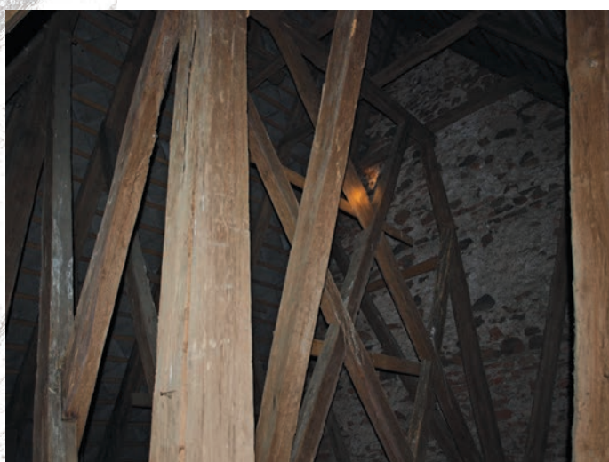
6. Rybník, ev. a. v. kostol, pohľad na centrálnu rámovú stolicu barokového krovu nad loďou. Foto: K. Ďurian, 2011.
