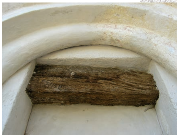
18. Šaštín-Stráže, Kostol sv. Alžbety Uhorskej, archivolta portálu s dreveným trámom. Foto: M. Kalinová, 2014.
