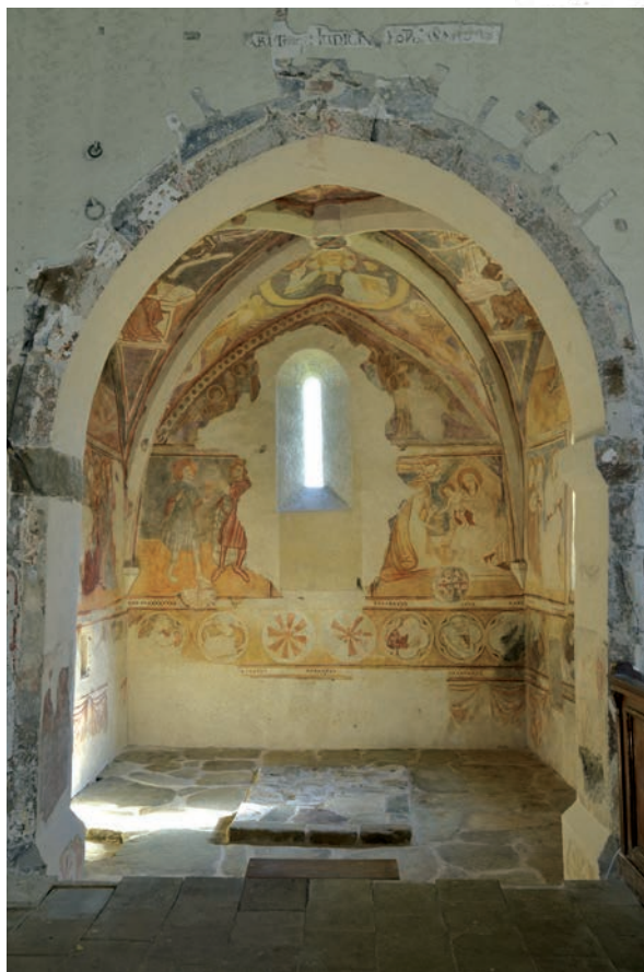
13. Celkový pohľad do svätyne po reštaurovaní. Foto: M. Janšto, 2012.
