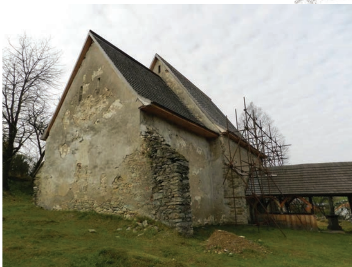
4. Henckovce, severná a východná fasáda kostola. Foto: M. Kalinová, 2016.
