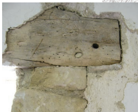
◀◀ 13. Sedmerovec-Pominovec, Kostol sv. Jána Krstiteľa, interiérový drevený preklad portálu. Foto: M. Kalinová, 2011.
