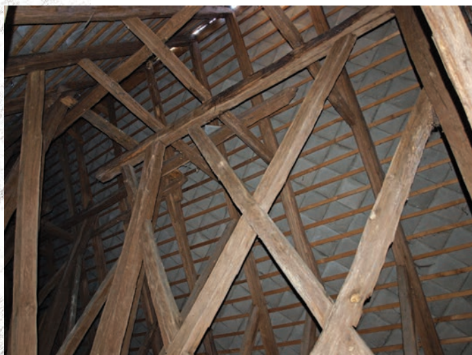
5. Rybník, ev. a. v. kostol, pohľad na hrebeňovú časť barokového krovu nad loďou. Foto: K. Ďurian, 2011.
