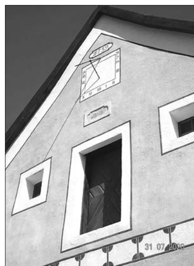
Obr. 10. Južná štítová fasáda so slnečnými hodinami, vročeniami a detailom kordónovej rímasy po obnove, 2020, foto: E. Šabíková.
