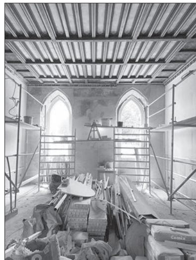
Obr. 12. Interiér kaplnky, pôvodné neoslobové okná, odkryté predchádzajúcimi výskumami, 2019, foto: P. Ďurko.
