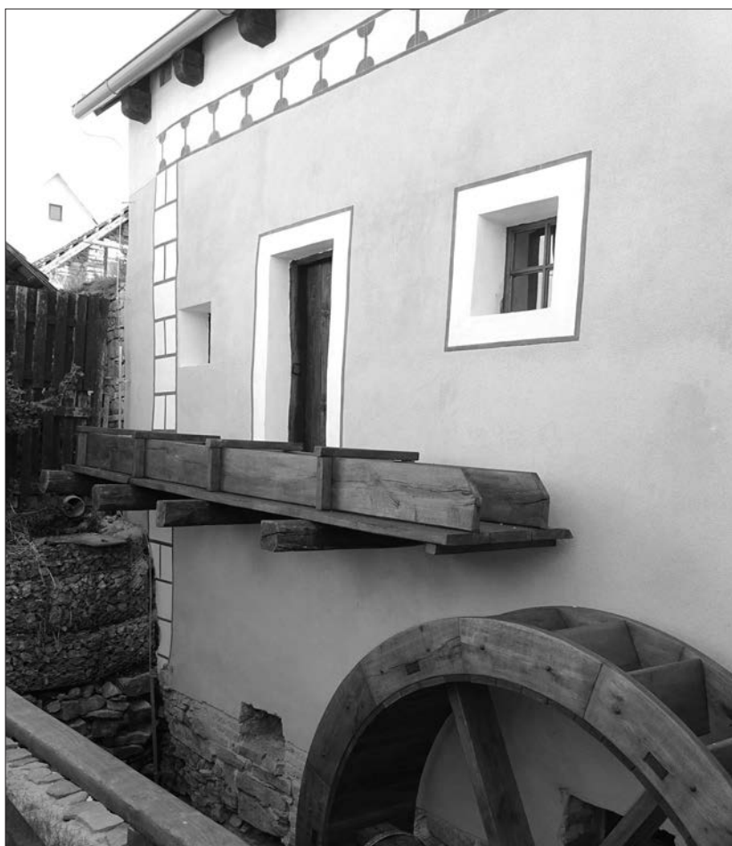
Obr. 13. Severná časť západnej návodnej strany s vodným kolesom a so žlabom privádzajúcim pôvodne vodu na koleso po obnove, 2020, foto: E. Šabíková.
