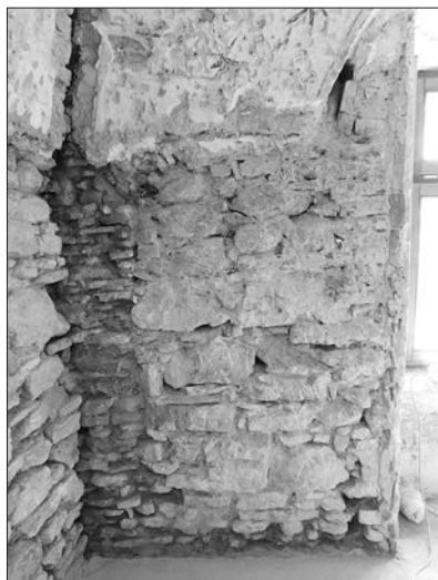
Obr. 7. Severozápadná miestnosť prízemia počas reštaurátorských prác, vľavo na čelnej stene stredoveké murivo s branou špalety a časťou segmentového záklenku neskôr zamurovaného pôvodného okna.
