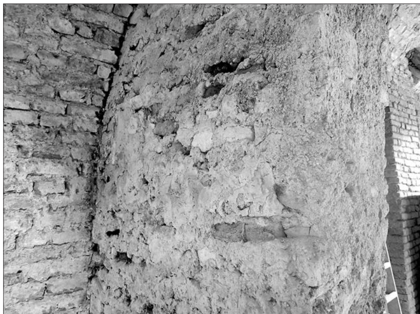
Obr. 27. Pivnica pôvodného solitérneho domu. Základový charakter južného lica južnej steny potvrdzujúci primárne ukončenie domu na juhu.
