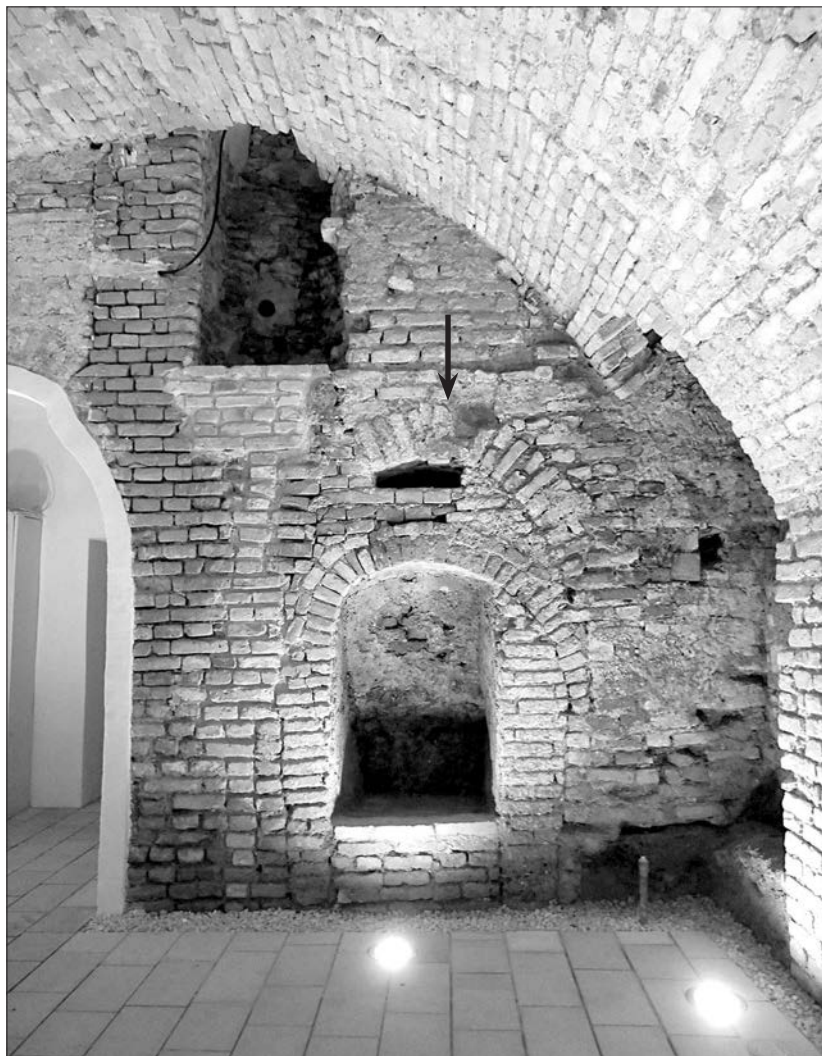
Obr. 26. Pivnica pôvodného solitérneho domu, stojaceho západne od stredovekého kláštora; severná stena so zamurovaným primárnym vstupom.
