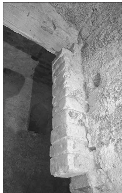
Obr. 18. Pôvodný vstupný otvor do spodného podlažia, pohľad z interiéru, detail zobrazujúci južnú stojku vytvorenú sekundárne z atypicky veľkých tehl.
