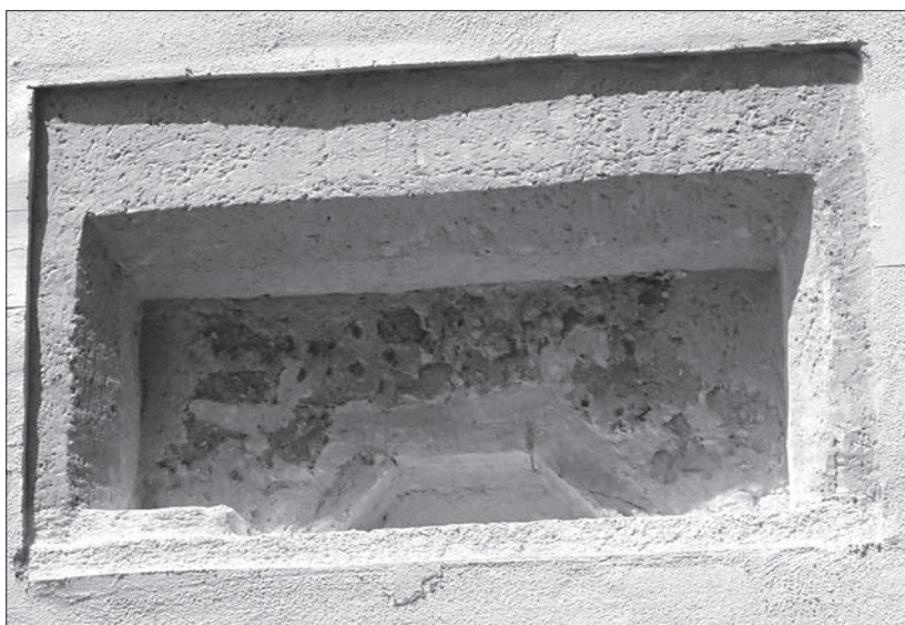
Obr. 25. Trojboký uzáver gotického okna umiestneného vo vpadline s okosením; dnešná prezentácia nálezu na južnej fasáde južného stredovekého krídla.
