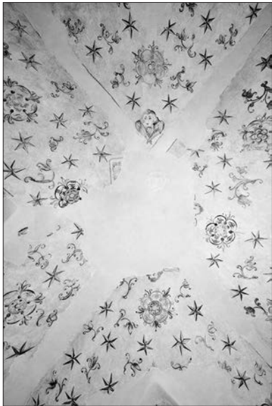
Obr. 11. Severozápadná miestnosť prízemia po reštaurovaní, stred klenby, foto: P. Hrachovský.
