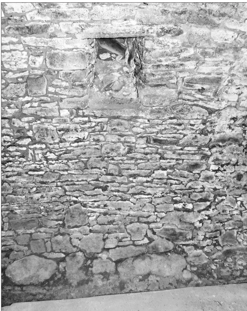
Obr. 5. Severná stena blavného priestoru pivnice s pôvodným vetracím otvorom.
