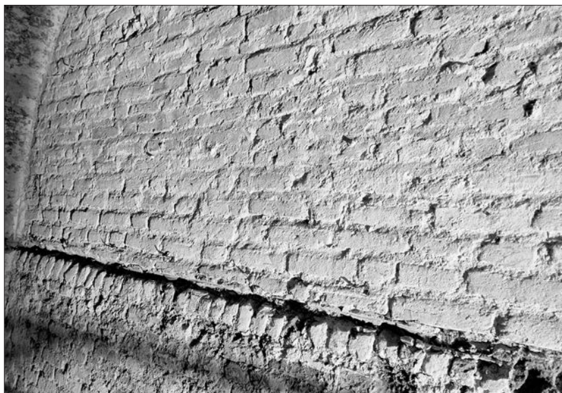
Obr. 14. Východná stena spodného podlažia prvého konventného domu, riadok z klasovo uložených tehál zachovaný pozdĺž južnej tretiny steny, označujúci polohu pôvodnej podlahy.
