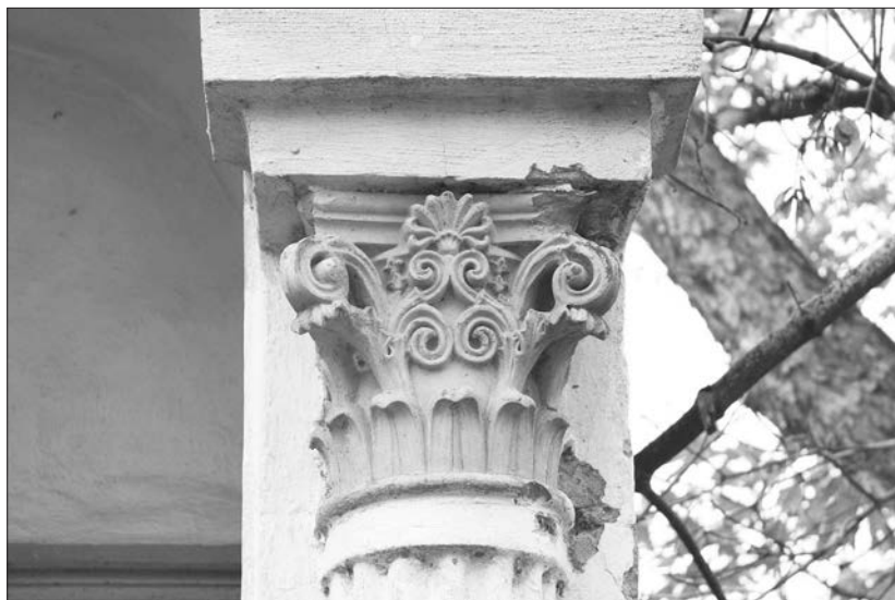
Obr. 7. Detail architektúry jednej z kaplniek (blavica polstípu), 2022, foto: A. Dúbravský.
