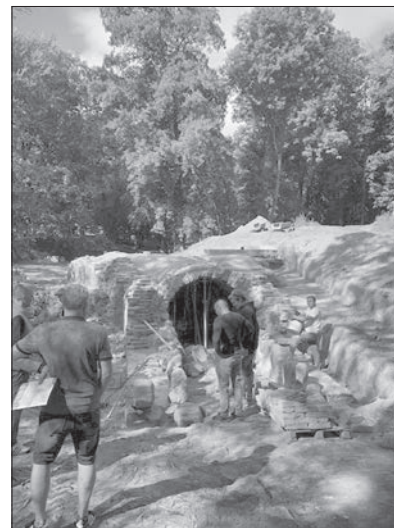
Obr. 17. Exteriér grotty po ukončení zabezpečovacích a prieskumných prác, 2022, foto: P. Ďurko.
