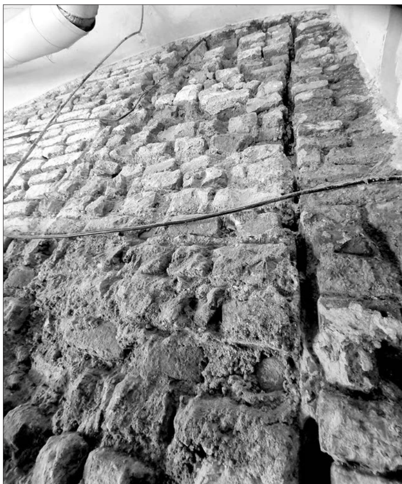
Obr. 12. Východná stena spodného podlažia prvého konventného domu, nálež vertikálnej kaverny po odstránení južného múru v polohe juhovýchodného kúta.
