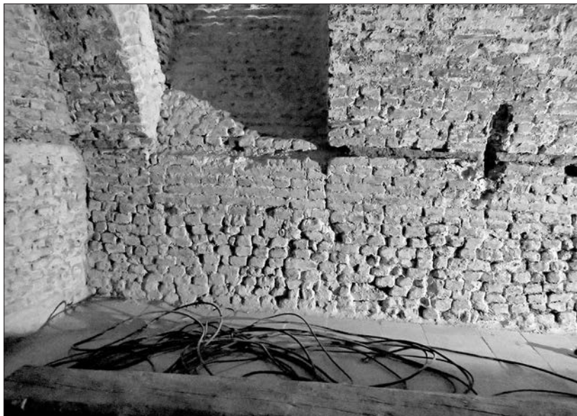
Obr. 16. Západná stena spodného podlažia prvého konventného domu; základ odkrytý pri znižovaní podlahy.
