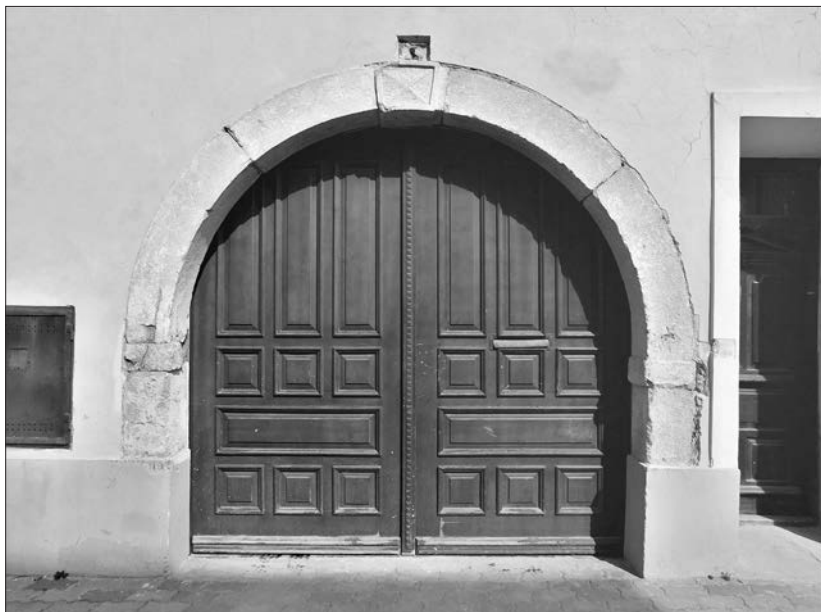
Obr. 3. Portál do prejazdu na západnom priečelí z Komenského ulice.
