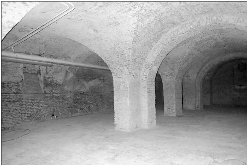
Obr. 8. Pivnica B pod južným krídlom západného nádvorja, pohľad od severovýchodu.
