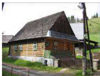
podmurovka ľudového domu č.p. 241
