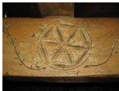
dom č.p. 213–nosný stropný trám izby
