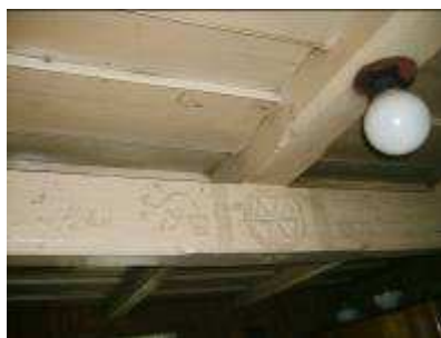
dom č.p. 236–nosný stropný trám izby
