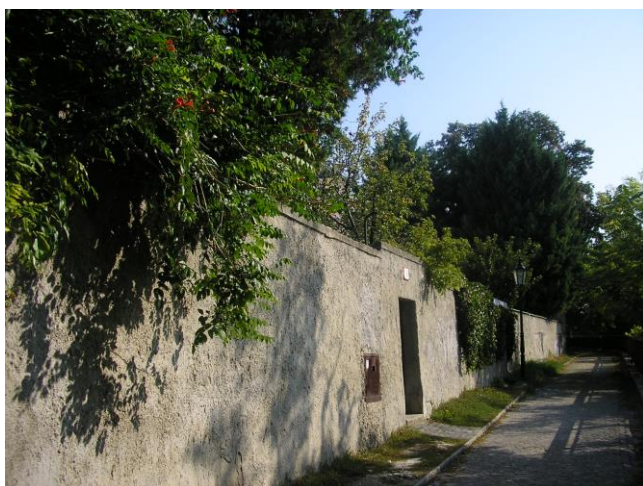
oplotenia na Hornom palánku murované
