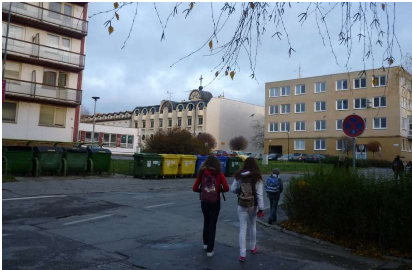
5.4.6. Vonkajší pohľad č. 2 - z Ulice Mudroňovej, pri domove dôchodcov
