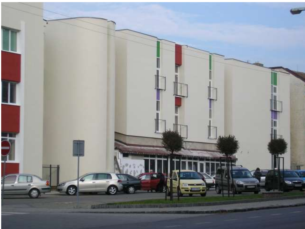
5.4.19. Pohľad č. 7 z juhovýchodu na zástavbu Krušovskej ulice
