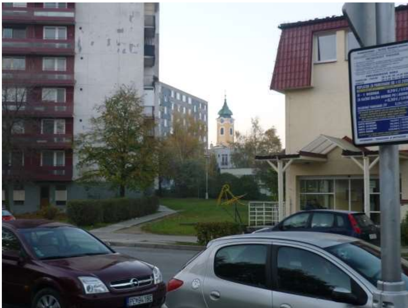
5.4.12. Vonkajší pohľad č. 8 - od prieniku Bernolákovej a Škultétyho ulice je pohľad na vežu kostola
