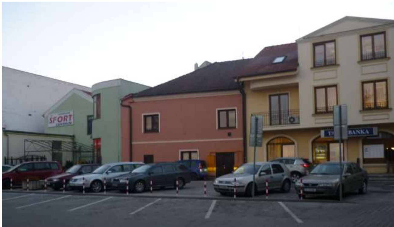
5.4.22. Pohľad č.10 z juhozápadu na zástavbu Ulice Škultétyho
