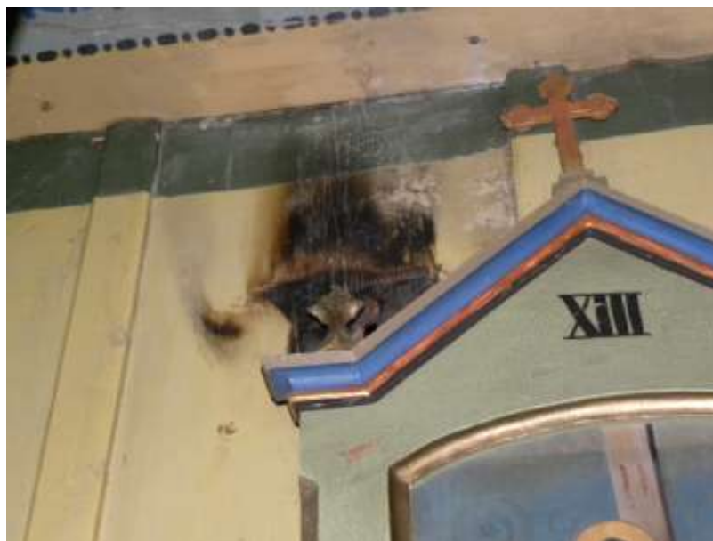
Obr. 2.2. Dôsledok skratu elektrického vedenia na severnej stene v babinci
