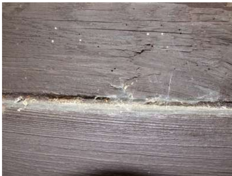
Obr. 7.2. Výletové otvory drevokazného hmyzu v trámoch zrubu južnej steny (exteriér), aj s požerkami
