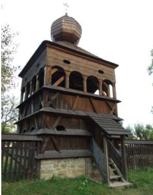
Obr. 3.4. Samostatne stojaca zvonica nevykazuje známky poškodenia
