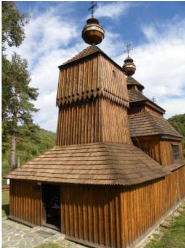
Obr. 1.1. Grécko-katolícky chrám sv. Mikuláša s novou povrchovou úpravou opláštenia a strešnej krytiny.
