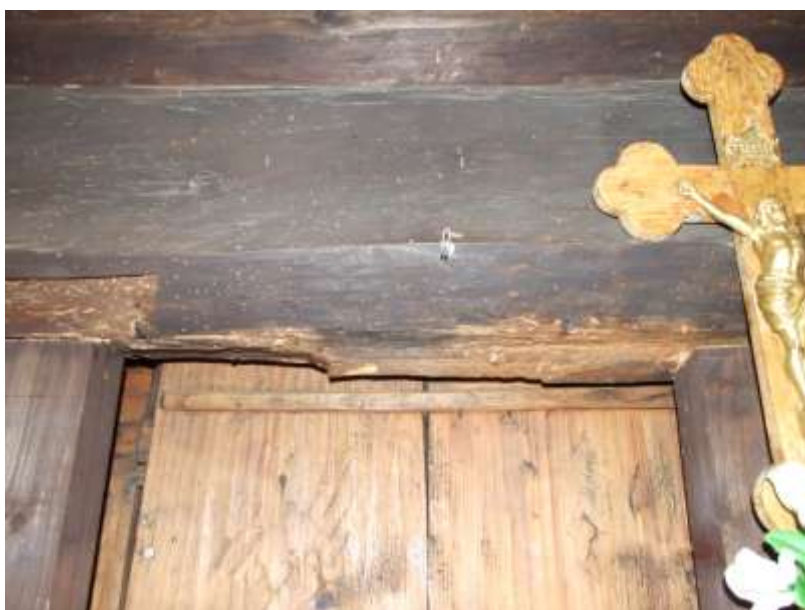
Obr. 5.3. Rozsiahly výskyt výletových otvorov drevokazného hmyzu v nosnom tráme ikonostasu.
