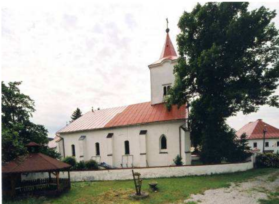
30. Celok areálu rím.-kat. farského kostola sv. Trojice v pohľade zo severu; č. ÚZPF 78/1-3
