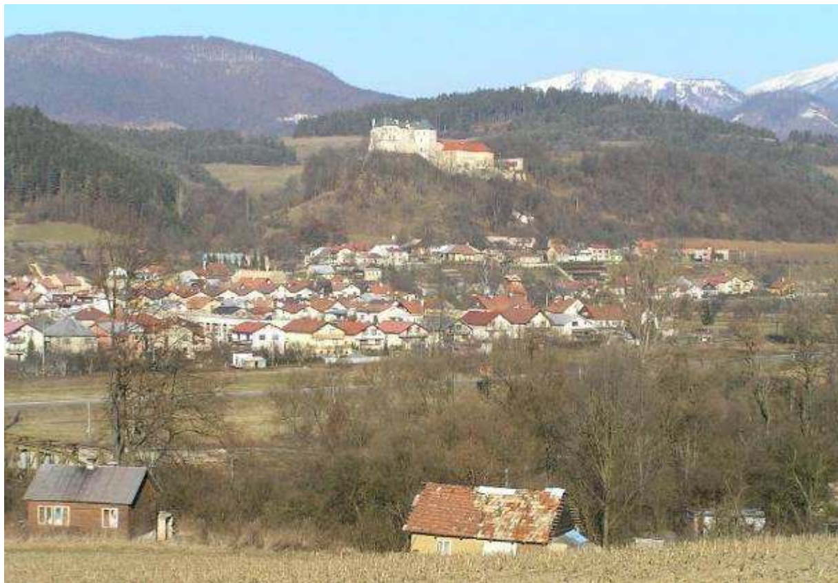
8. Panoráma Ľupčianskeho hradu v krajinnom prostredí Bystrického podolia. Výstavba IBV v popredí vytvára vďaka presným urbanistickým a architektonickým regulatívom jednotiacu štruktúru v priamej nadväznosti na historické jadro obce
