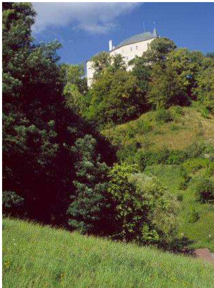
24., 25. Celok hradu nad vysoko nad údolím, ktorým vedie prístupová cesta z obce Slovenská Ľupča
