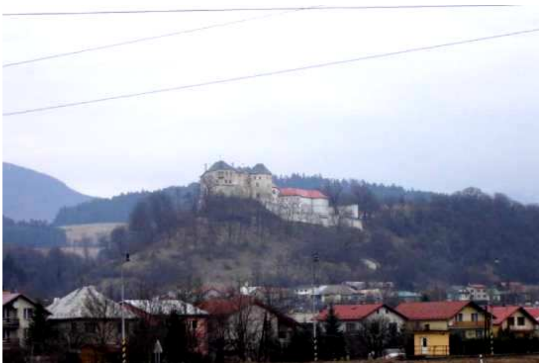
7. Hrad s areálom v pohľade od cesty č. I/66 v oblasti stavadla I. železničnej stanice, v popredí novšia zástavba obce s jednotiacou architektonickou štruktúrou
