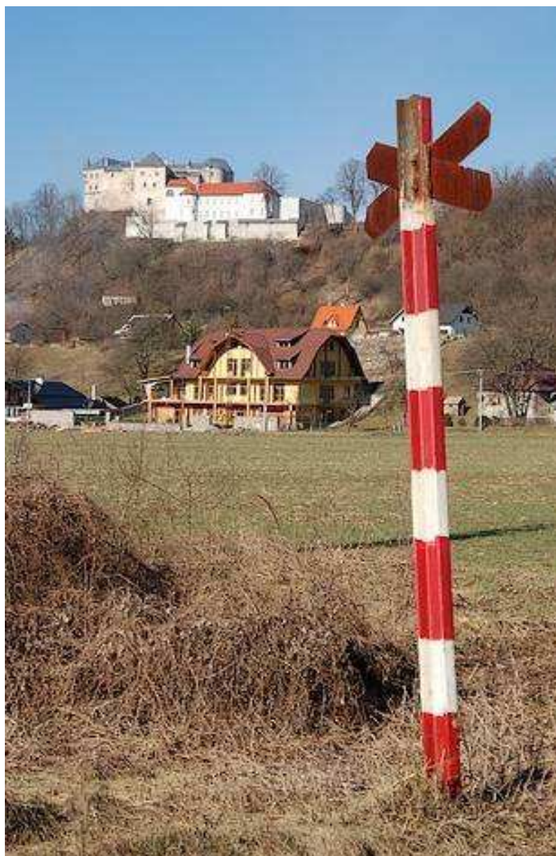
16. Rozširovanie zástavby pod úpäťm ľupčianskeho hradného vrchu
