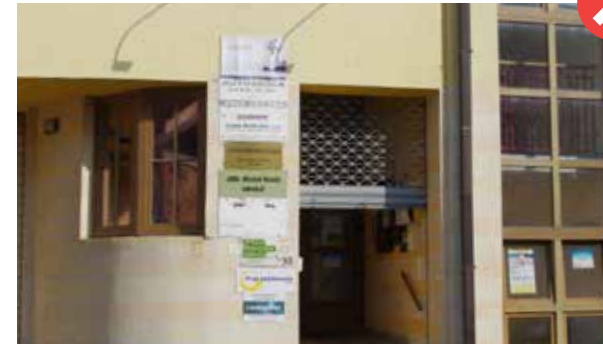
▲ 32. Nezjednotený systém označenia viacerých firiem v budove.
