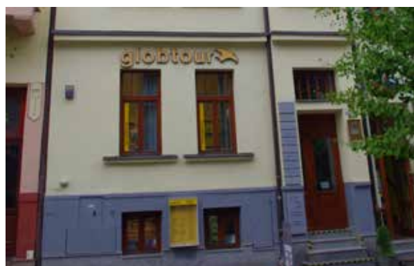
▲ 72. Návrh reklamy porovnáwanej budovy už podľa manuálu. Jednotné označenie reaguje na proporcie budovy, odstránila sa duplicitná a nevhodná reklama.
