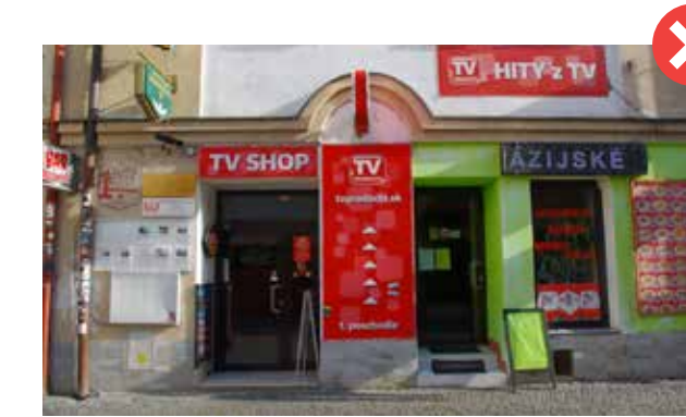
▲ 27. Reklama rôzneho typu a prevedenia, chýba jej zjednotenie na fasáde.
