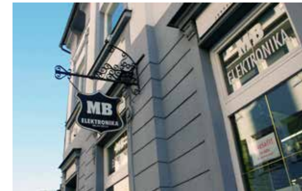
▲ 22. Vývesný štít kolmý na stenu fasády – výstrč.
