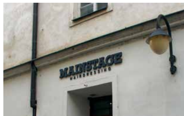
▲ 11. Príklad reklamného zariadenia. Znaký sú na fasáde prilepené.
