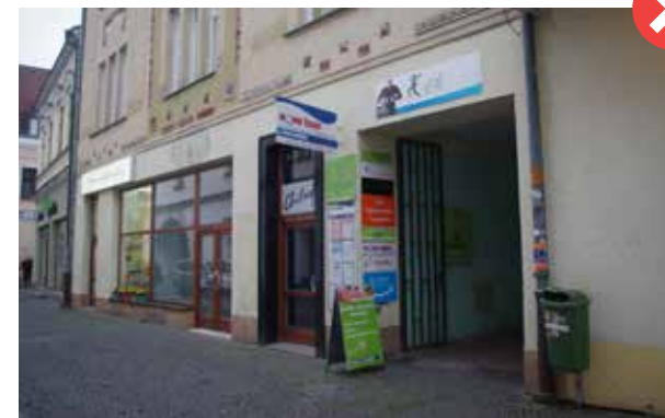
▲ 58. Chýba zjednotenie reklamy na fasáde budove.
