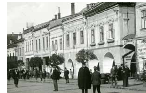
▲ 6. Mariánske námestie, pohľad na vstup do Burianovej ulice.
