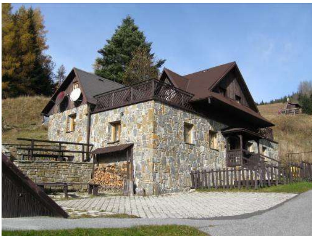
Novostavba na pozemku parc. č. 449/10
