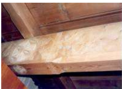
PRĽA v Ždiari - Horný koniec dom ľudový č. p. 425 nosný stropný trám izby
