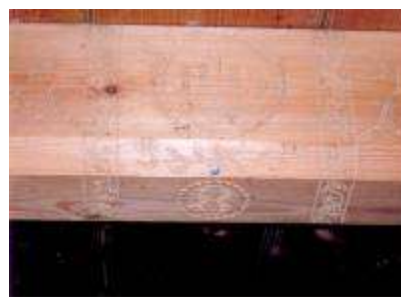
PRĽA v Ždiari - Horný koniec dom ľudový č. p. 451 nosný stropný trám izby
