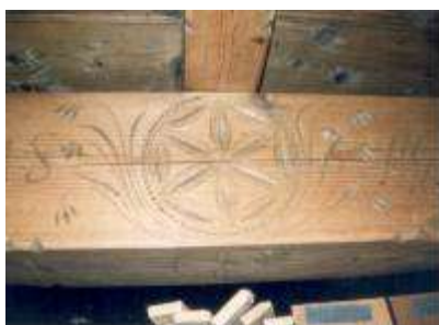
PRĽA v Ždiari - Horný koniec dom ľudový č. p. 440 nosný stropný trám izby
