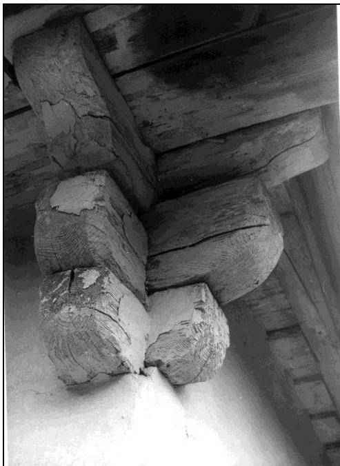
HF178. Vázba na nároží. Archív PÚSR, príloha Zásad pamiatkovej starostlivosti, sign. č. T3468, foto č. 181.
