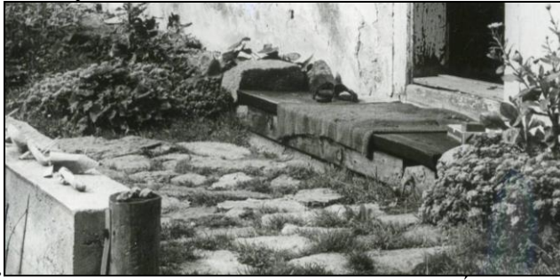
HF176. Pred vstupom do domu č. 5, rok 1980. Archív PÚSR , príloha Zásad pamiatkovej starostlivosti, sign. č. T3468, foto č. 59.
