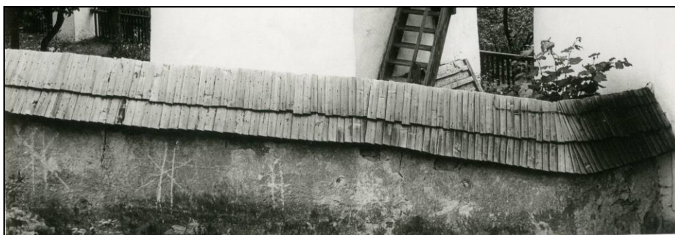
HF167. Na severozápadnej strane areálu r. k. kostola Premenenia Pána. Archív PÚSR, príloha Zásad pamiatkovej starostlivosti, sign. č. T3468, foto č. 36.
