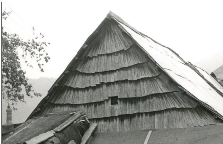
HF190. Dom č.22, rok 1980. Archív PÚSR, príloha Zásad pamiatkovej starostlivosti, sign. č. T3468, foto č. 79.
