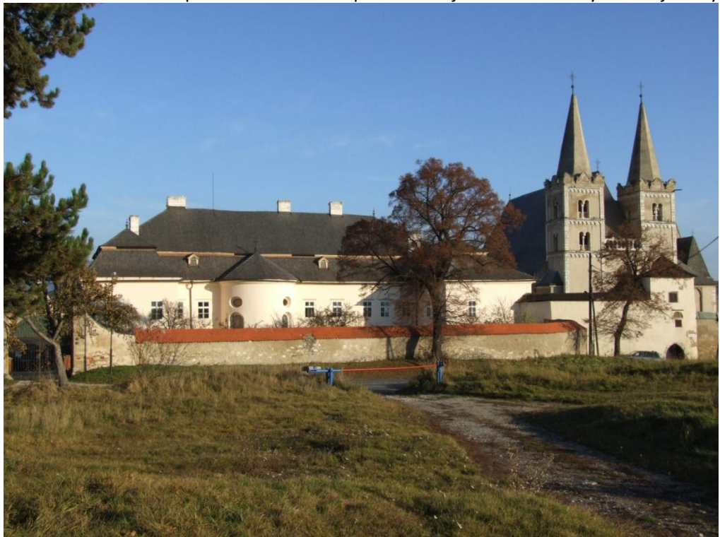
09 - pohľad na severovýchodnú časť opevnenia z exteriéru
