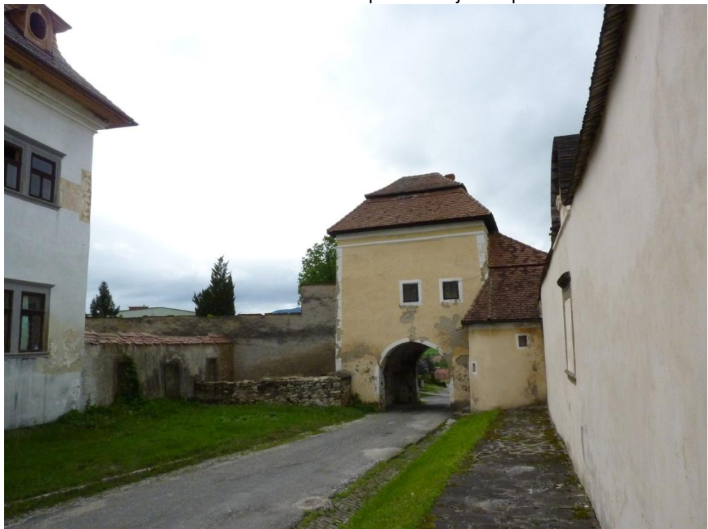
07 - pohľad na východnú bránu z interiéru
