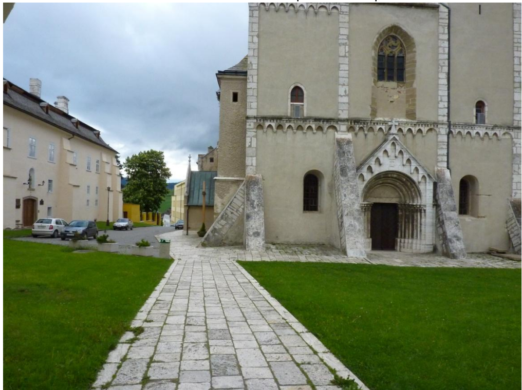
05 - pohľad do interiéru PR od západnej brány
