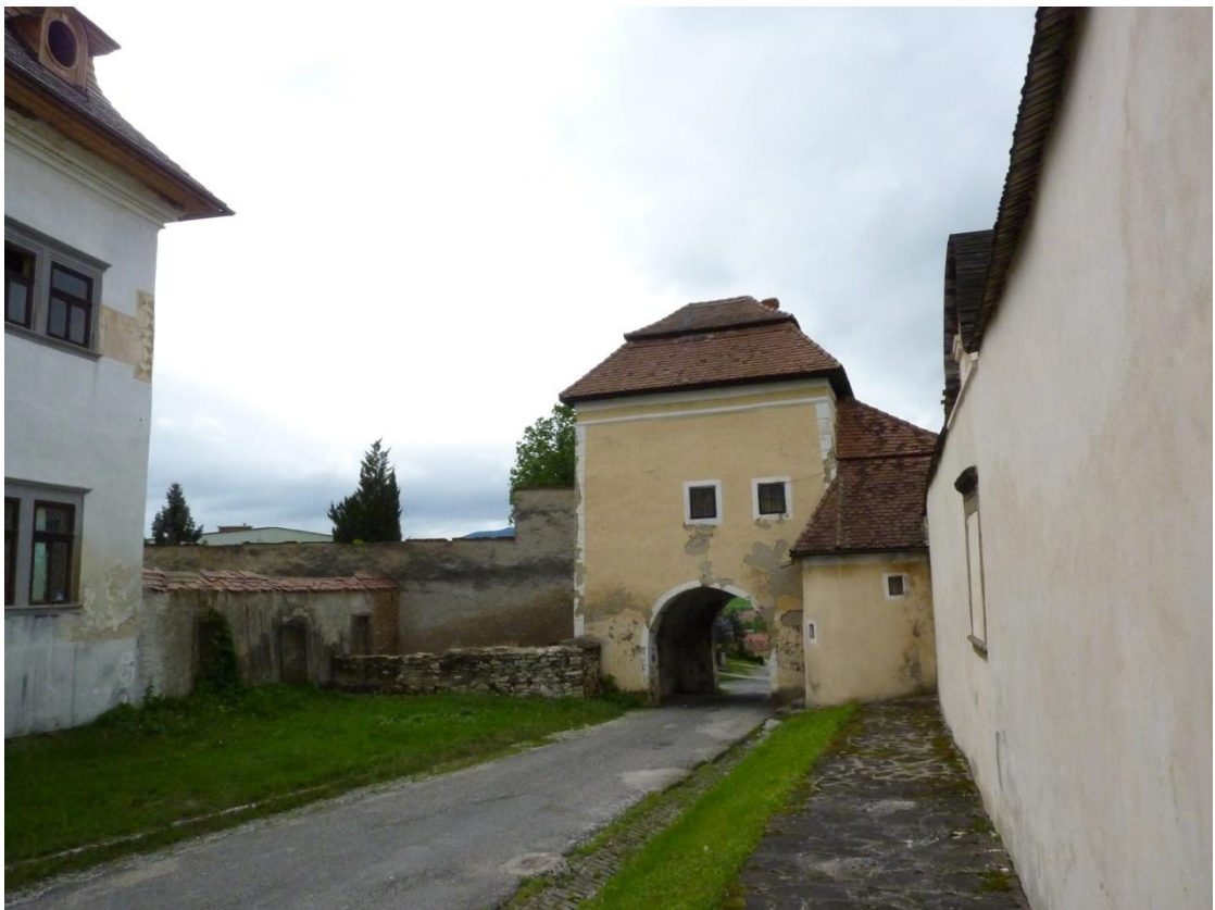
14 - opevnenie č. 1 s objektom východnej brány, pohľad z interiéru pamiatkovej rezervácie
