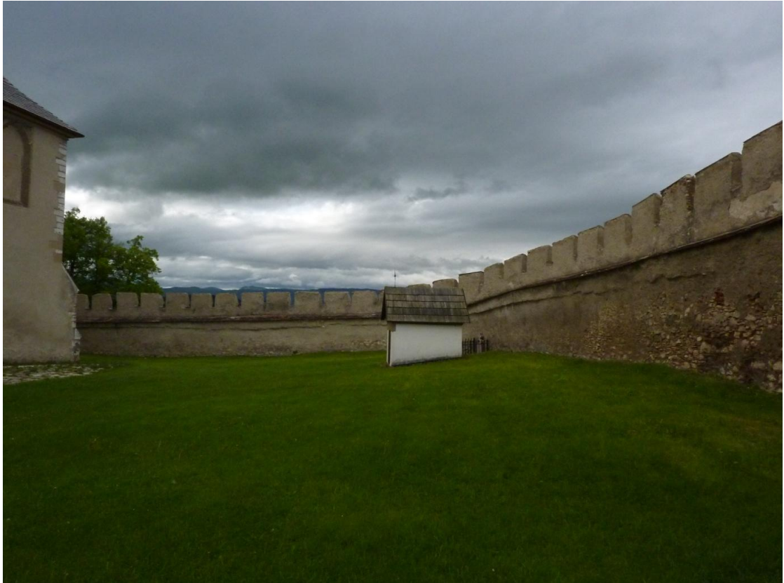
10 - pohľad na juhozápadnú časť opevnenia z interiéru
