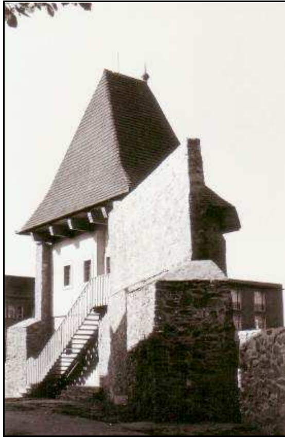
141 -Bašta na Kováčskej ulici – stav z roku 1994
