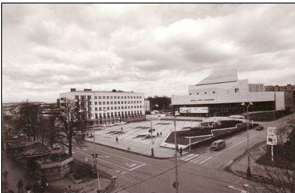
109 - Námestie legionárov – pošta a seminár nahradený hotelom Dukla a Divadlom Jonáša Záborského – stav z roku 1994
