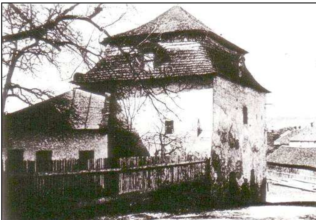
115 - Kumšt – vodná veža, pôvodná bašta mestského opevnenia
