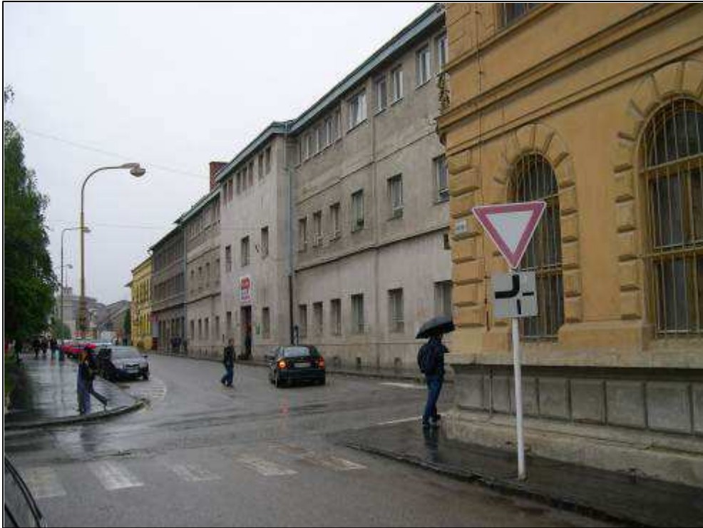
132 - Konštantínova ulica – pohľad na sever z križovatky s Metodovou ulicou, súčasný stav
