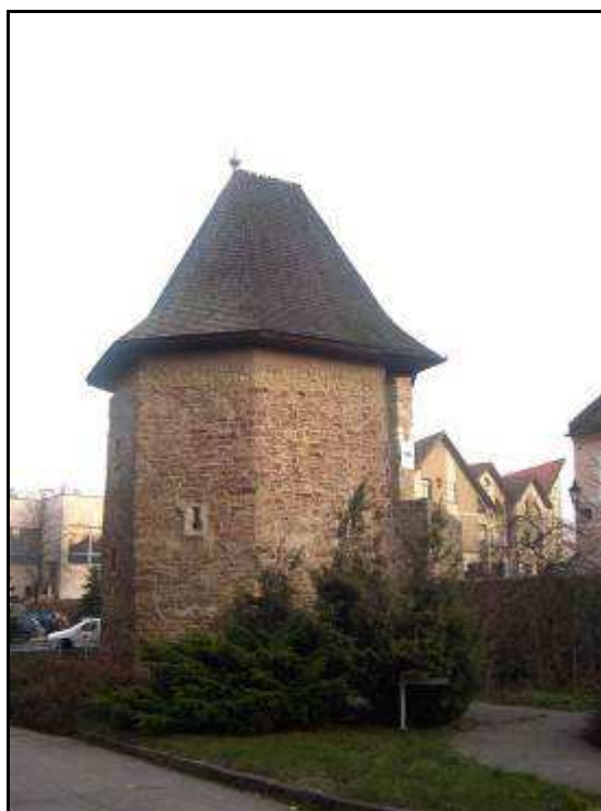
144 - Bašta na Kováčskej ulici – súčasný stav
