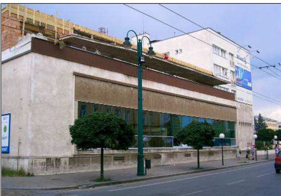
107 - Hotel Dukla počas realizácie nadstavby – súčasný stav
