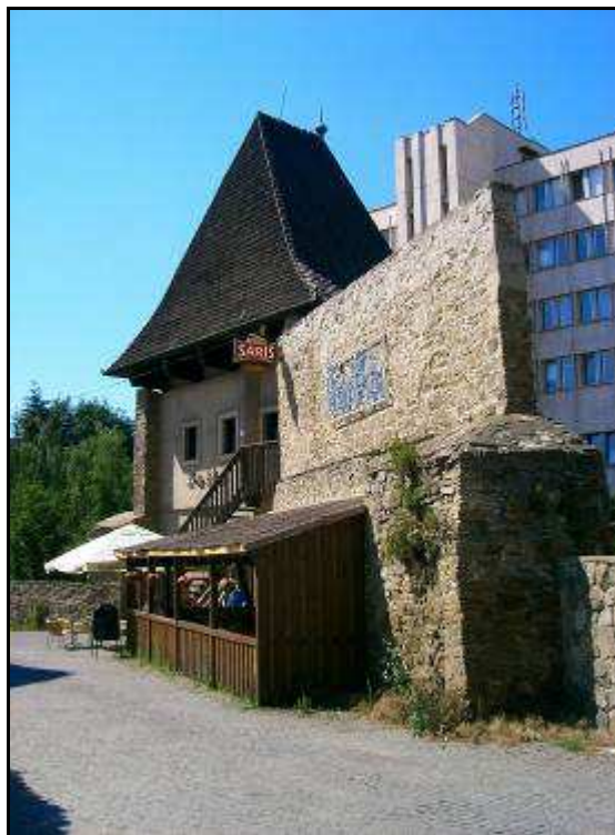
142 - Bašta na Kováčskej ulici – súčasný stav
