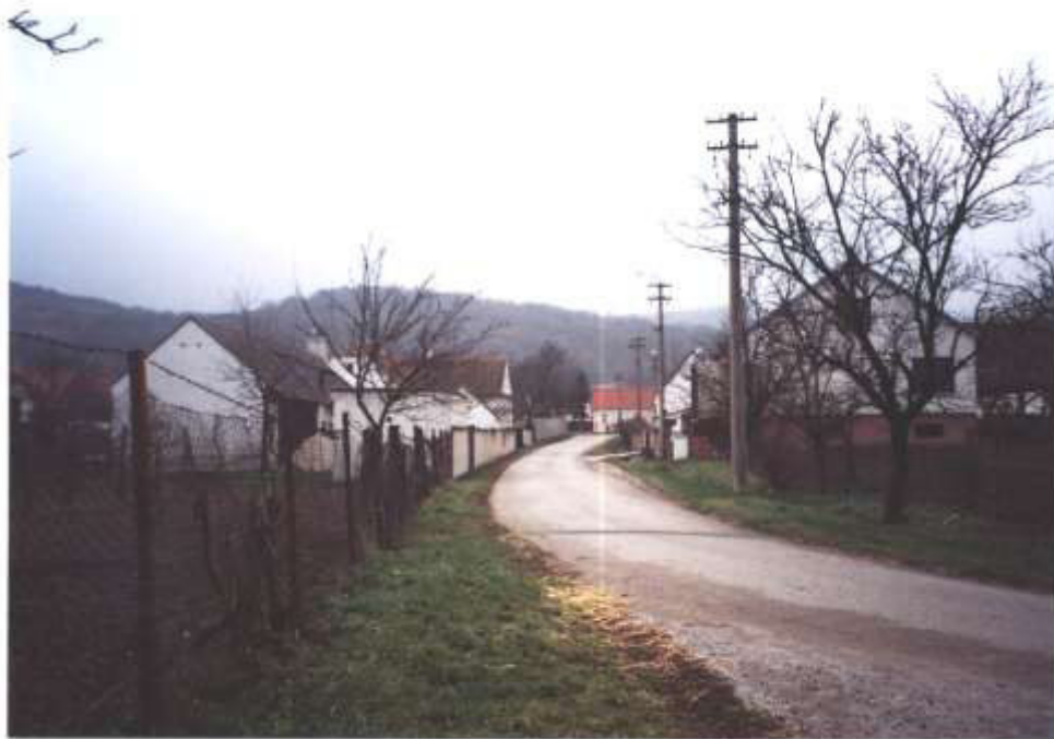
9. Cestná komunikácia medzi ľudovými domami súpisné č. 29 a 32 – pohľad od severu
