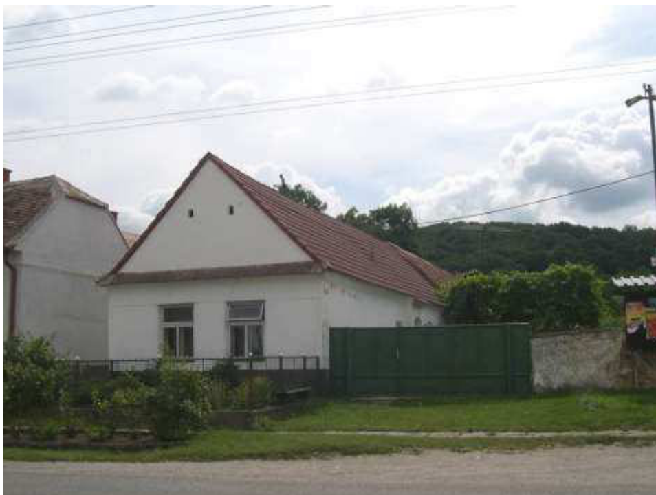
49. Ľudový dom súpisné č. 81, objekt NKP č. ÚZPF 10 648
