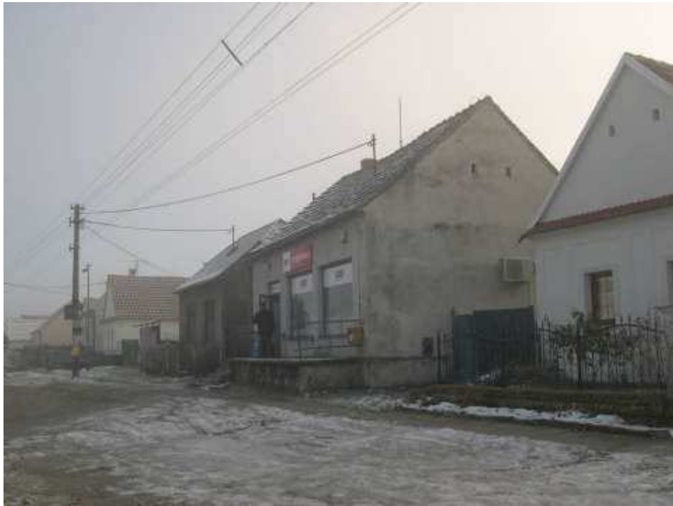
50. Rodinný dom súpisné č. 82 a predajňa potravín súpisné č. 83 (sprava), objekty nenarúšajúce územie PRLA
