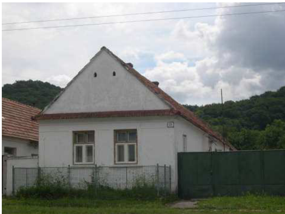
43. Ľudový dom súpisné č. 73, objekt NKP č. ÚZPF 10 643
