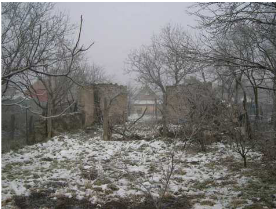
72. Ruina stodoly na parcele č. 273/1 za domom súpisné č. 88 – pohľad od juhu
