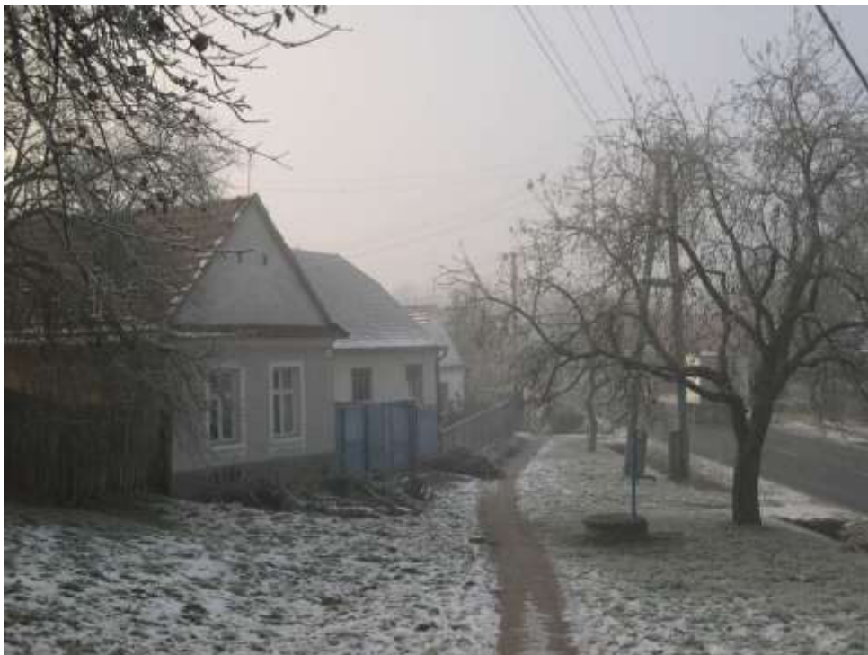
15. Západný koniec juhovýchodného domoradia s domami súpisné č. 92, 93 a 94 – pohľad od severovýchodu
