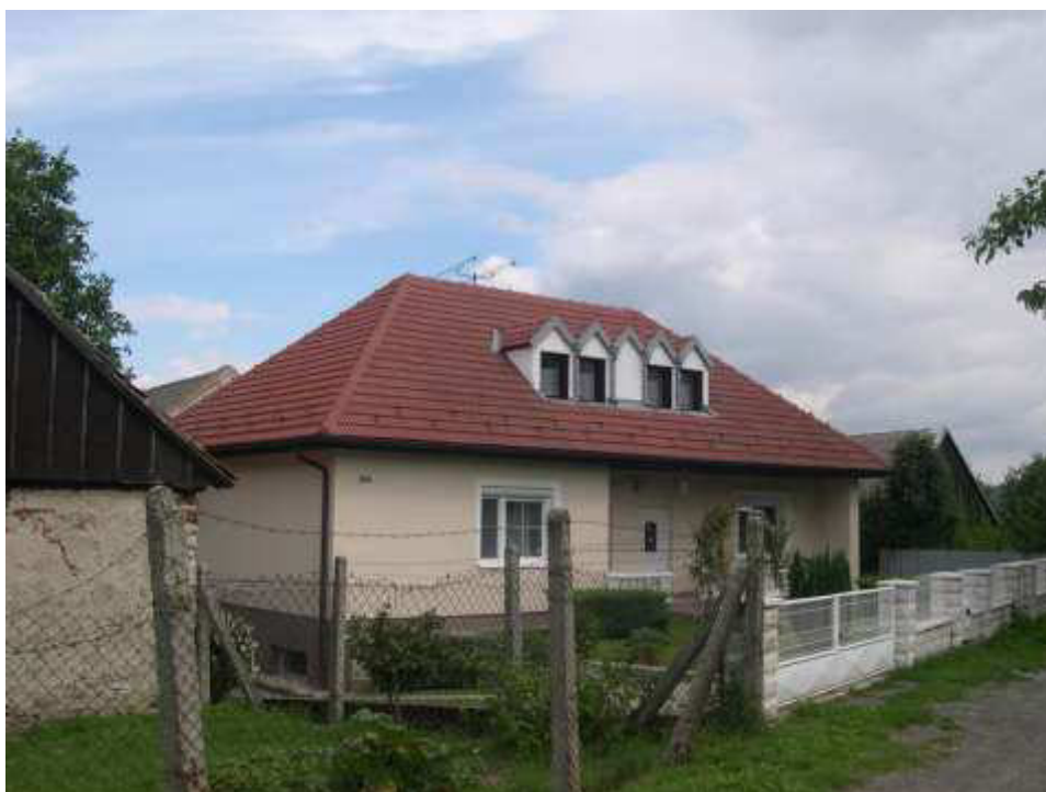
75. Rodinný dom súpisné č. 234 pri juhozápadnej hranici PRĽA, rušivý objekt v zástavbe PRĽA – pohľad od juhu
