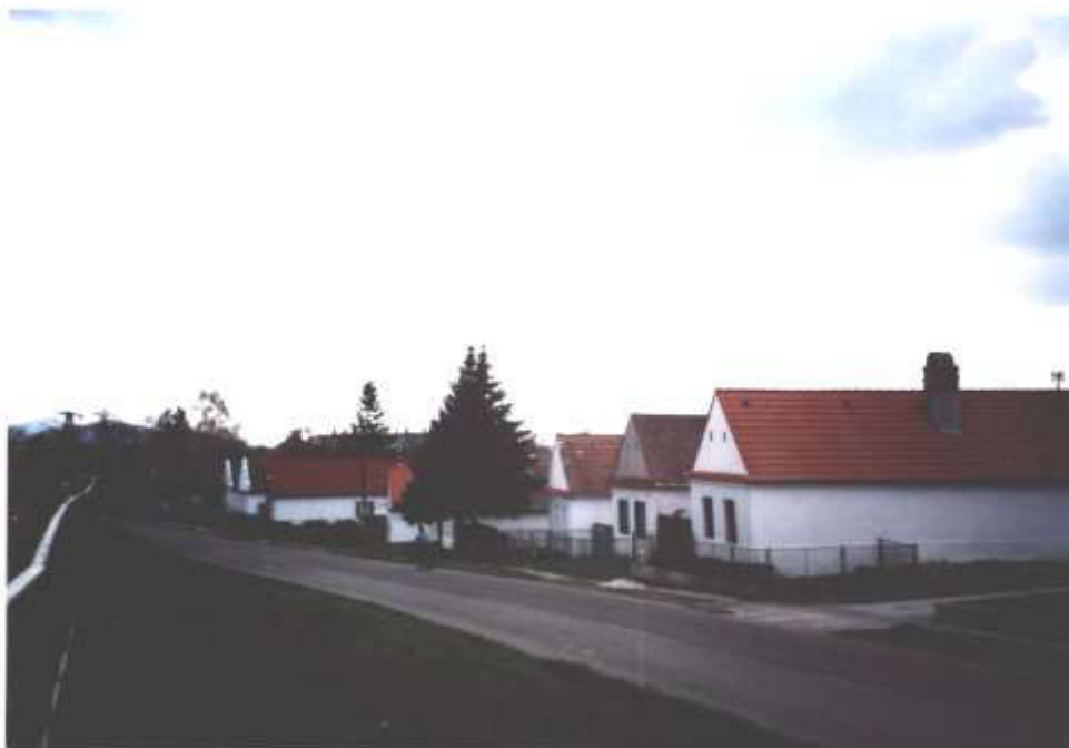
14. Západná časť severozápadného domoradia - pohľad od východu
