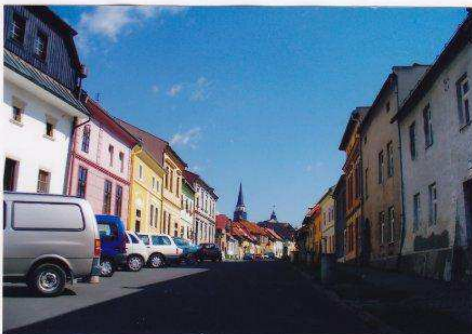
Levoča, Nová ulica – pohľad od juhu od domu č.55.
