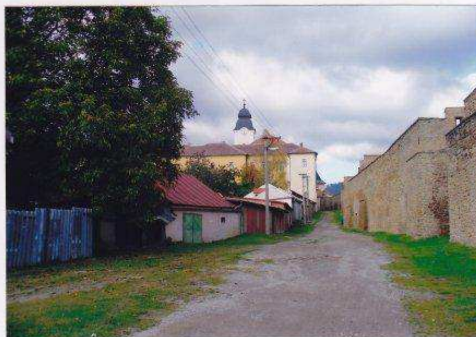
Východný úsek hradbového múra mestského opevnenia.
