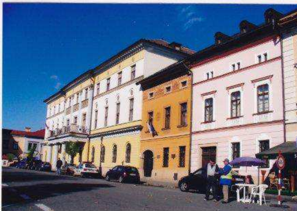
Dnešný pohľad na severné námestia. domoradie
