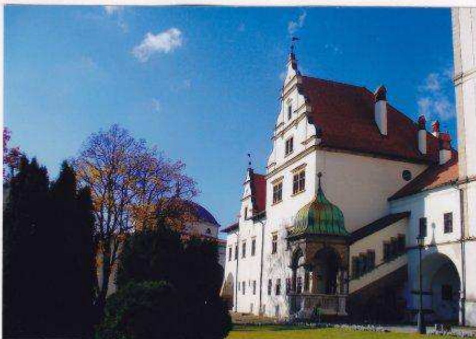
Pohľad v súčasnosti od severu na juhovýchodnú centrálnu časť námestia – na mieste stánkov prerastá zeleň narúšajúca pohľady na pamiatkové objekty
