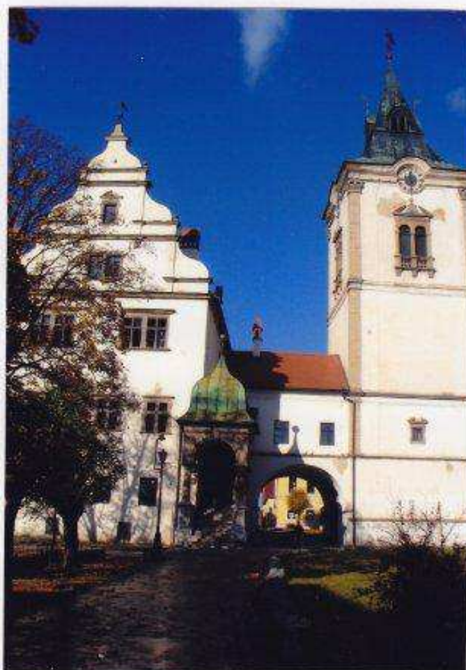
Súčasný pohľad na východnú fasádu radnice, v popredí neutržiavaná zeleň prerastlá stromami
