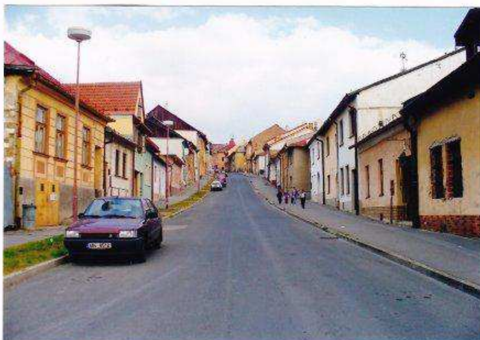
Radová zástavba domov Vysokej ulice – pohľad od juhu zo Žiackej ulice.
