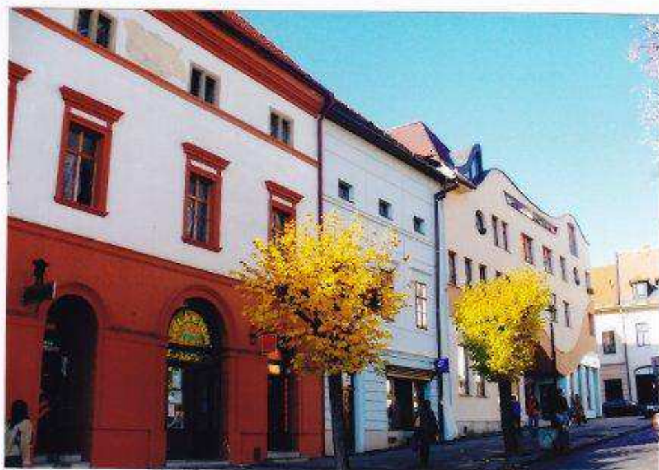
Pohľad súčasný na južnú časť námestia od SV s domami č.37, 38, 39 a na pravej strane s domoradím západnej strany námestia –na mieste domu č.39 realizovaná novostavba v súčasnom výraze. Domy č.37, 38 s obnovenými fasádami.
