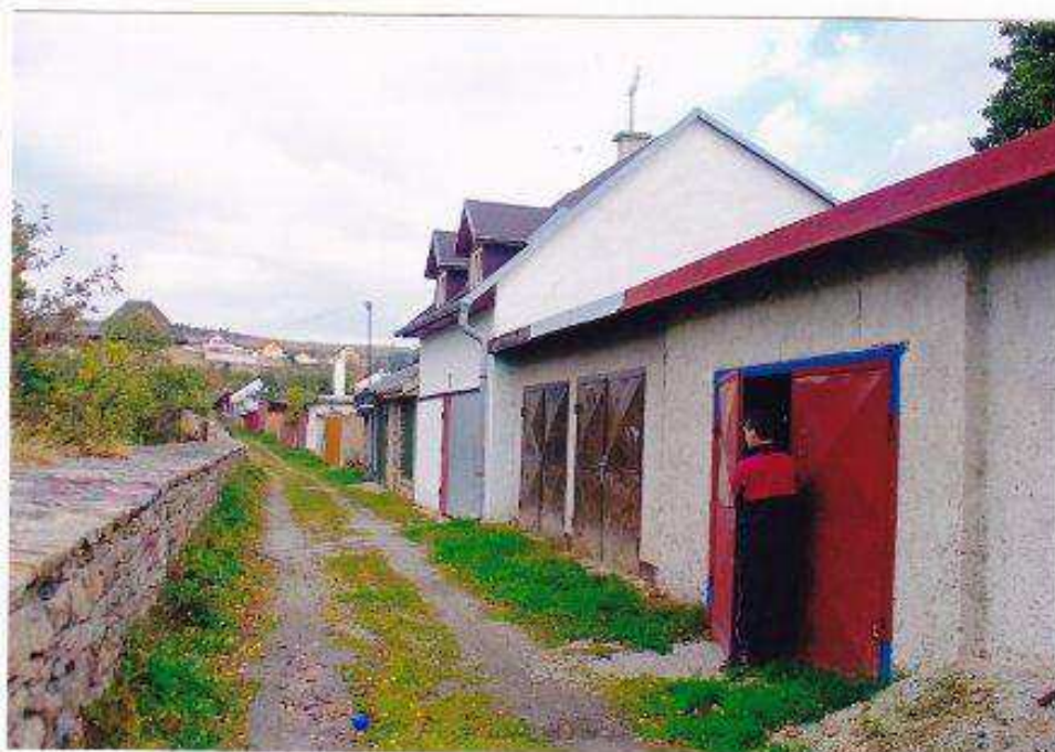
Pohľad na severnú časť Baštovej ulice s nevhodnou zástavbou garáží.
