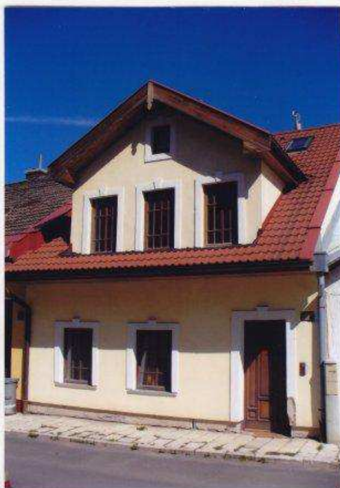
Nevhodná nadstavba domu na Ružovej ulici č.8.
