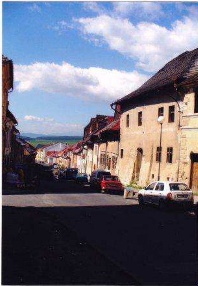
Nová ulica – pohľad od severu – na západnej strane dom č.75 prekrytý strechou so spišským debneným štítom s podlomenicou so šindľovou krytinou, fasáda s klasicistickými výplňami.
