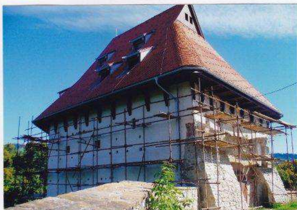
Bašta Pracháreň počas rekonštrukcie.
