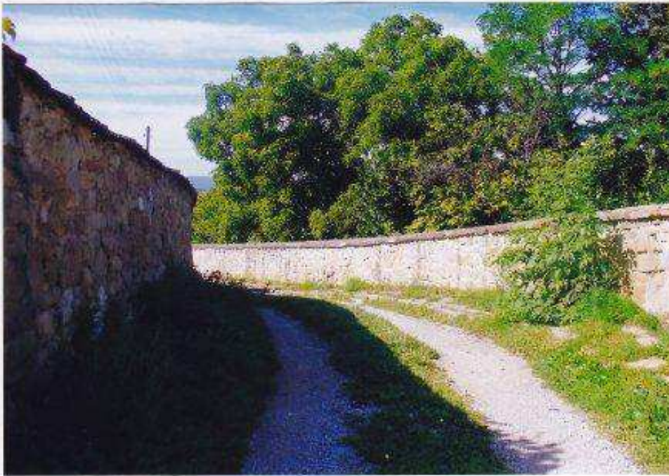
Severozápadné nárožie mestského opevnenia z interiéru.
