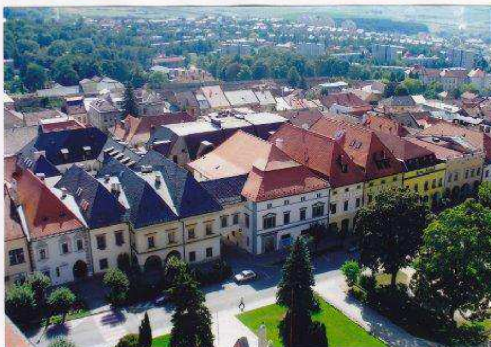
Pohľad z veže kostola na východnú stranu námestia. Prekrytie domov s prevládajúcou valbovou strechou a škridlou. Nevhodné prestrešenie domov č.26 a 27.
