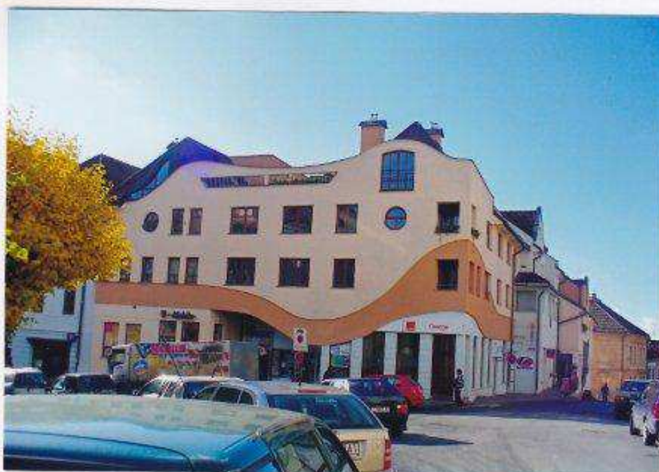
Novostavba polyfunkčného domu v nároží Novej ulice a Námestia Majstra Pavla.
