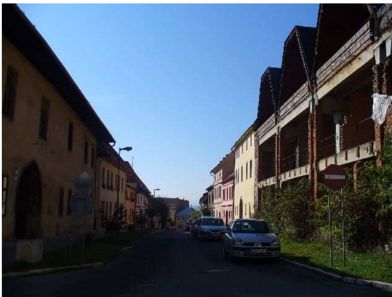
Mäsiarska ul. pohľad od S na J časť 2
