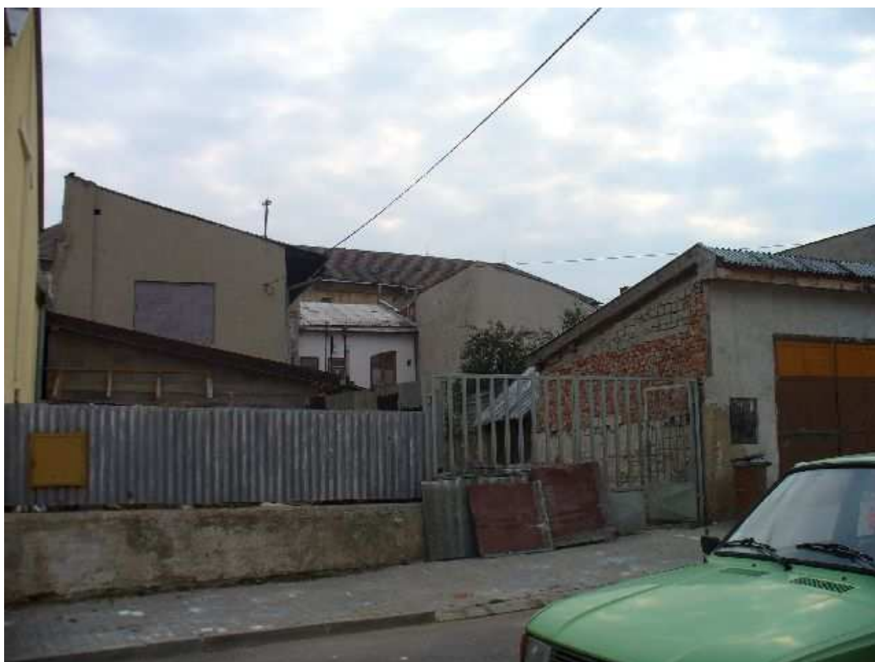
Kláštorská SV časť oplotenie, garáž
