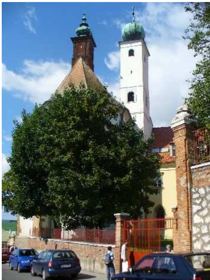
Kláštorská 38 - oplotenie kláštora
