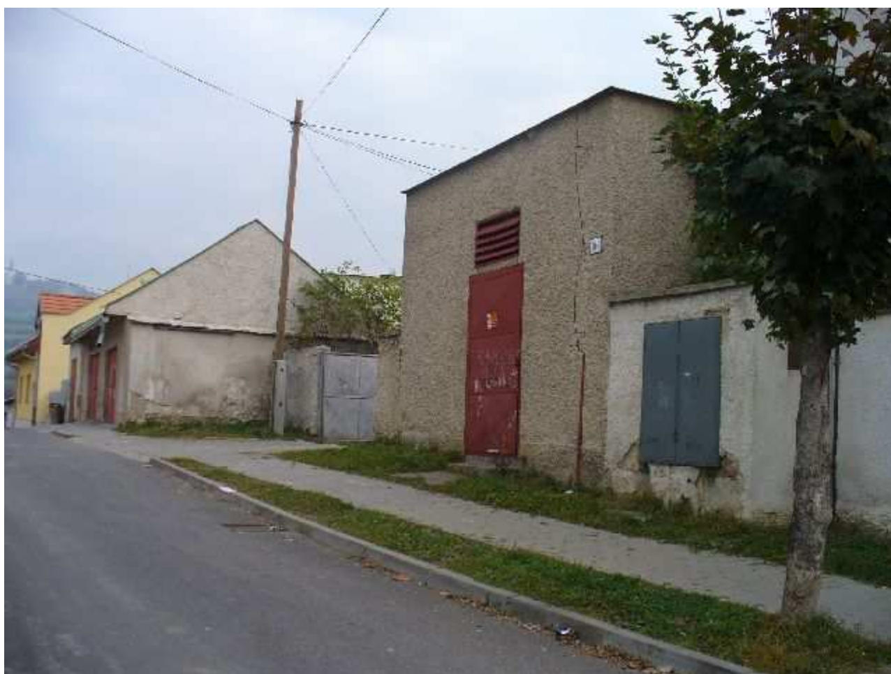
Kláštorská ul. pohľad z Uholnej na SV časť
