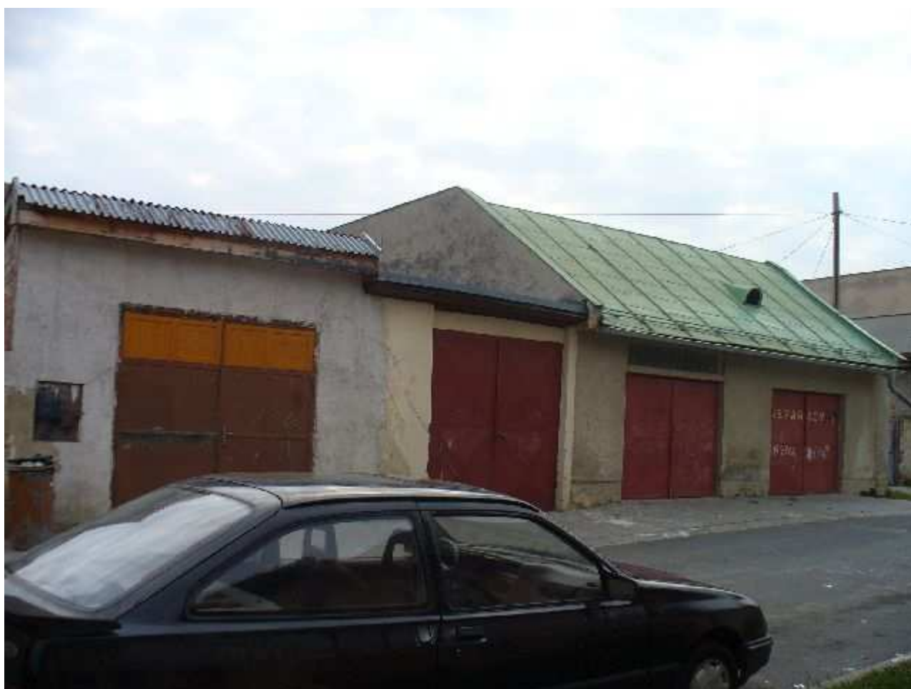
Kláštorská SV časť garáže
