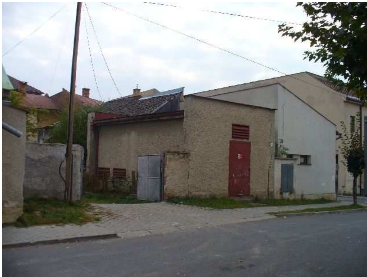
Kláštorská SV časť nárožie s Uholnou ul.
