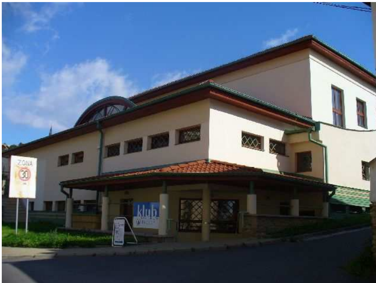
Kasárenská ul. novostavba telocvičny v SV časti
