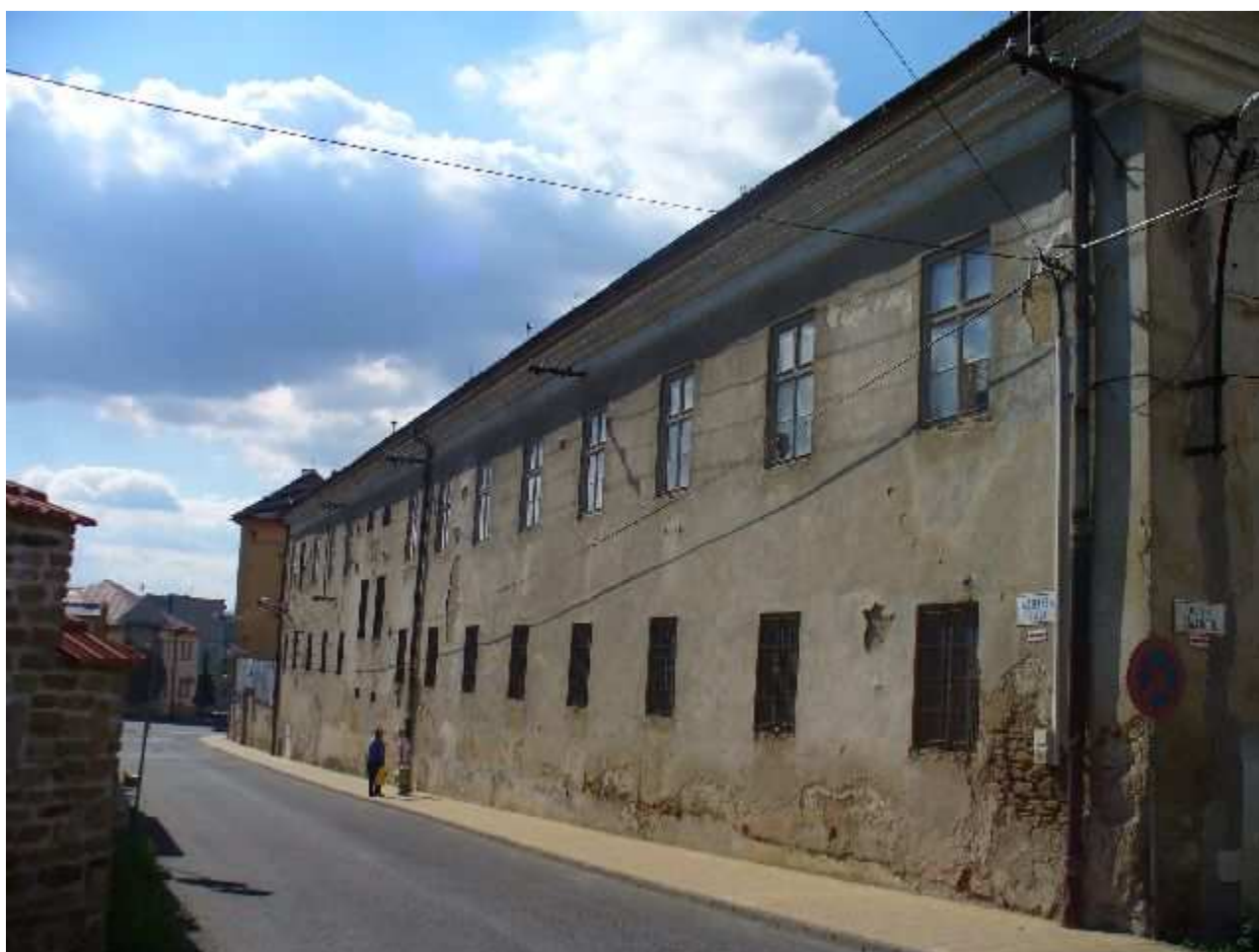
Kasárenská ul. - JV část pohľad od západu
