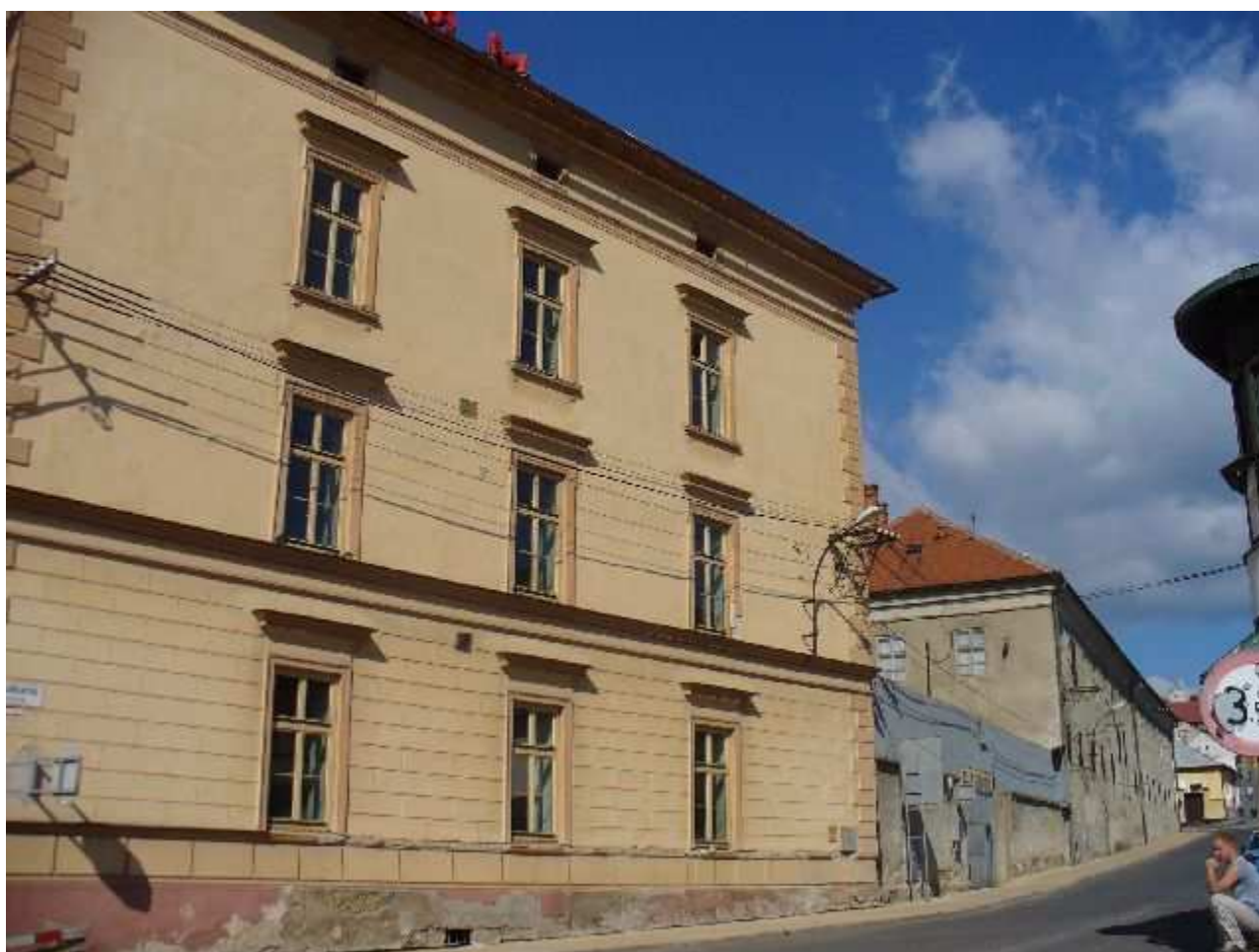
Kasárenská ul. JV časť pohľad od východu
