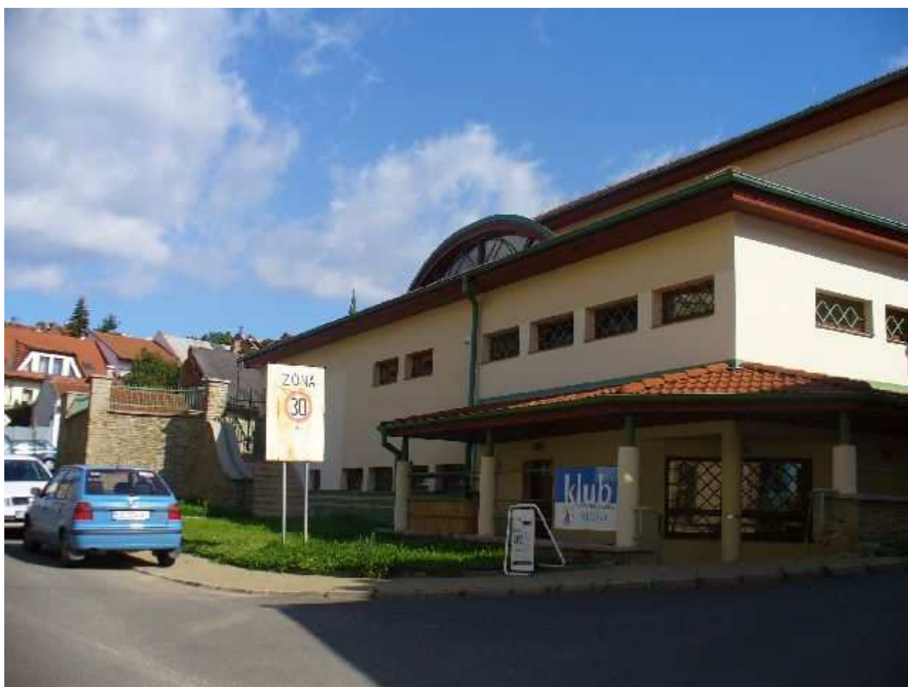
Kasárenská ulica novostavba telocvične v SV časti
