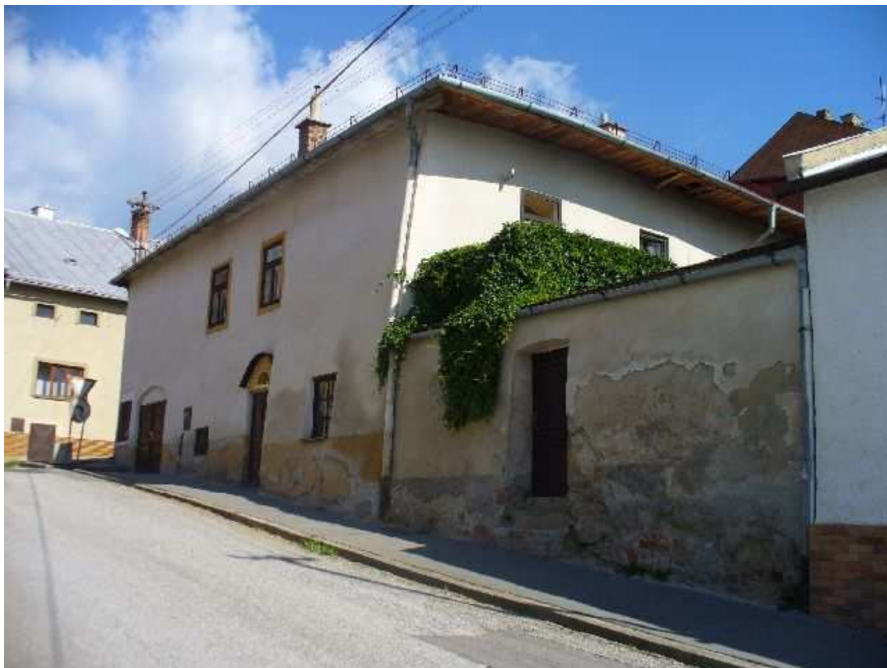
Kasárenská - fasáda a oplatenie domu na Vyskej 29
