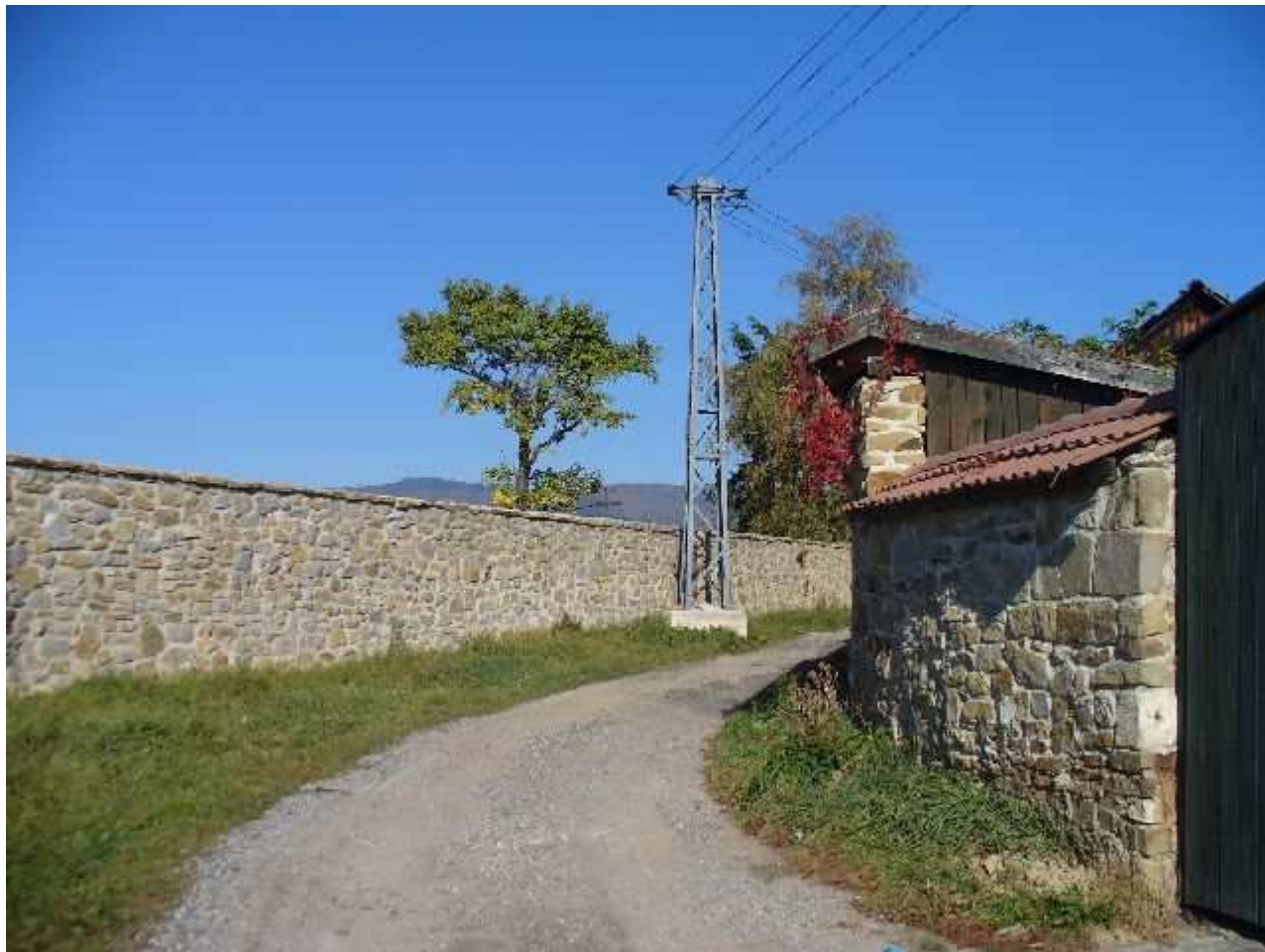
Baštová južná časť 4
