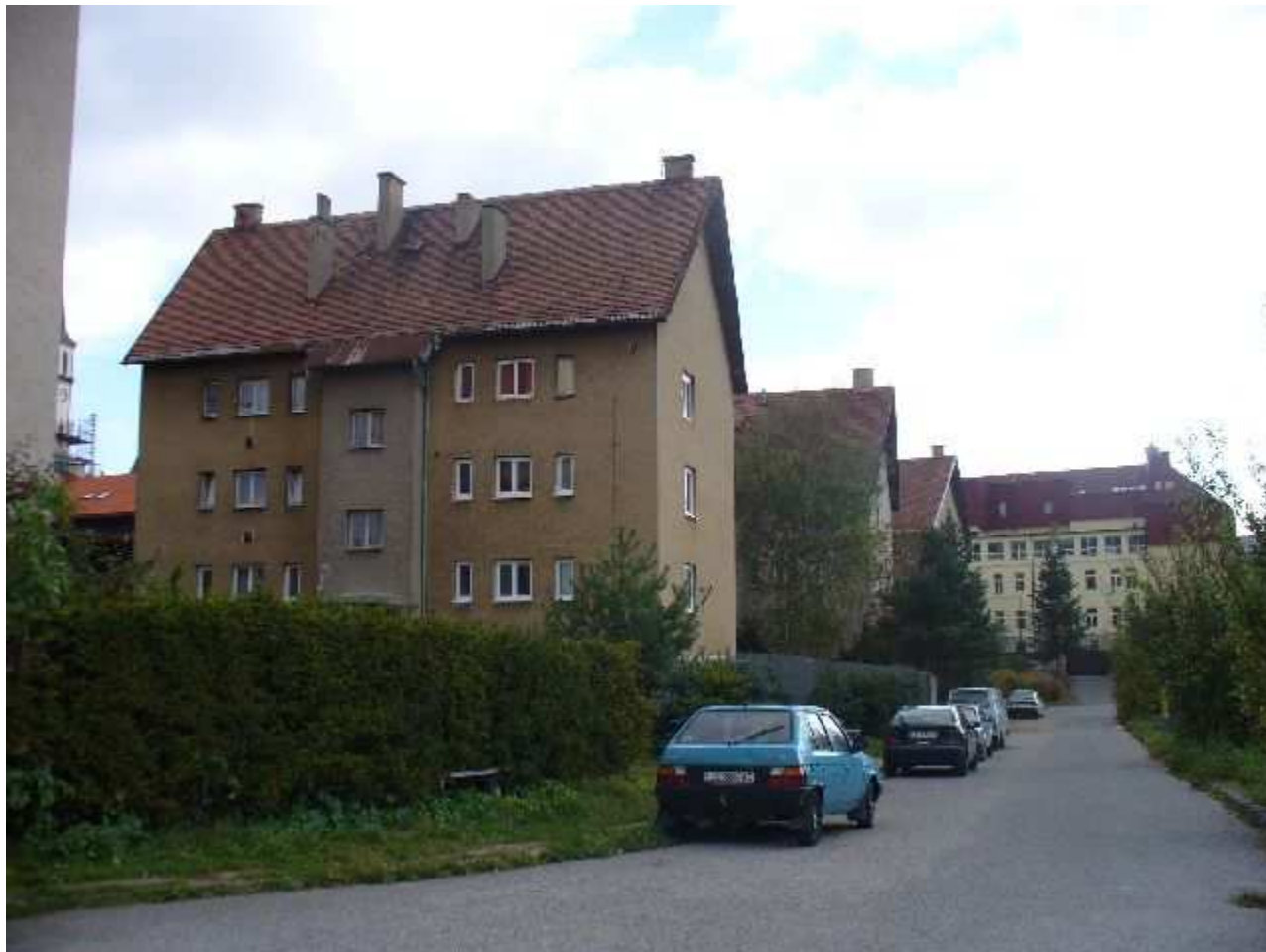
Baštová západná časť pohľad S na bytovky
