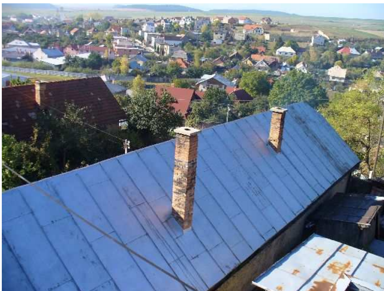
Baštová JZ časť pohľad na priekopu so zástabou
