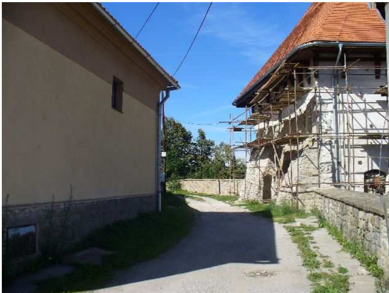
Baštová ulica pri prachárni
