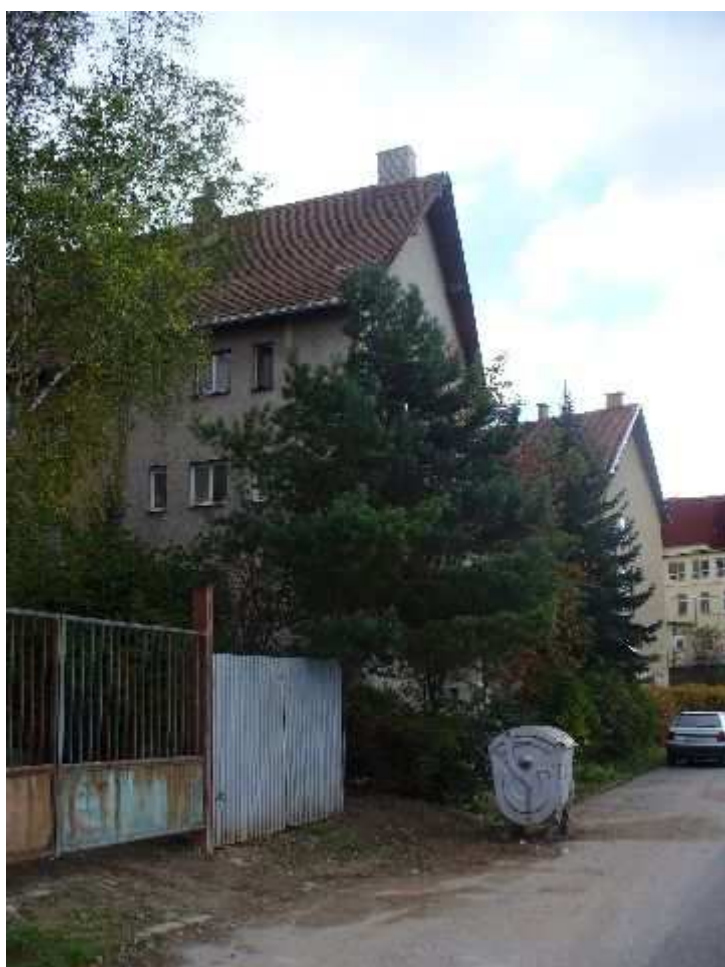
Baštová bytovky na západnej strane
