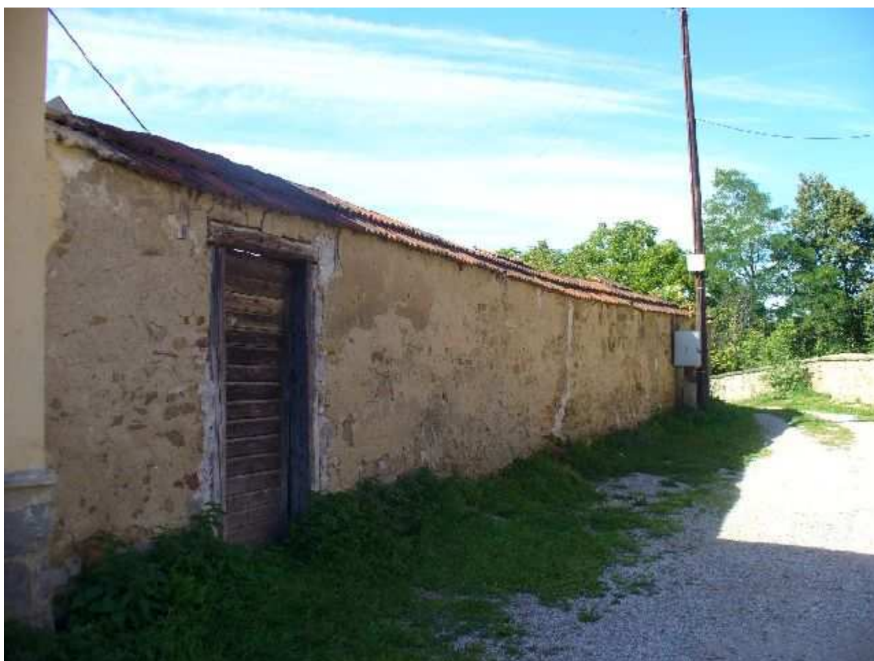
Baštová ul. - severozápadná časť
