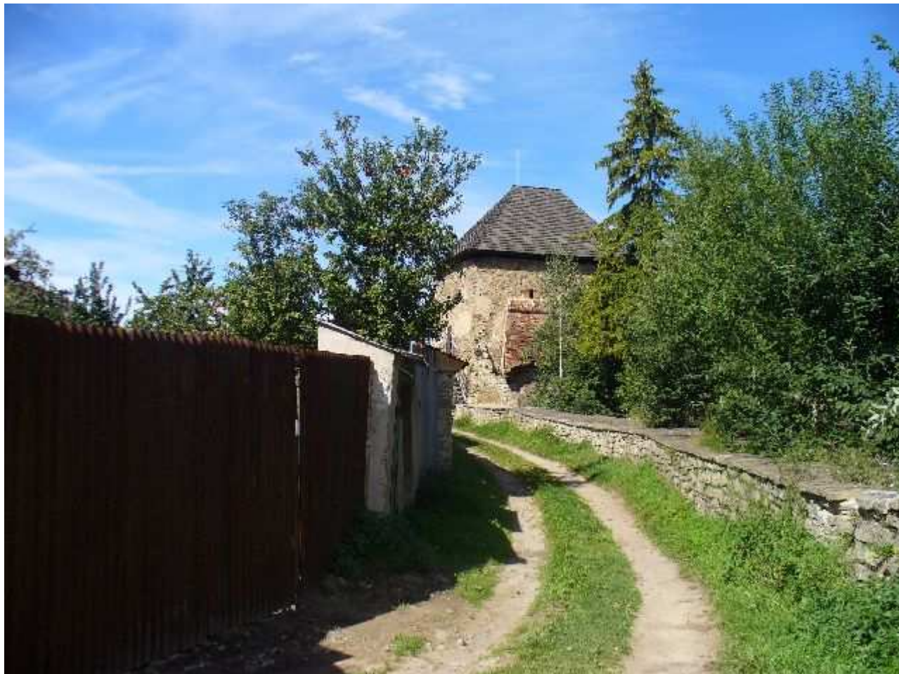
Baštová - východná časť
