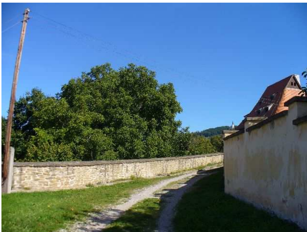
Baštová ul. SZ část pohľad od juhu
