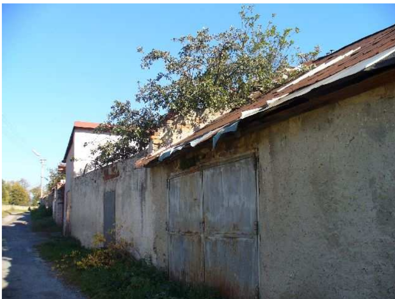
Baštová južná časť 3
