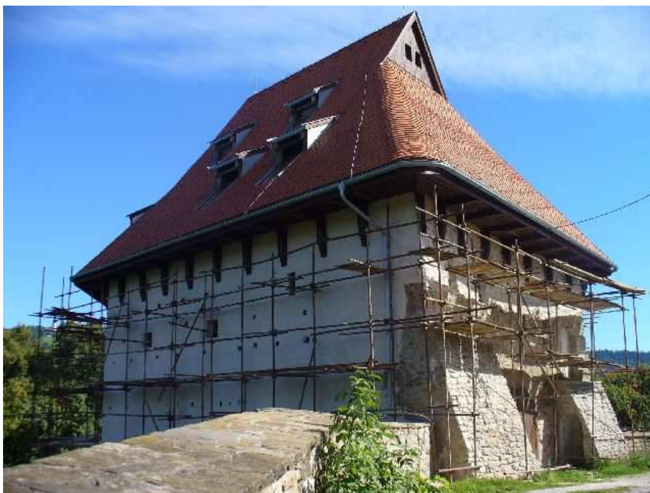
Baštová pracháreň od západu
