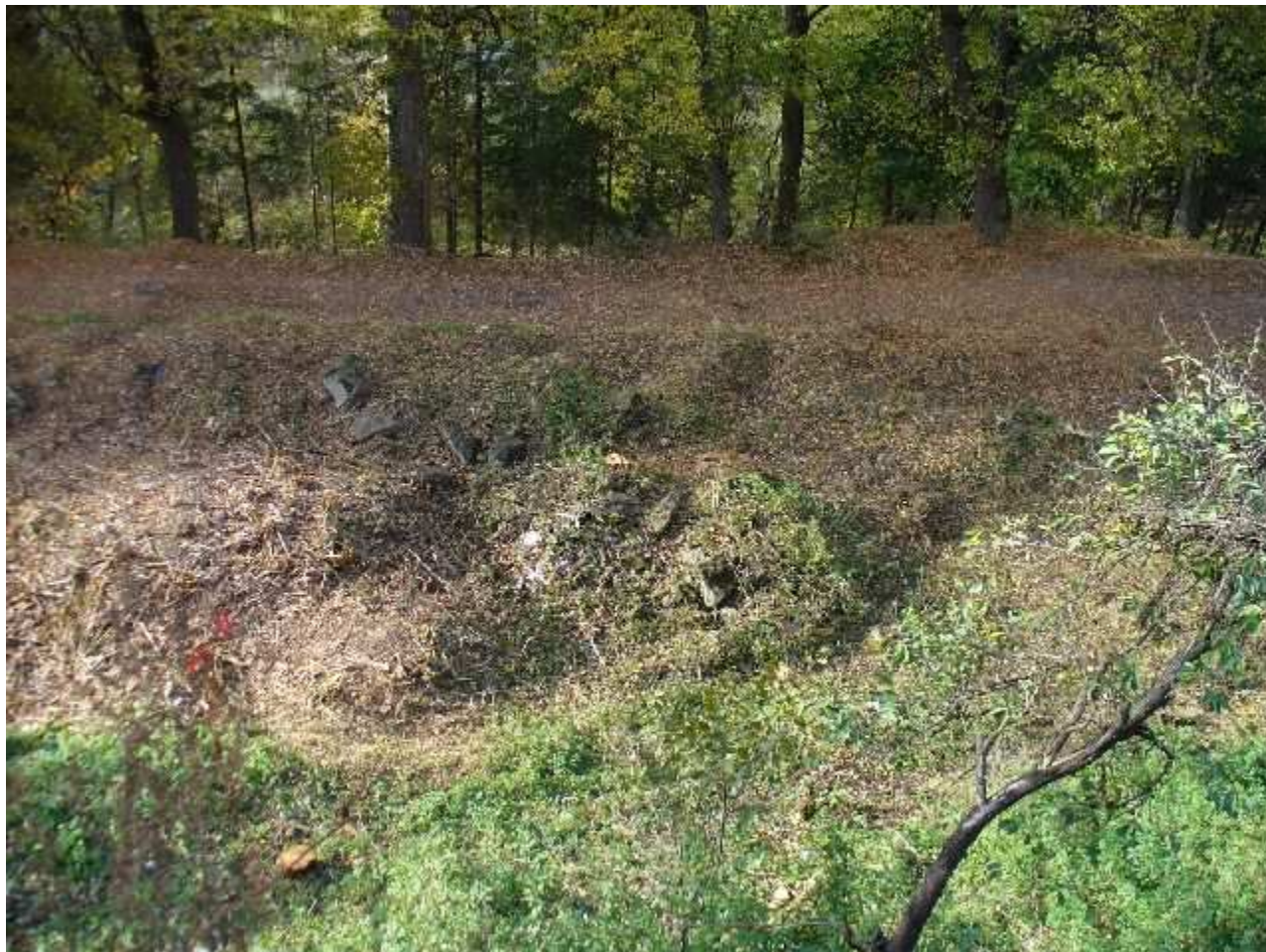
Baštová západná strana pohľad do hradobnej priekopy
