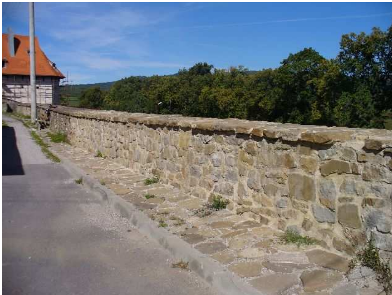
Baštová ulica - severná časť
