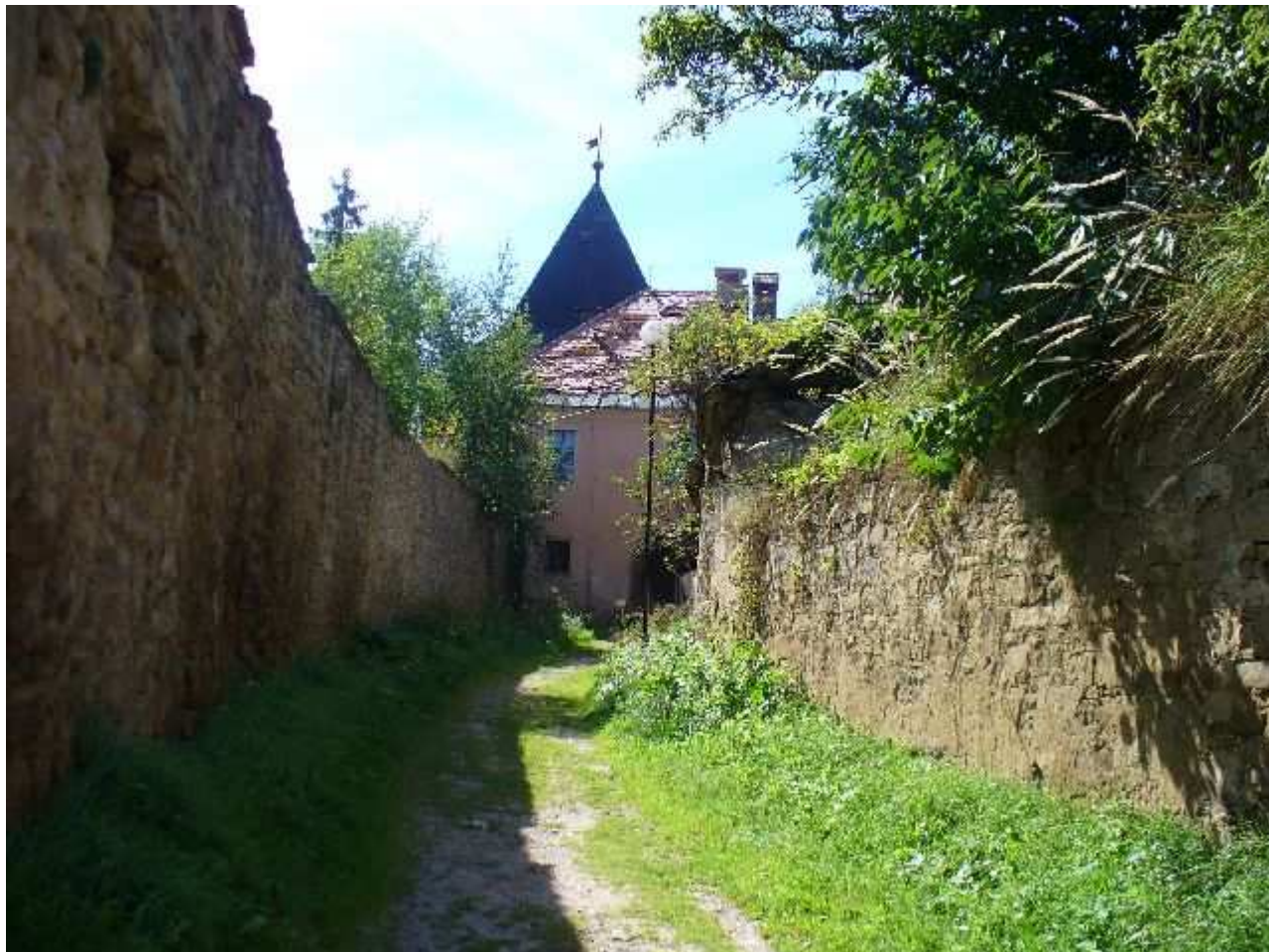
Baštová - severovýchodná časť ku Košickej ulici
