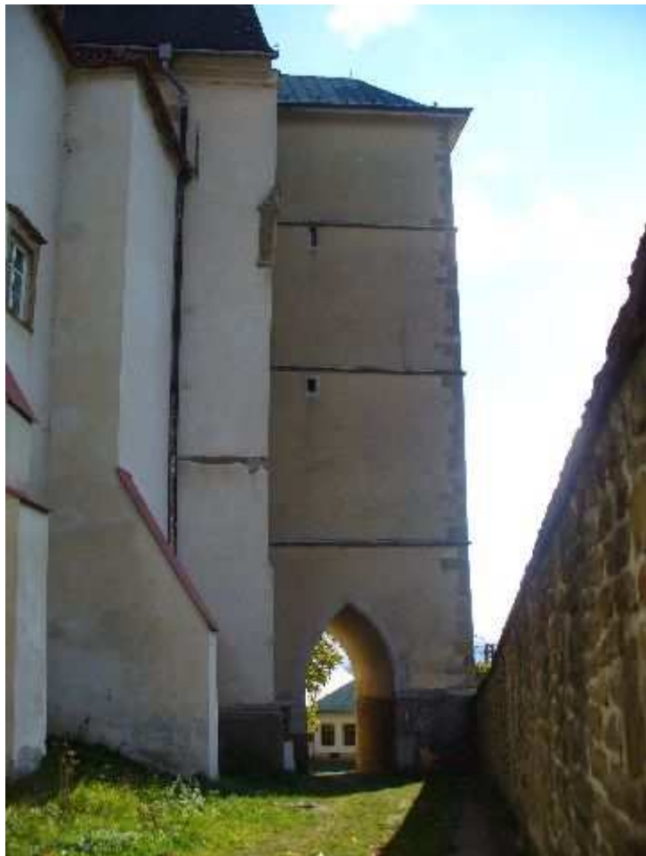
Baštová pohľad od S na poľskú bránu
