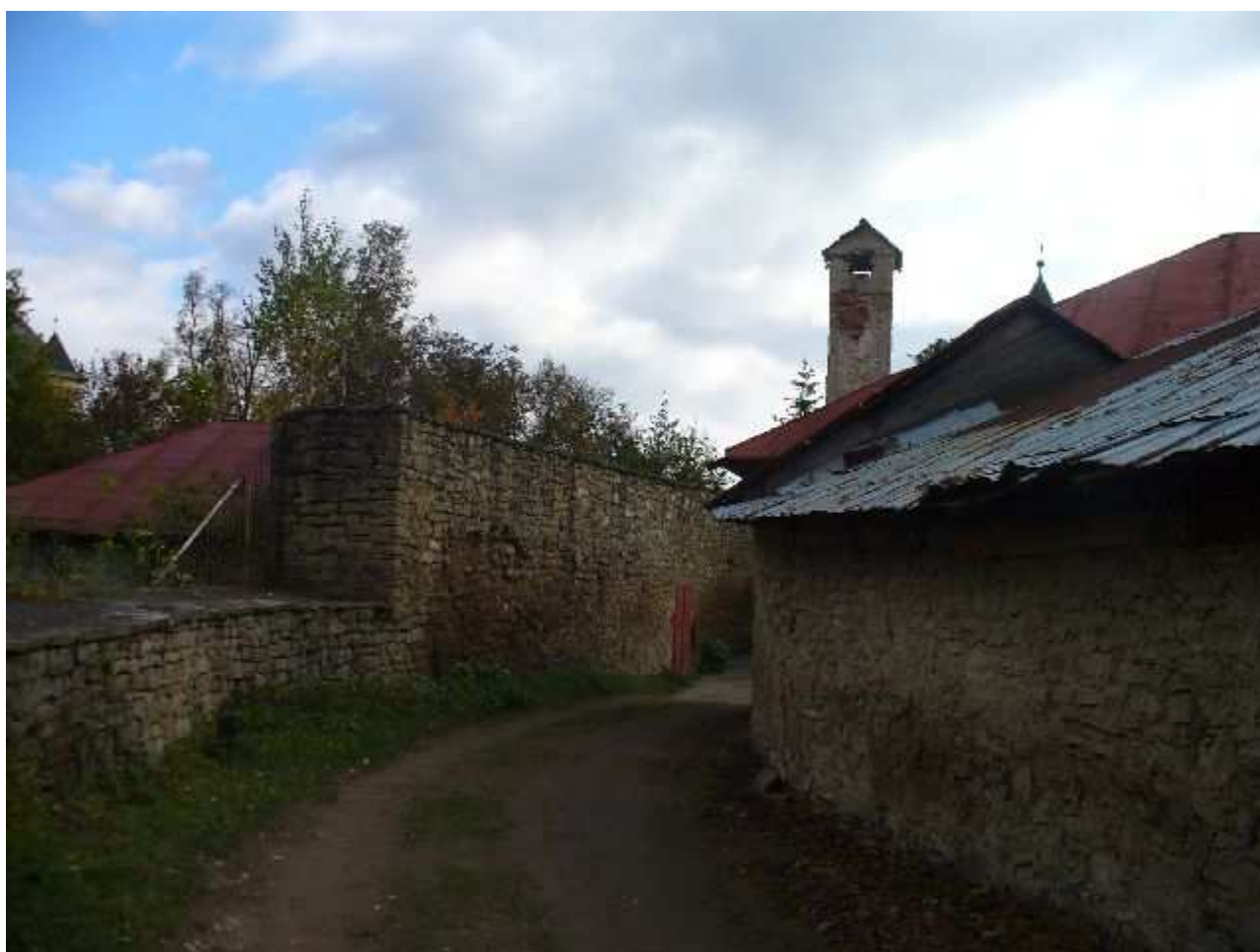
Baštová SV časť pohľad od S
