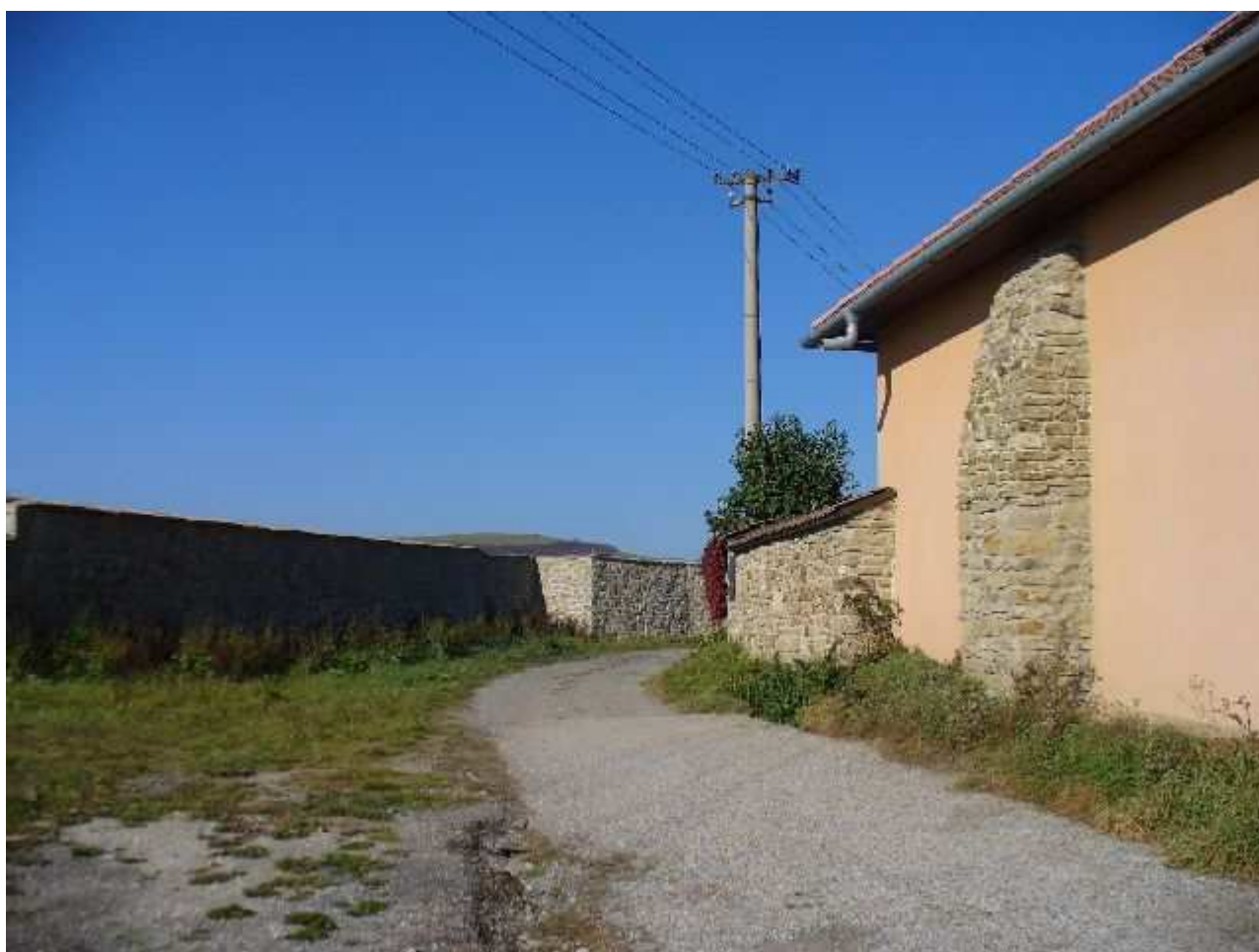
Baštová južná časť 5
