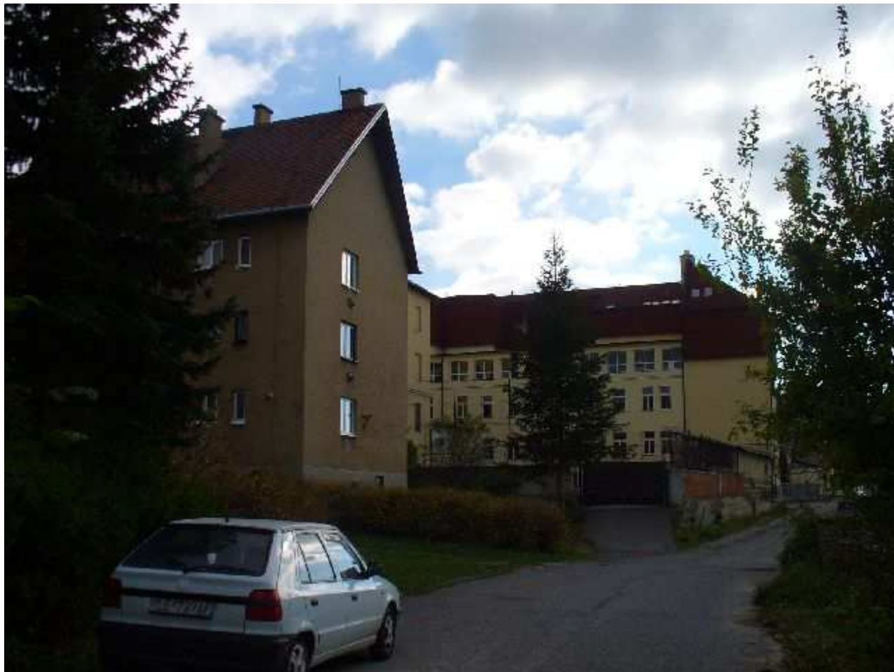
Baštová západná časť bytovka a škola Kláštorská 24
