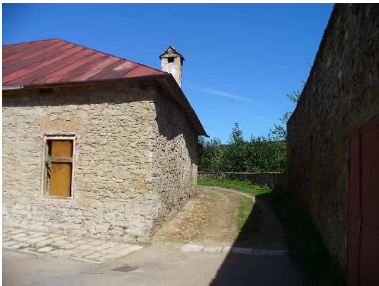
Baštová - severovýchodná časť
