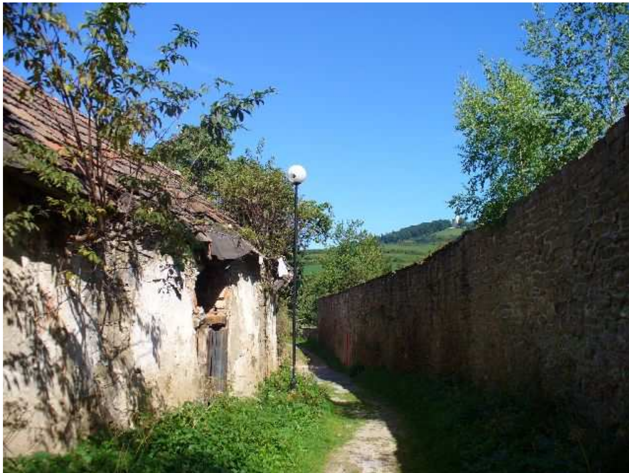
Baštová - východná časť
