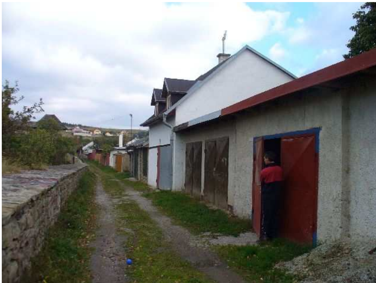
Baštová severná časť pohľad od Z na južnú časť ulice
