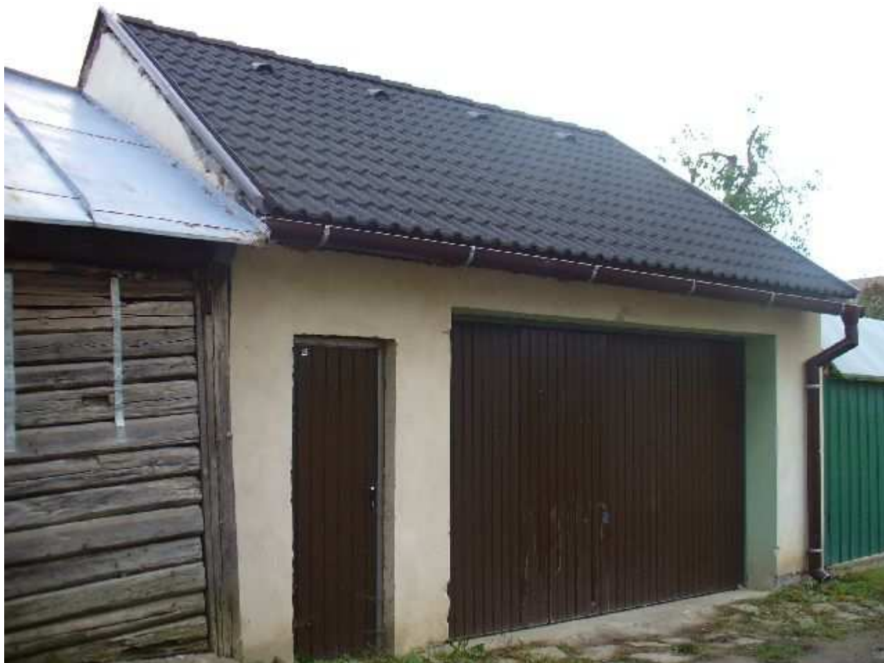
Baštová severná časť garáže na južnej strane 2
