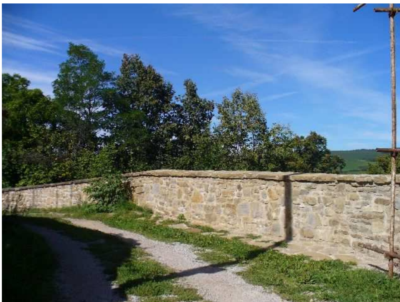
Baštová ul. severozápadná časť 2
