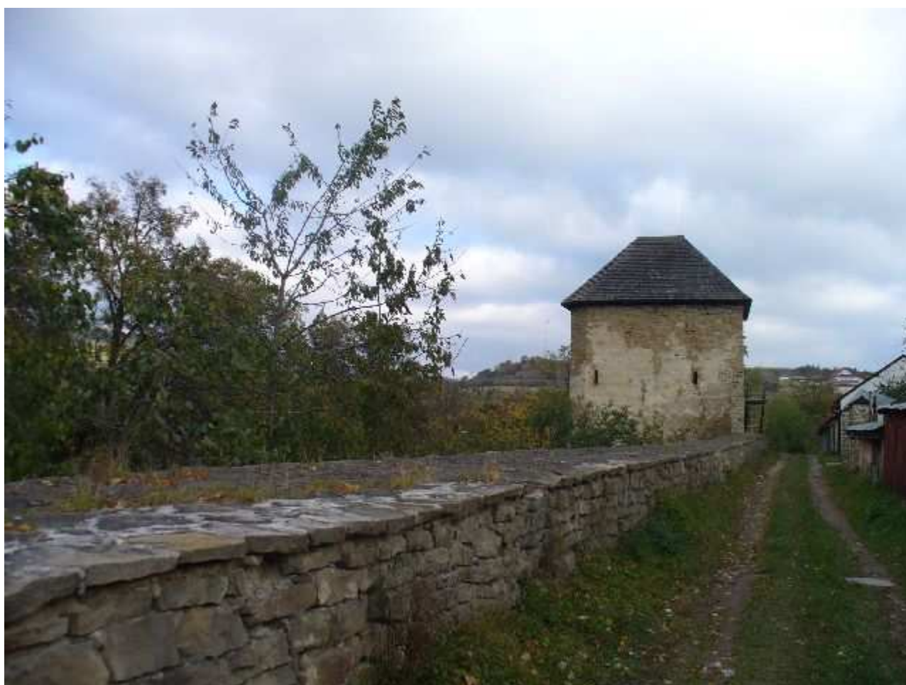
Baštová severná časť pohľad od západu na baštu
