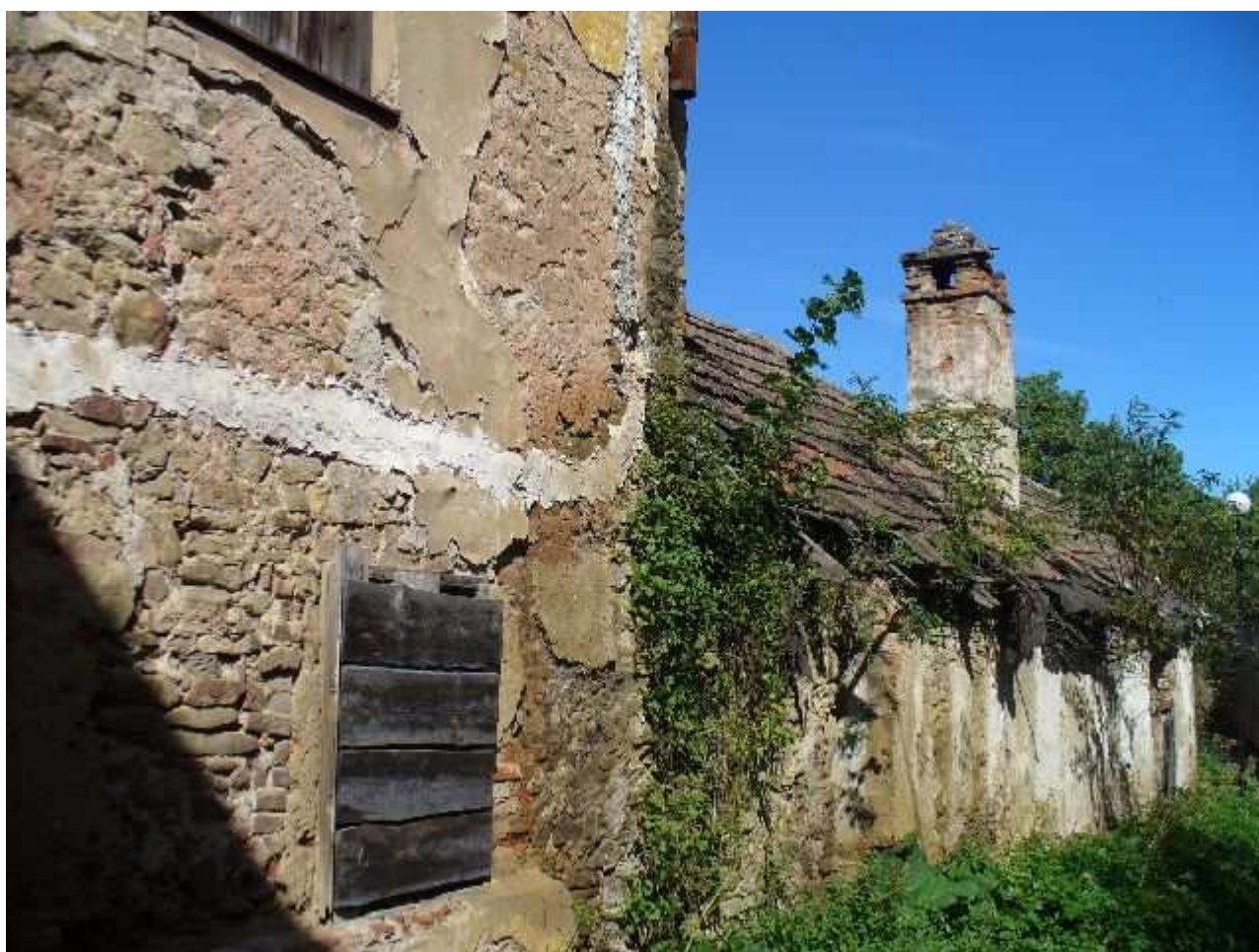
Baštová - východná časť 2
