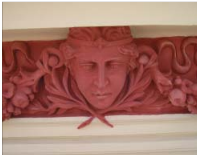
Mlynská 25, detail fasády po reštaurovaní
