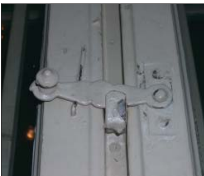
Krmanova ulica 8, detail okenného obrtlika
