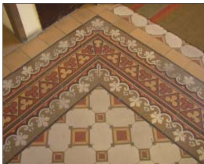
Železničné riaditeľstvo, keramitová dlažba
