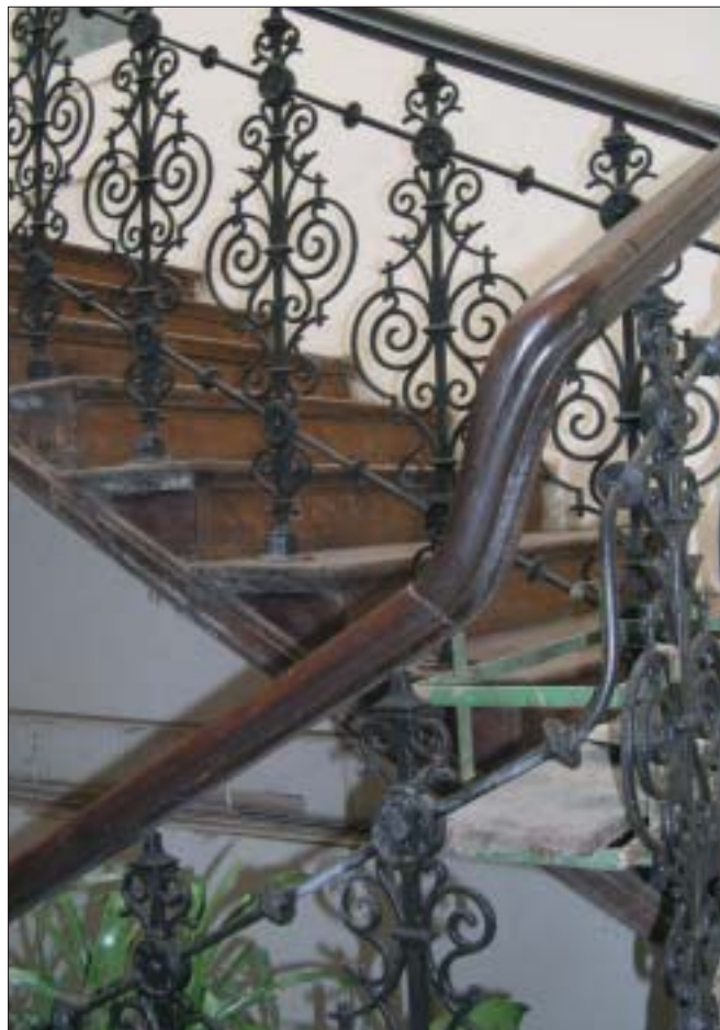
Detail liatinového zábradlia s dreveným madlom
