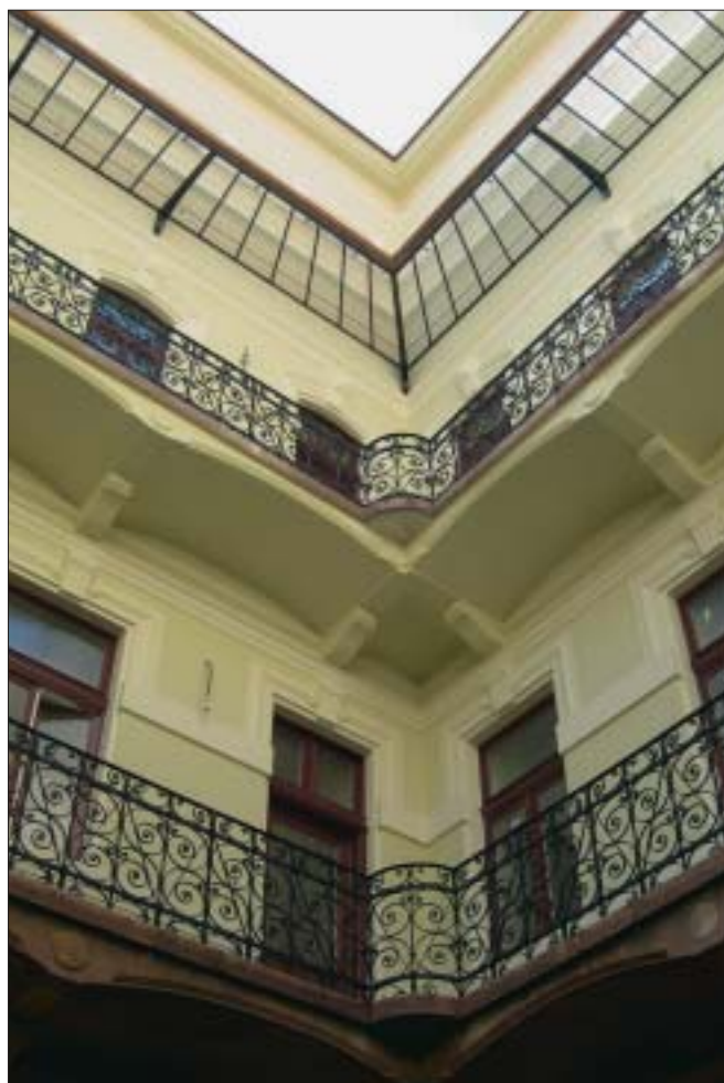
Kováčska 40, pavlač po obnove
