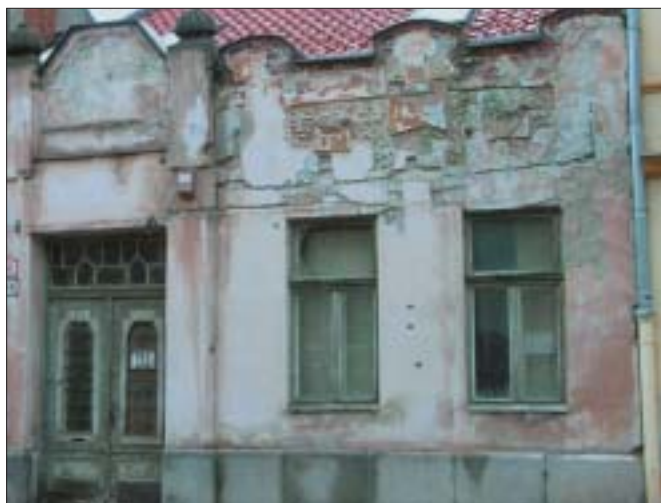
Mäsiarska 48, fasáda pred reštaurovaním
