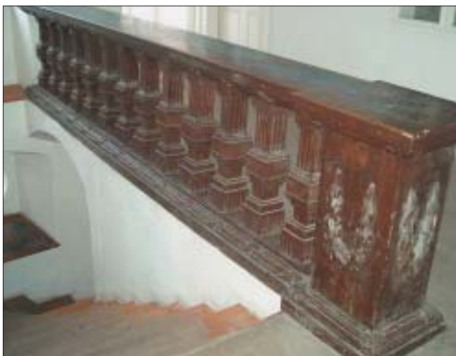
Mäsiarska ulica 7, drevené zábradlie
