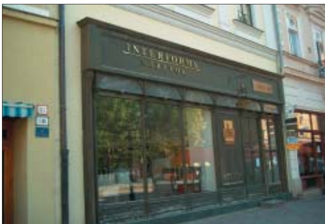
Hlavná 49, vhodná úprava parteru
