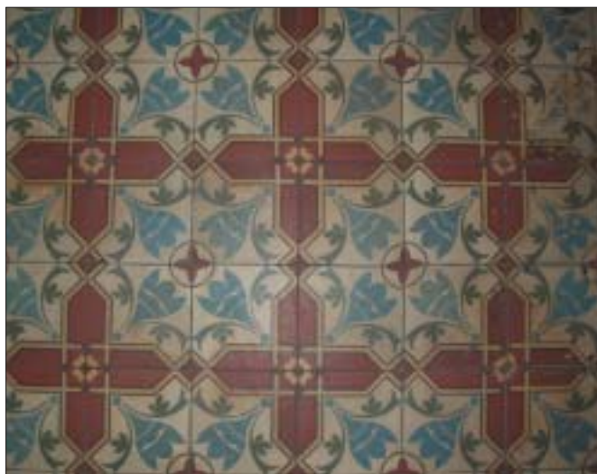
Mlynská ulica, keramitová dlažba
