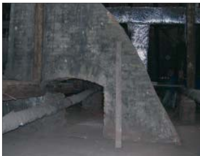
Hlavná 16, komínové teleso v podkrovi
