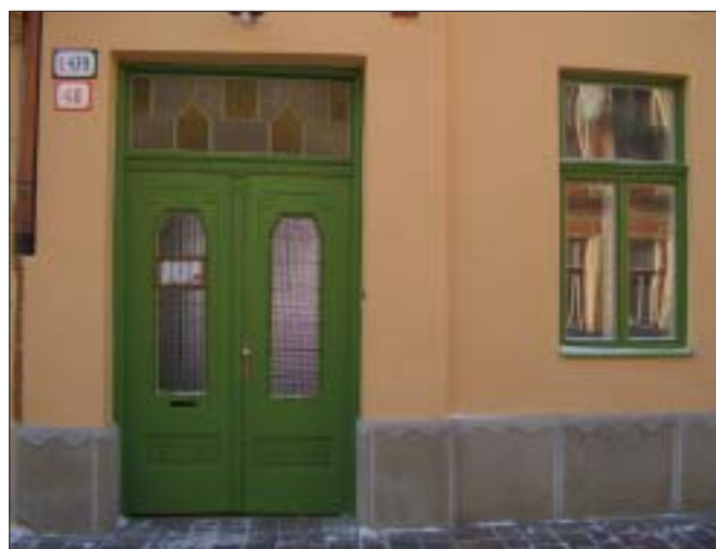
Mäsiarska 48, brána a okná po reštaurovaní
