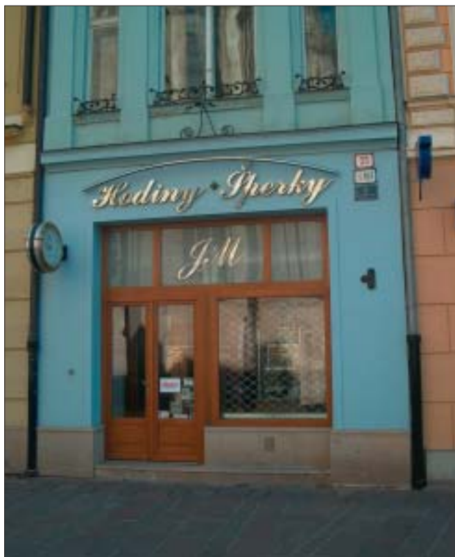
Hlavná 33, vhodná úprava parteru
