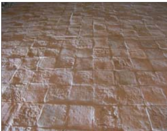
Mlynská ulica 25, tehlová dlažba z podkrovia
