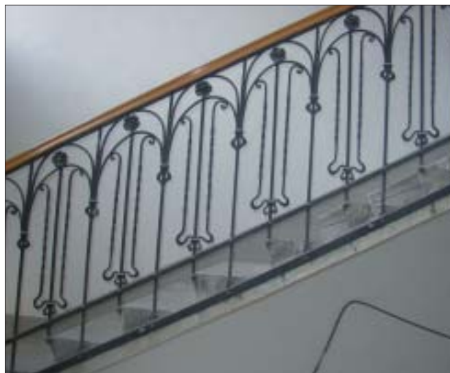
Tajovského ulica 9, detail schodiska
