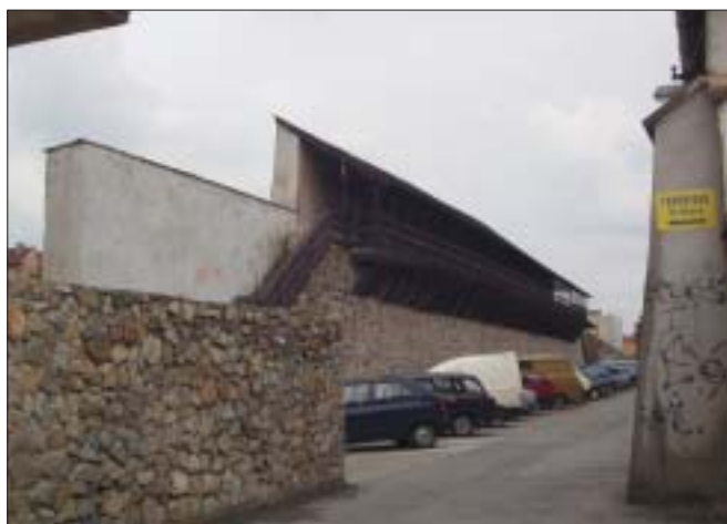
Hradbová ulica od strany mesta, pohľad na rekonštrukciu časti mestského opevnenia
