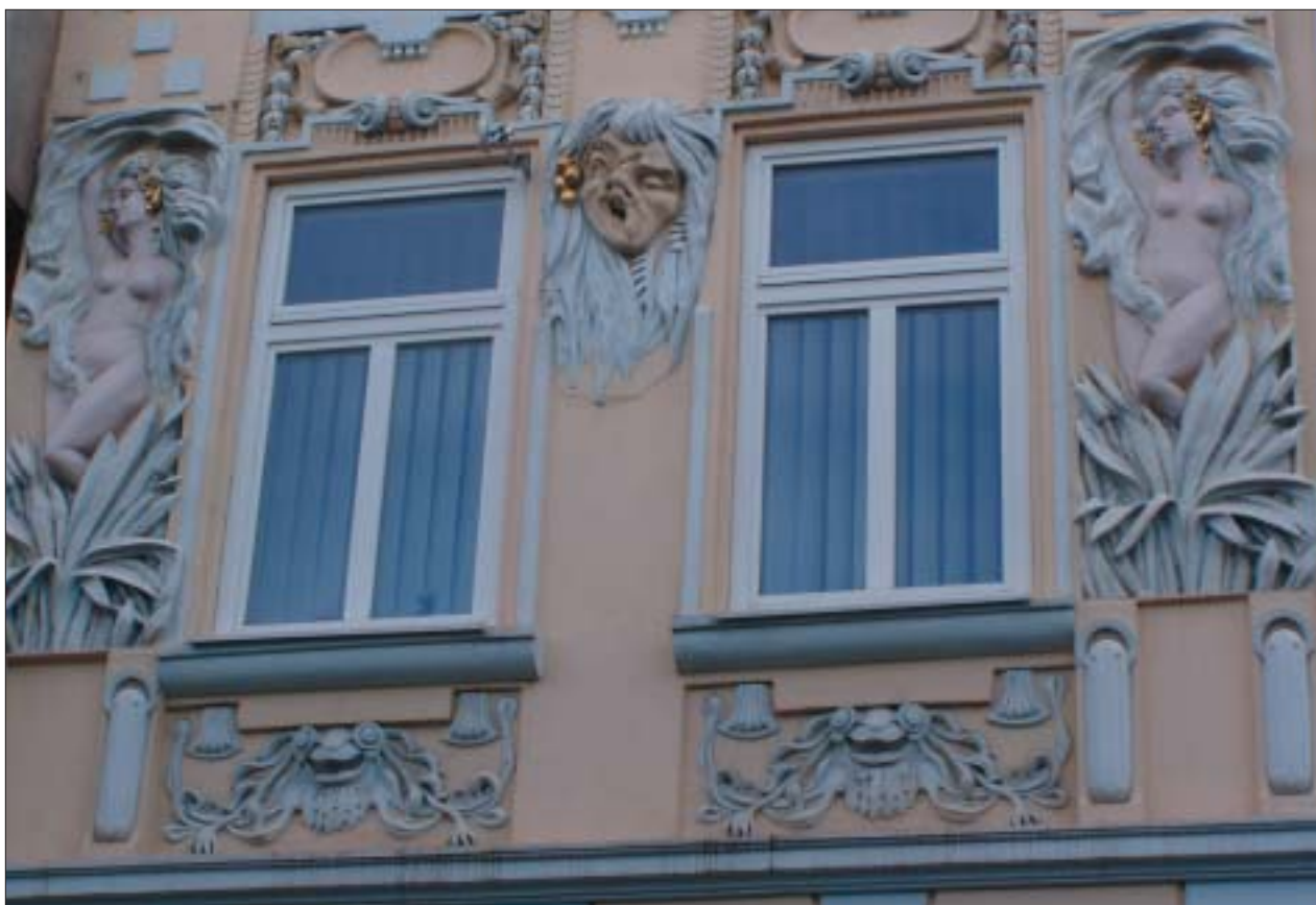
Štefánikova 42, detail secesnej fasády po obnove
