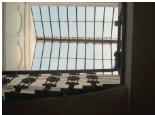
Hlavná 35, svetlík hlavného schodiska
