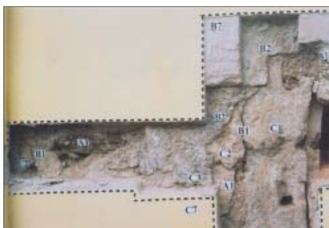
Hlavná 74, stratigrafia omietok a murív parteru
