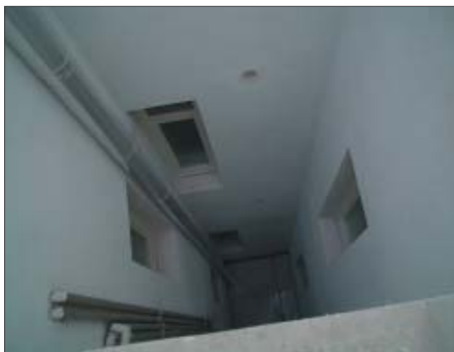
Pohľad do vetracej šachty
