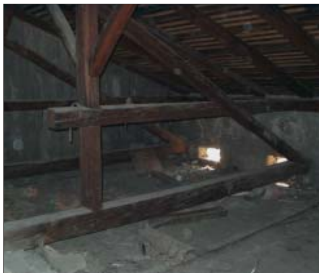
Hlavná 31, krov s vetracími otvormi do fasády
