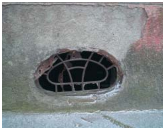
Drevený trh 1, secesný vetrací otvor suterénu s mriežkou
