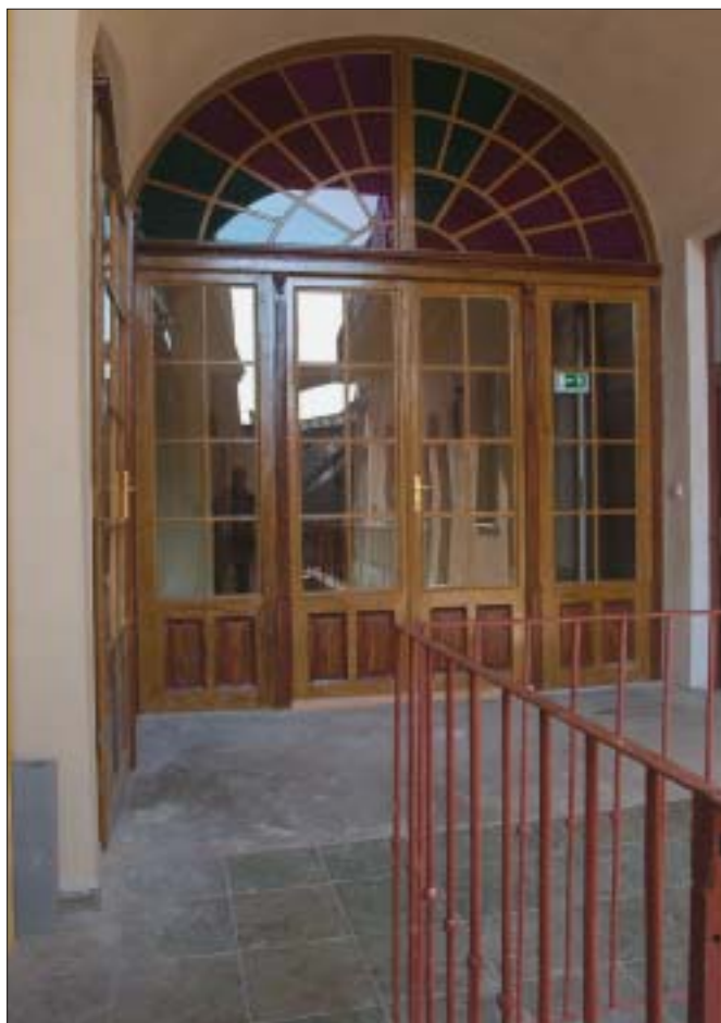
Mlynská ulica 25, presklená stena
