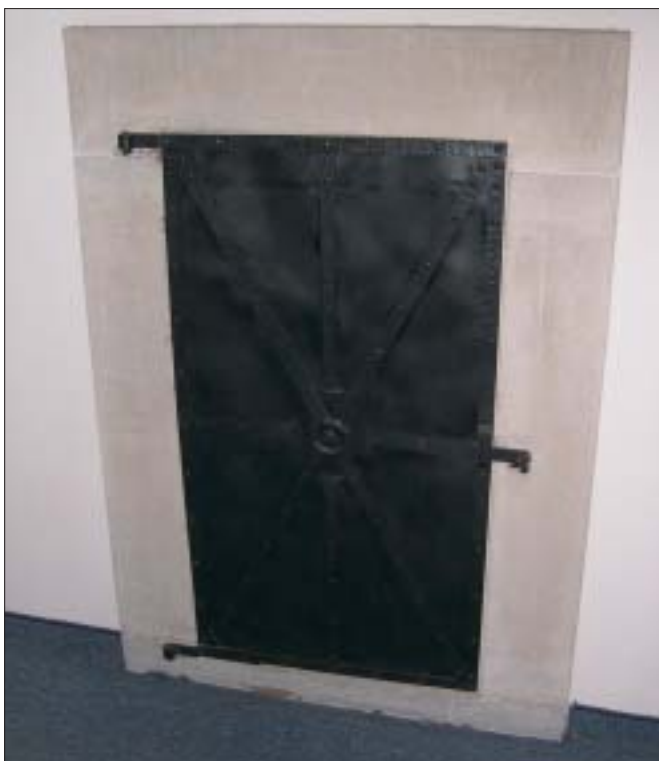
Kamenné ostenie vymetacieho otvoru v chodbe
