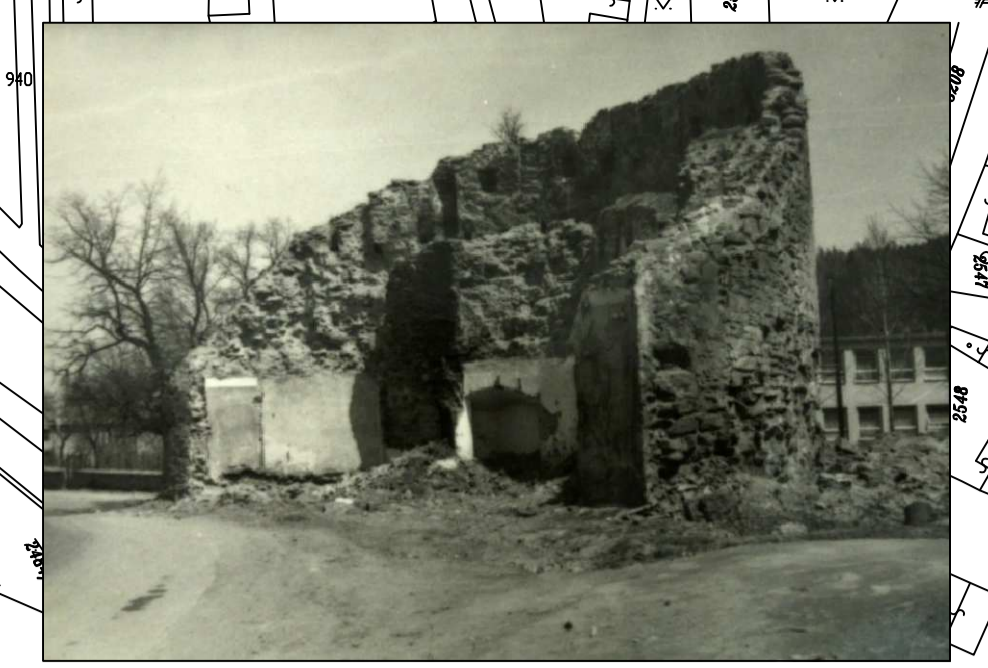
Rondel Nižnej vstupnej mestskej brány, r. 1966
