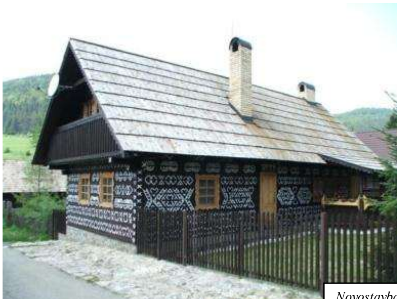
Novostavba domu č. 307 vhodne zapadla do prostredia.
