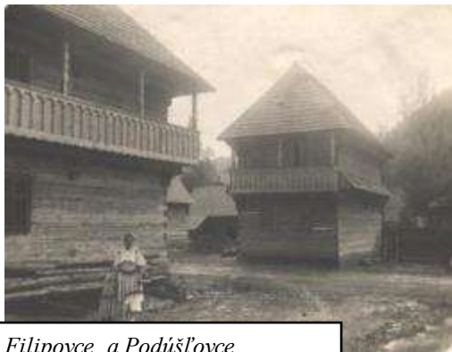
Filipovce a Podúšľovce v období výstavby po roku 1921.
