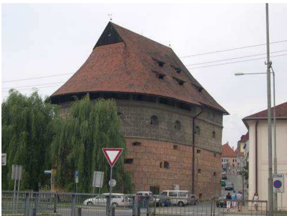
135. Pohľad na Hrubú baštu, r. 2006
