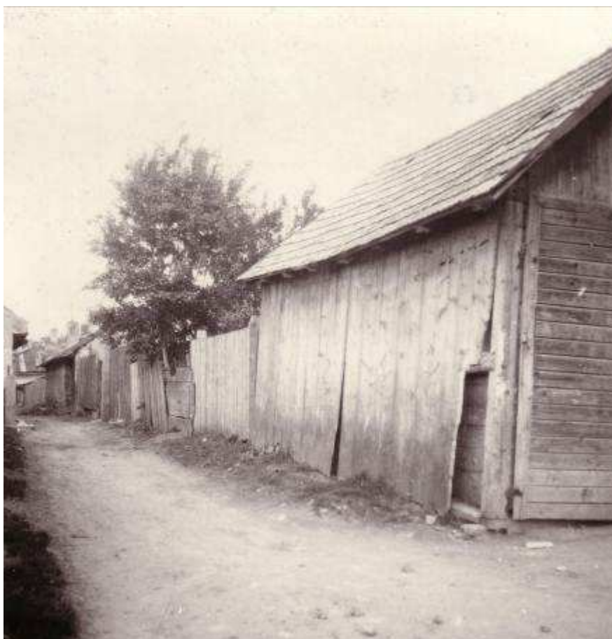
75. Ulica Na hradbách - severná časť od západu, r. 1960
