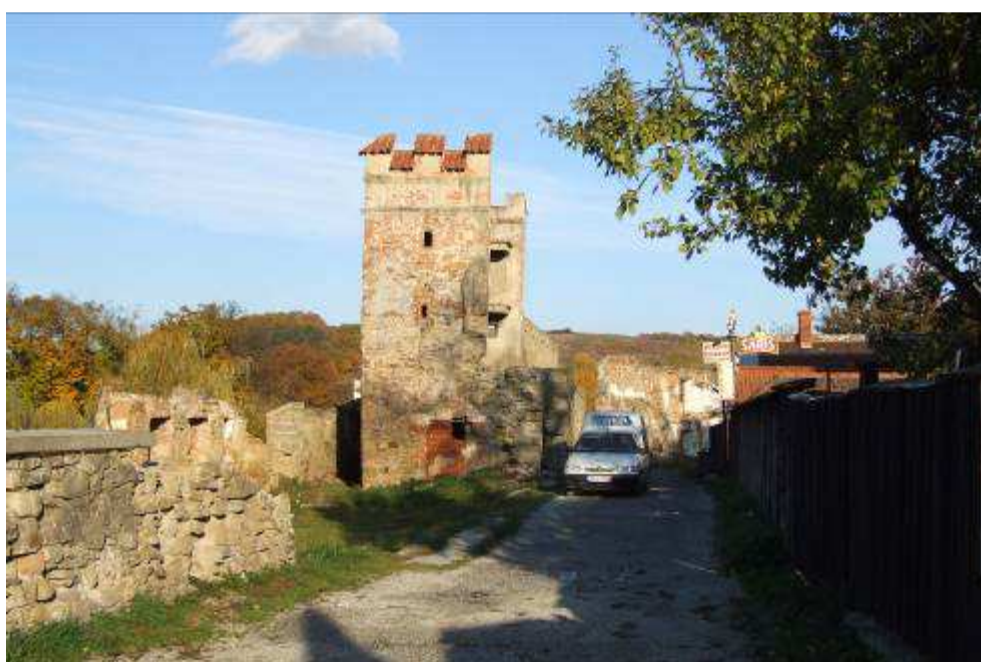
78. Renesančná bašta - ulica Na hradbách, r. 2006
