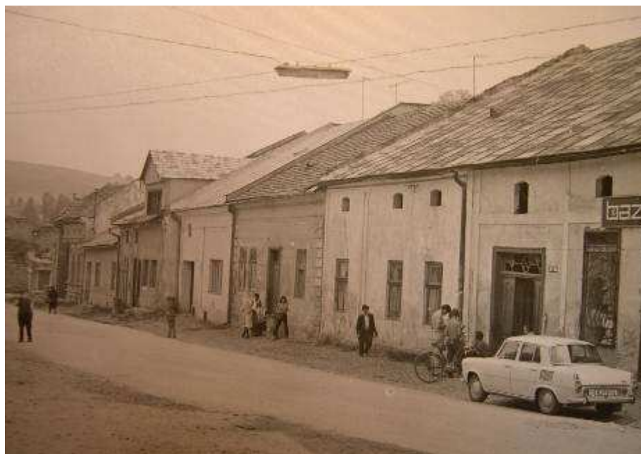
61. Stöcklova ulica smerom k severovýchodnému barbakánu, r. 1972
