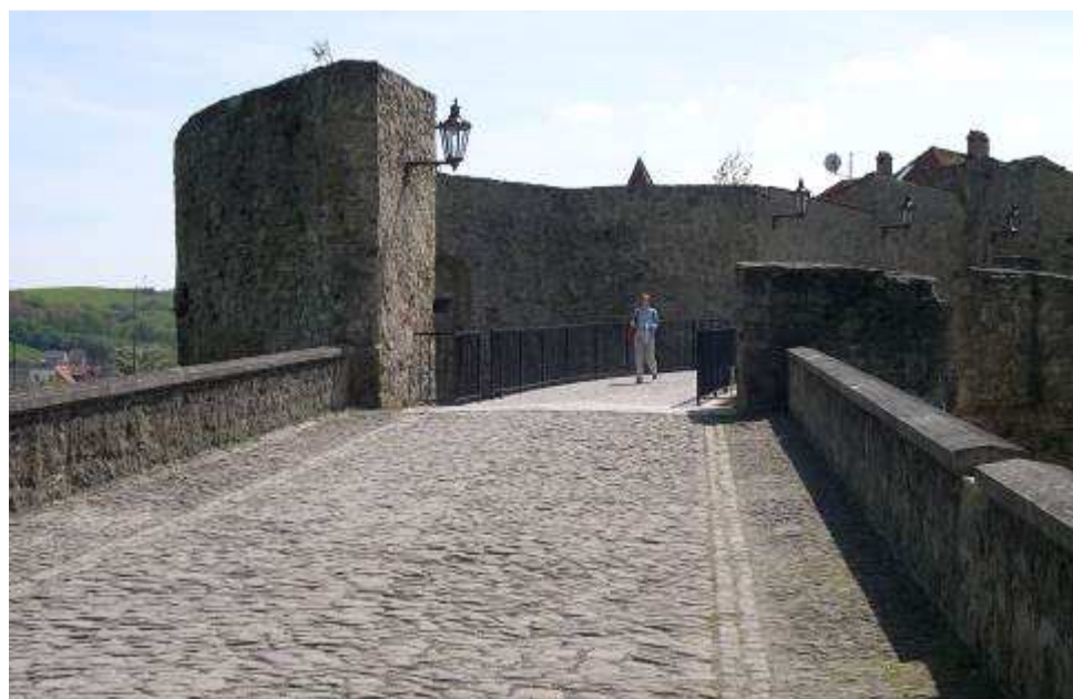
138. Súčasný stav severovýchodného barbakánu
