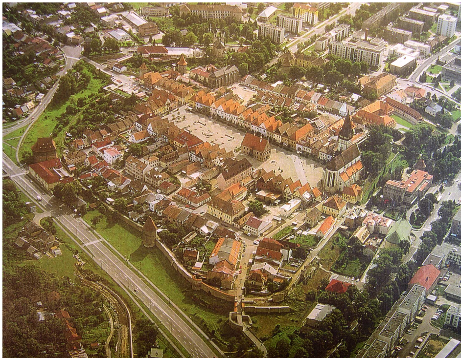
16. Letecký pohľad na námestie z roku 1973 ešte s provizórnym riešením zastrešenia
