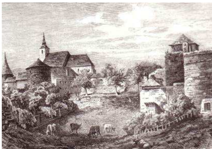
8. Záber dokumentuje časť dnes už nejestvujúceho južného barbakánu a priekopy pred františkánskym kostolom v tom čase už rozparcelovanú na záhrady
