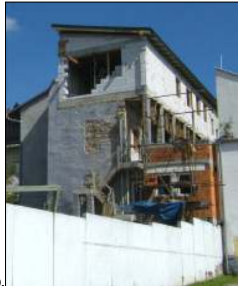
100. Dolná 22, meštiansky dom. Pohľad zo severozápadu, viditeľné nevhodné konštrukčné riešenie s nosnými stĺpmi, uzatvorenie dvora priečnou stavbou.
