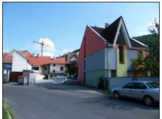
113. Dolná 15, meštiansky dom. Novostavba rodinného domu v závere parcely. Nevhodná hmotová skladba, tvar a veľkosť vikiera, farebné riešenie.
