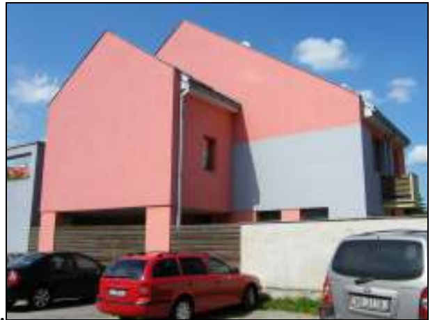
115. Dolná 15, meštiansky dom. Novostavba rodinného domu v závere parcely. Nevhodná hmotová skladba, tvar a veľkosť vikiera, farebné riešenie.
