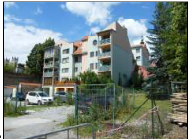
119. Námestie Štefana Moysesa 2, 3. Dostavba dvorových krídiel meštianskych domov v závere parcely. Nevhodné architektonické riešenie (terasy, balkóny), hmotová skladba, výškové riešenie, spôsob zástavby parcely.
