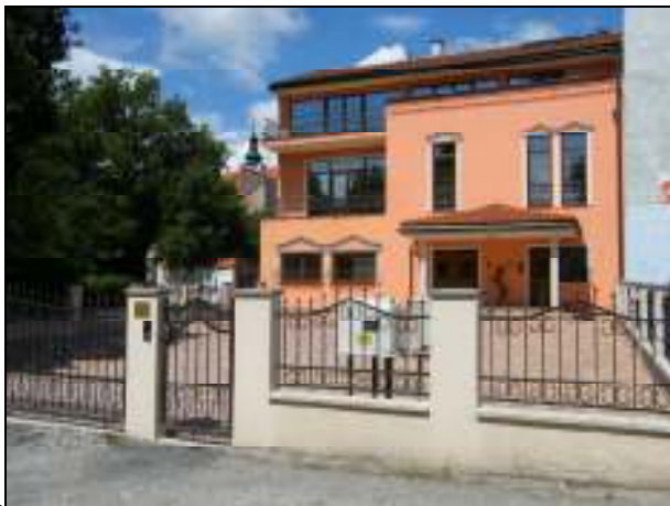
118. Horná 14. Dostavba dvorového krídla domu v závere parcely meštianskeho domu. Nevhodné architektonické riešenie, spôsob zástavby parcely, hmotová skladba, tvar okien, francúzske okná, farebné riešenie v sýtom odtieni.
