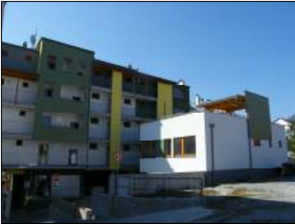
122. Horná Strieborná 15, meštiansky dom, pohľad z východnej strany z dvora domu na Námestí SNP 16. Dostavba dvorového krídla domu na Námestí SNP 14 a prieluky. Nevhodné architektonické riešenie, hmotová skladba, výškové riešenie, spôsob zástavby parcely, farebné riešenie.
