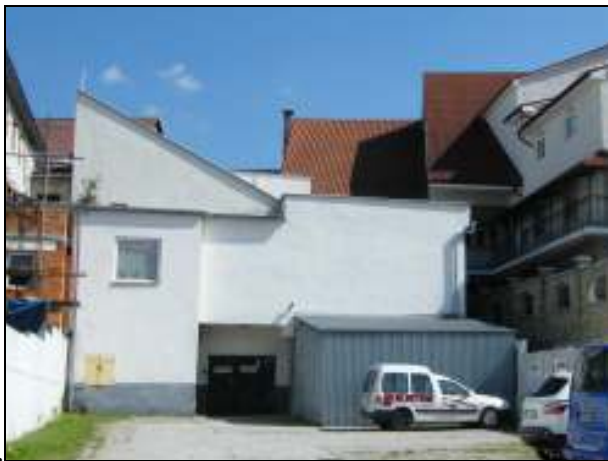
101. Dolná 24, meštiansky dom. Nevhodná dostavba dvorového krídla, hmotové riešenie, spôsob zástavby parcely v celej jej šírke.
