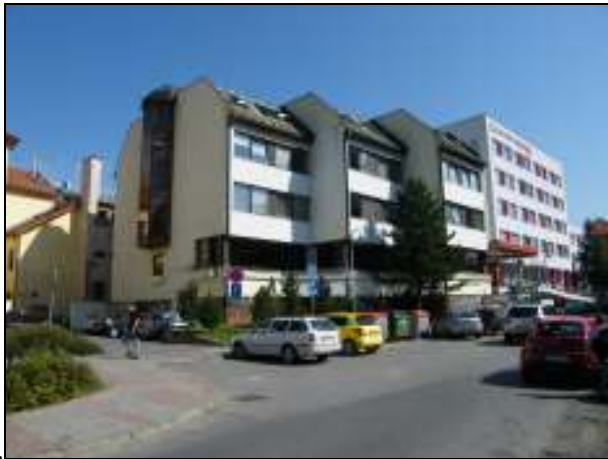
125. Kuzmányho 16, 18, administratívna budova. Dostavba v závere parciel domov č. 43-47. Nevhodné architektonické riešenie, podlažnosť voči 2 podlažným uličným krídlam, rozsah zastavania parcely.
