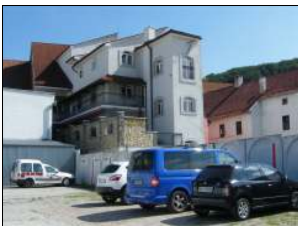
102. Dolná 26, meštiansky dom. Dostavba dvorového krídla. Neprimeraný objem a výškové riešenie voči uličnému krídlu, nevhodná hmotová skladba a nadstavba, zasahujúca do strešnej roviny uličného krídla.
