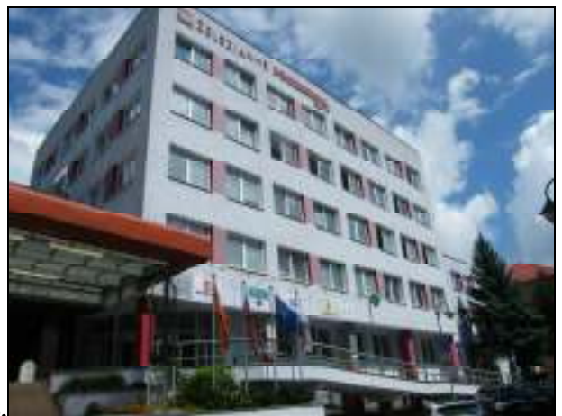
128. Kuzmányho 16, administratívna budova. Dostavba v závere parciel domov č. 43-47. Nevhodné architektonické riešenie, podlažnosť voči 2 podlažným uličným krídlam, rozsah zastavania parcely.
