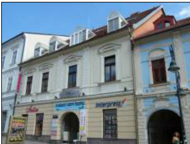
73. Dolná 19, meštiansky dom. Nevhodná veľkosť, materiálové riešenie (plast), zvarové riešenie stredného vikiera, zastrešenie. Nevhodný farebný náter štítovej steny.
