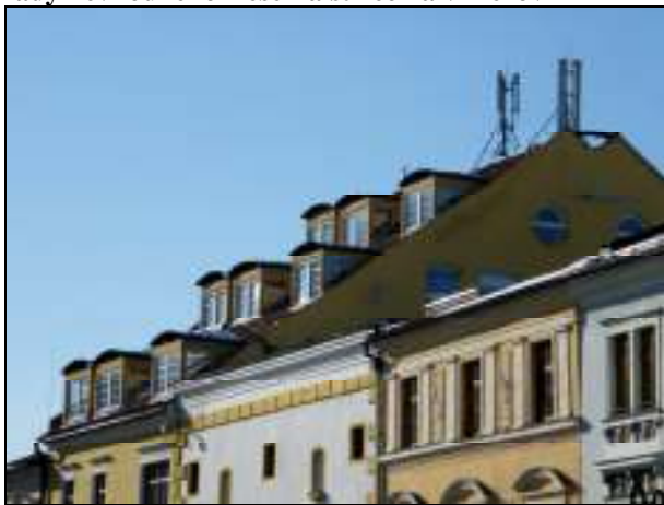
71. Dolná 10, meštiansky dom. Neprimeraný počet v dvoch radoch nad sebou, veľkosť a šírka otvorov, presvetlenie z bočnej strany.
