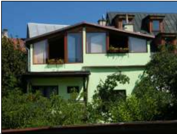
106. Horná Strieborná 11, meštiansky dom. Dostavba dvorového krídla, Nevhodný rozsah v šírke celej parcely, strecha na celú šírku parcely, celoplošné presklenie stien.
