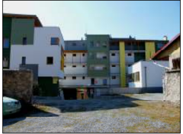
121. Horná Strieborná 15, meštiansky dom, pohľad z východnej strany z dvora domu na Námestí SNP 16. Dostavba dvorového krídla domu na Námestí SNP 14 a prieluky. Nevhodné architektonické riešenie, hmotová skladba, výškové riešenie, spôsob zástavby parcely.
