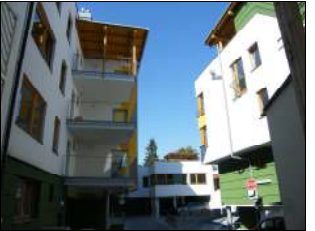
123. Horná Strieborná 15, meštiansky dom, pohľad z južnej strany z dvora domu na Námestí SNP 16. Dostavba dvorového krídla domu na Námestí SNP 14 a prieluky. Nevhodné architektonické riešenie, hmotová skladba, výškové riešenie, spôsob zástavby parcely, farebné riešenie
