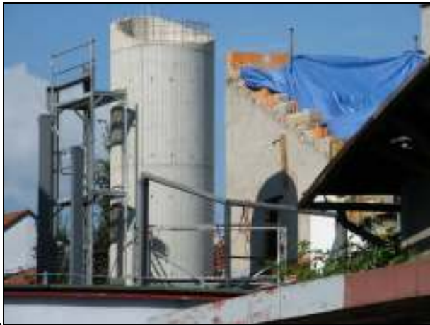
104. Dolná 15, meštiansky dom. Dostavba záveru dvorového krídla
