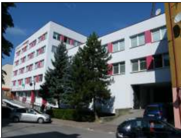
127. Kuzmányho 12, administratívna budova. Dostavba v závere parciel domov č. 35-41. Nevhodné architektonické riešenie, podlažnosť hlavnej budovy vľavo, zastrešenie rovnou strechou, farebné riešenie.
