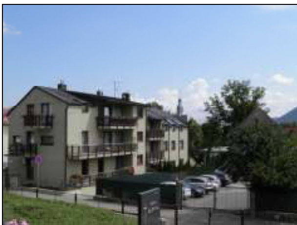
129. Kollárova 2, administratívna budova. Novostavba na predtým nezastavanej ploche pri mestských hradbách. Neprimerané hmotovo-objemové riešenie, situovanie objektu v blízkosti bašty.
