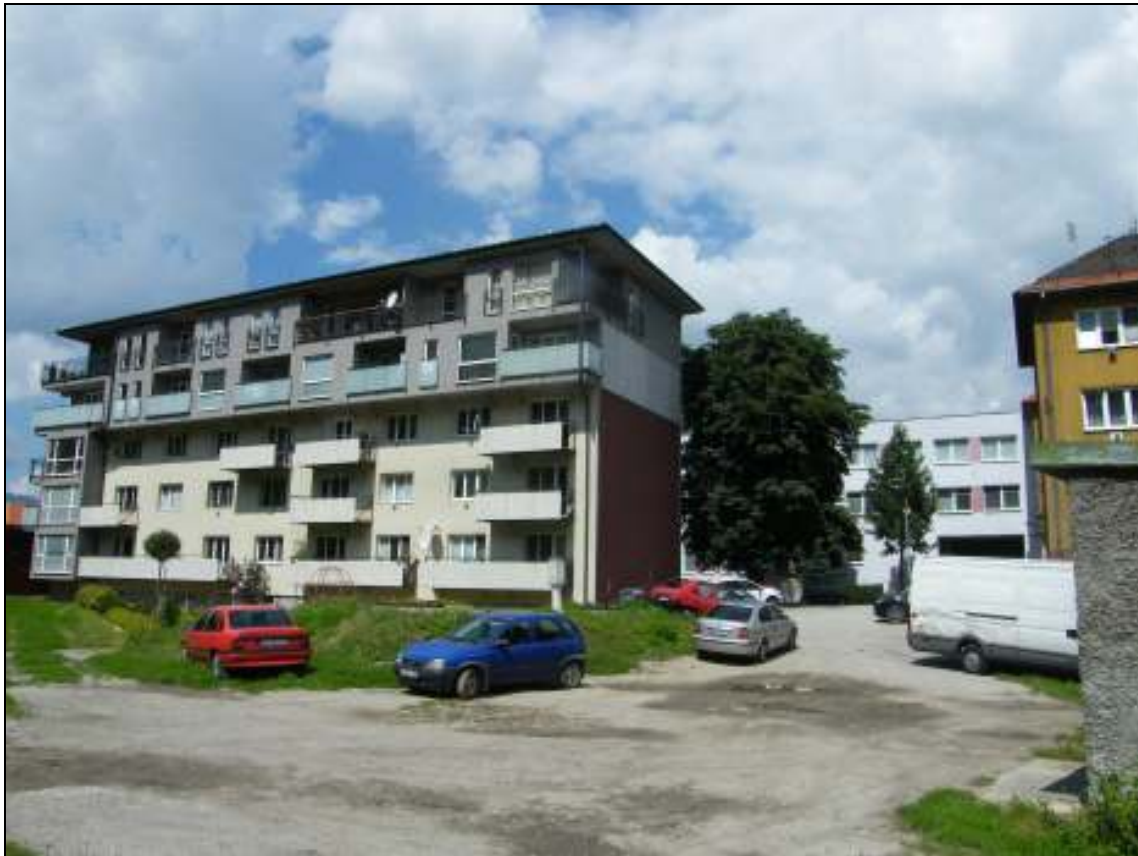
56. Pohľad do dvora za bytovými domami na juhovýchodnej strane Kuzmányho ulice, júl 2014.
