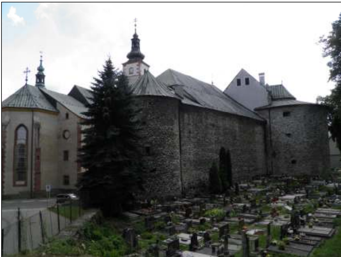
36. Pohľad z r. k. cintorína na hradný areál, vľavo r. k. kostol Nanebovzatia Panny Márie (farský), smerom doprava pisárska (Galova) bašta a tzv slovenský kostol, pristavaný k hradbám, júl 2014.
