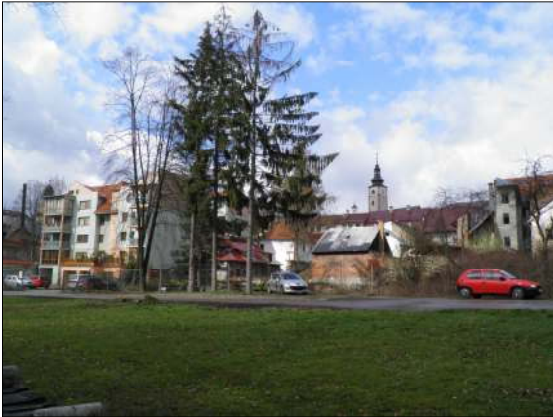
64. Pohľad na dvorovú zástavbu meštianskych domov juhovýchodnej radovej zástavby Námestia Štefana Moysesa. V pozadí veža farského kostola Nanebovzatia Panny Márie, marec 2014.
