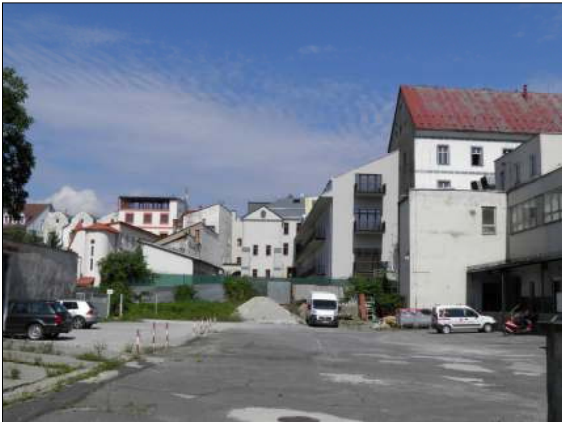
59. Pohľad z dvora na Kapitulskej 12 na zadné fasády a dvorové krídla meštianskych domov juhovýchodnej radovej zástavby Námestia SNP, august 2011.
