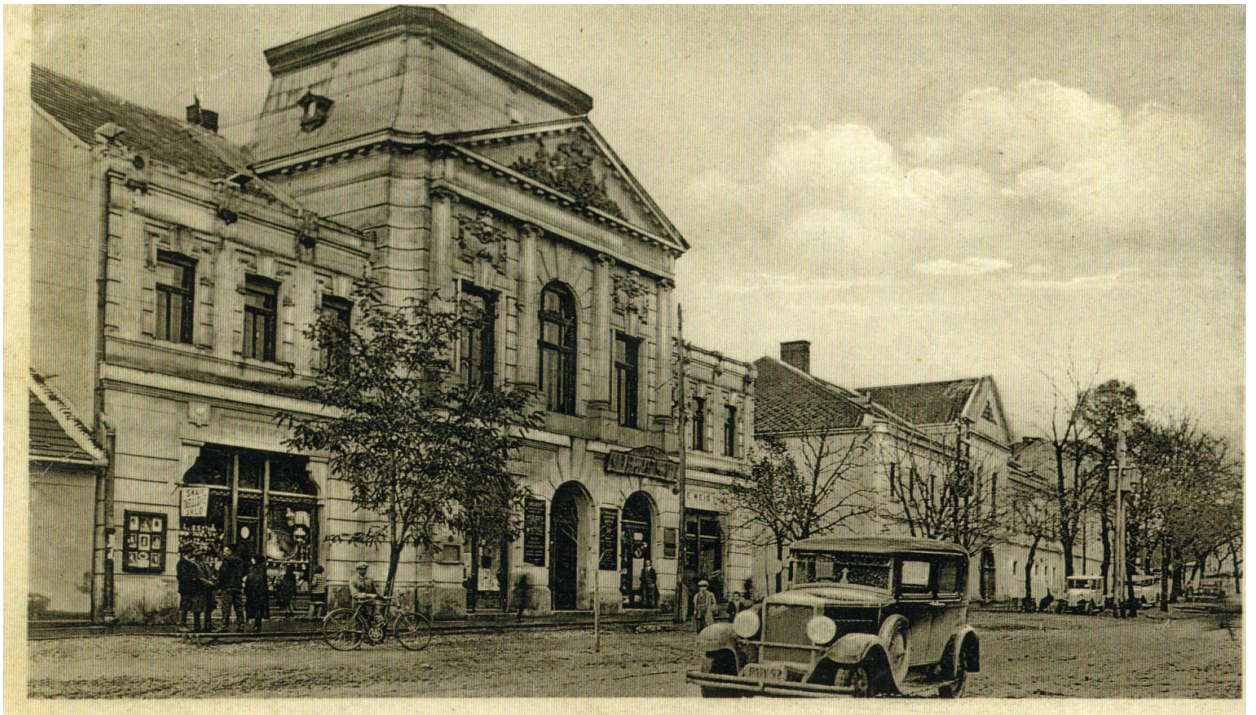
8. Historická fotografia; pohľad od západu na severnú uličnú radovú zástavbu Ul. Župná; rok 1931
