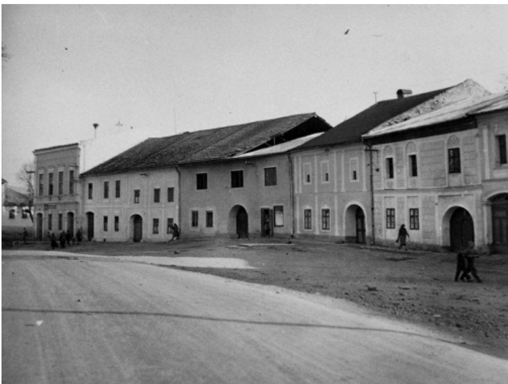
24. radová zástavba južnej strany námestia s objektmi súp. č. 204 – 198 v roku 1959 (zdroj: Archív Pamiatkového úradu SR, Fialová, č. negatívu 8626/2)
