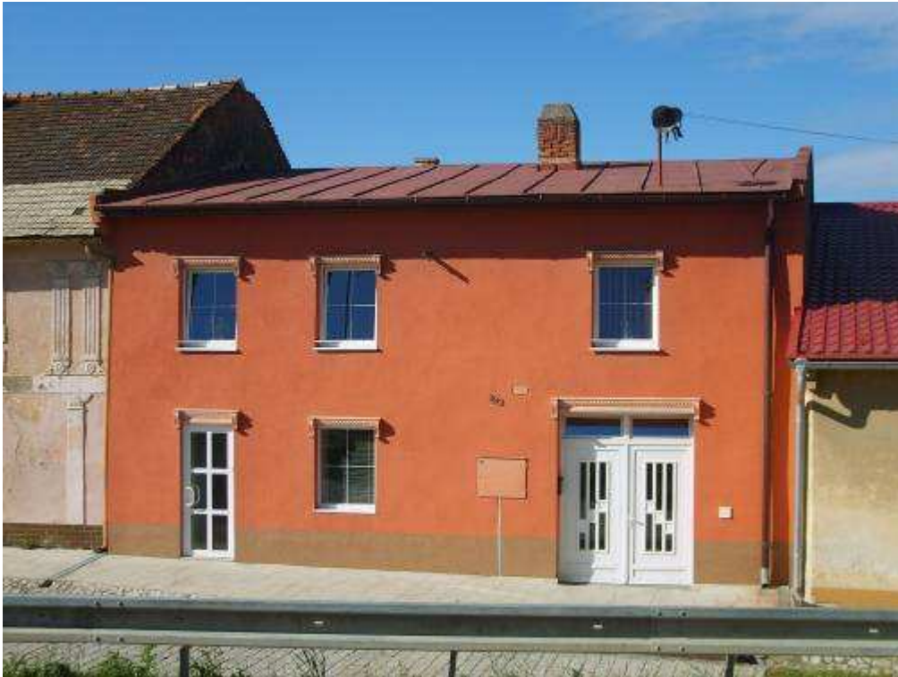
59. objekt súp. č. 192 – objekt s pamiatkovými hodnotami (žiaduce je odstránenie prvkov v nadpraží otvorov a korekcia farebného riešenia fasády) a prinavrátenie historického stvárnenia fasády
