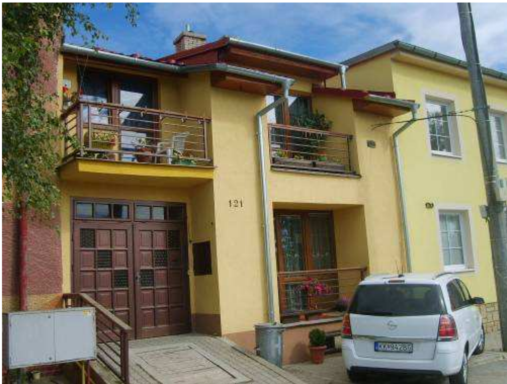
101. objekt súp. č. 121 – objekt nerešpektujúci pamiatkové hodnoty územia
