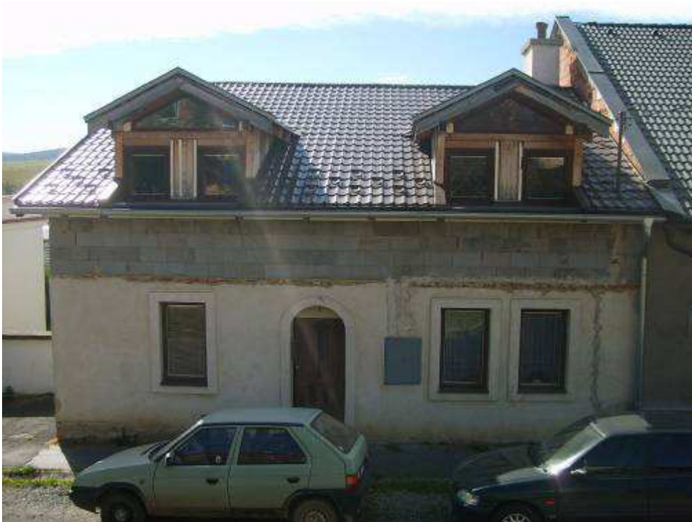
109. objekt súp. č. 89 – objekt nerešpektujúci pamiatkové hodnoty územia
