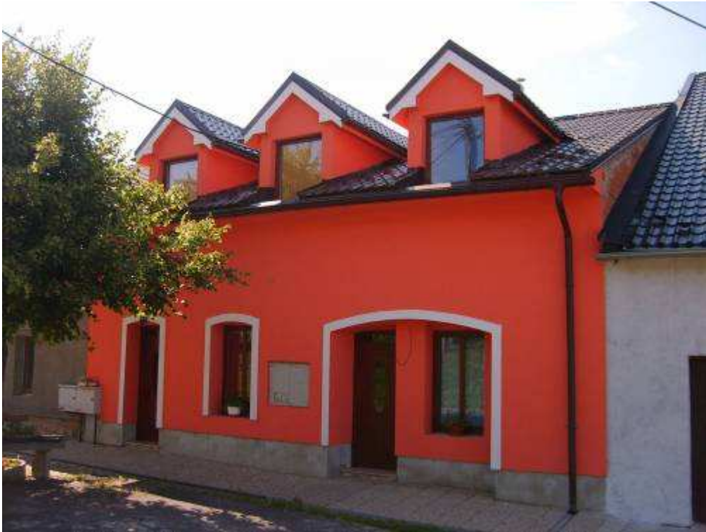
111. objekt súp. č. 87 – objekt nerešpektujúci pamiatkové hodnoty územia
