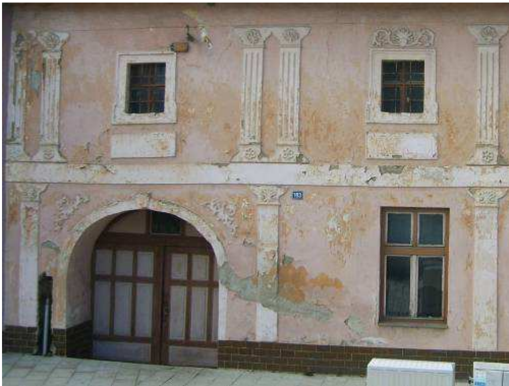
133. autentické architektonické a výtvarné prvky fasády objektu súp. č. 193
