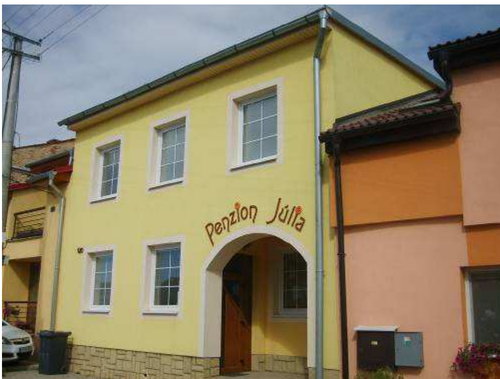
102. objekt súp. č. 120 – objekt rešpektujúci pamiatkové hodnoty územia (žiaduca je zmena zastrešenia na sedlové a úprava vstupného otvoru)
