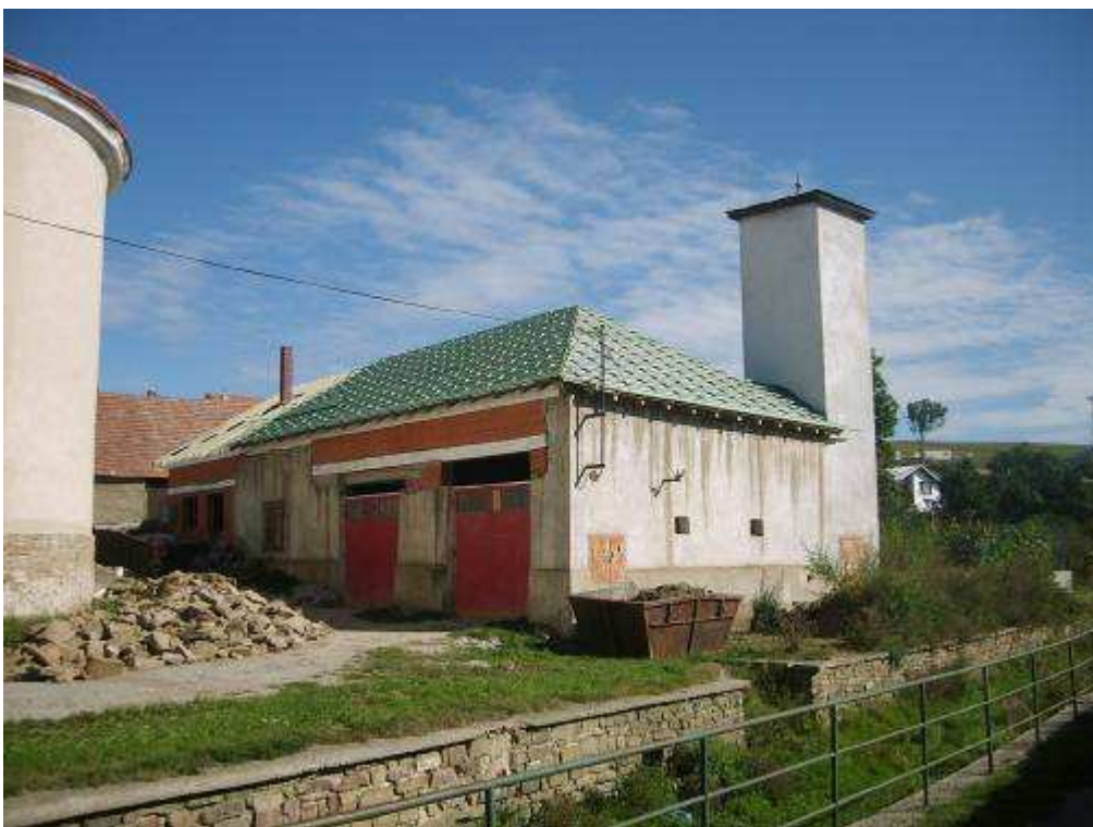
126. požiarne zbrojnica súp. č. 281 – objekt nerešpektujúci pamiatkové hodnoty územia
