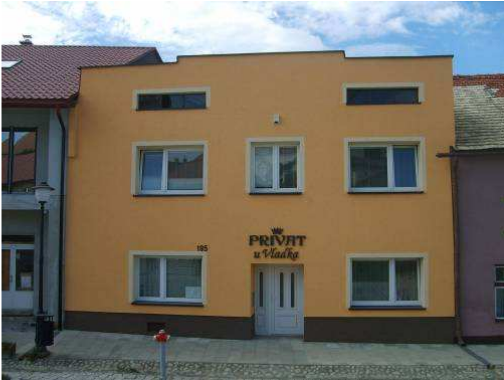
54. objekt súp. č. 195 – objekt nerešpektujúci pamiatkové hodnoty územia
