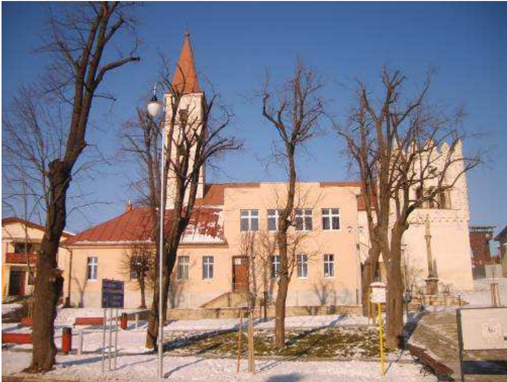
75. objekt súp. č. 135 – objekt nerešpektujúci pamiatkové hodnoty územia
