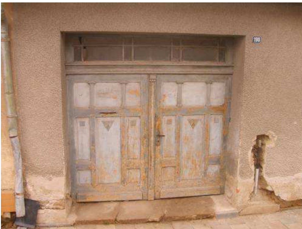
134. výplň vstupného otvoru objektu súp. č. 190
