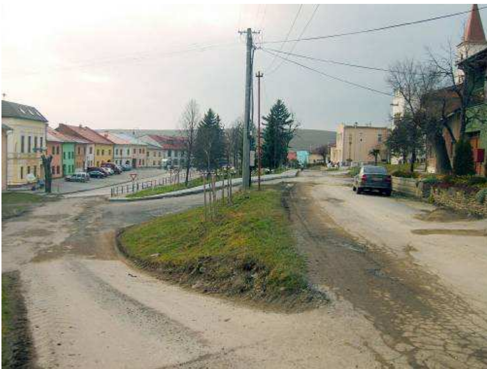
12. pohľad P6 na západnú časť historickej radovej zástavby námestia
