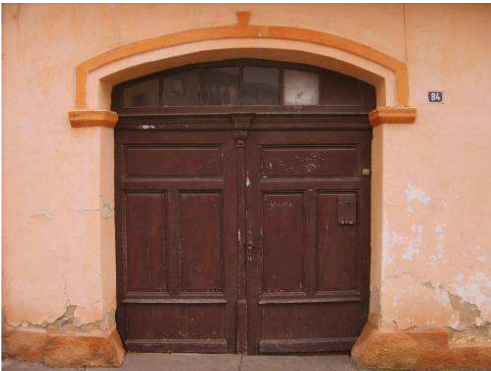
138. výplň vstupného otvoru objektu súp. č. 84
