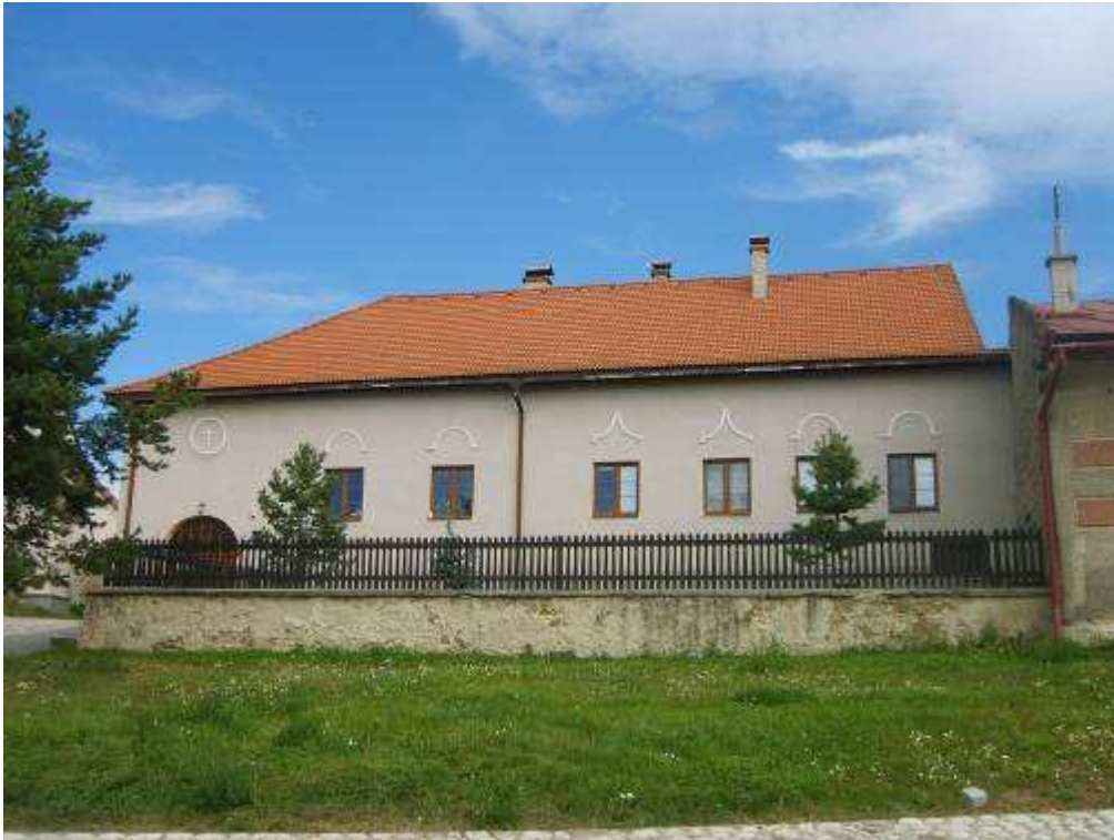
79. rímskokatolícka fara súp. č. 133 – objekt vytypovaný na vyhlásenie za NKP
