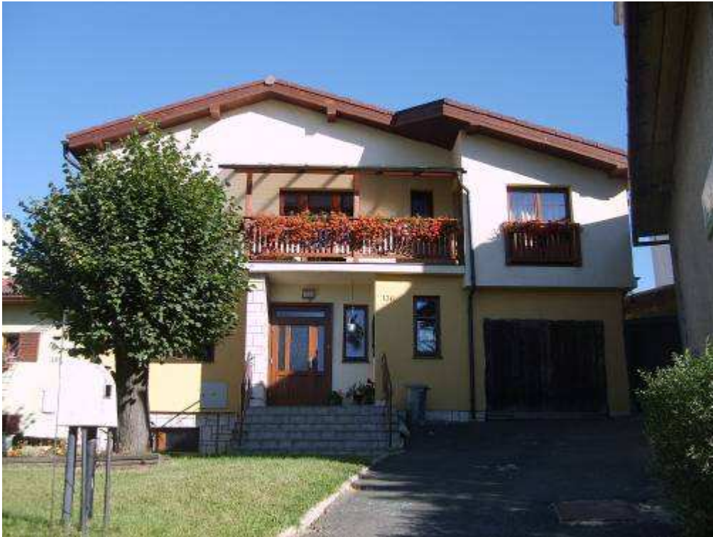
73. objekt súp. č. 136 – objekt nerešpektujúci pamiatkové hodnoty územia
