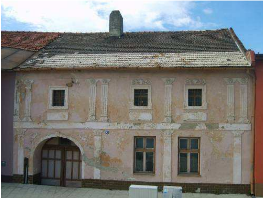
56. objekt súp. č. 193 – objekt vytypovaný na vyhlásenie za NKP
