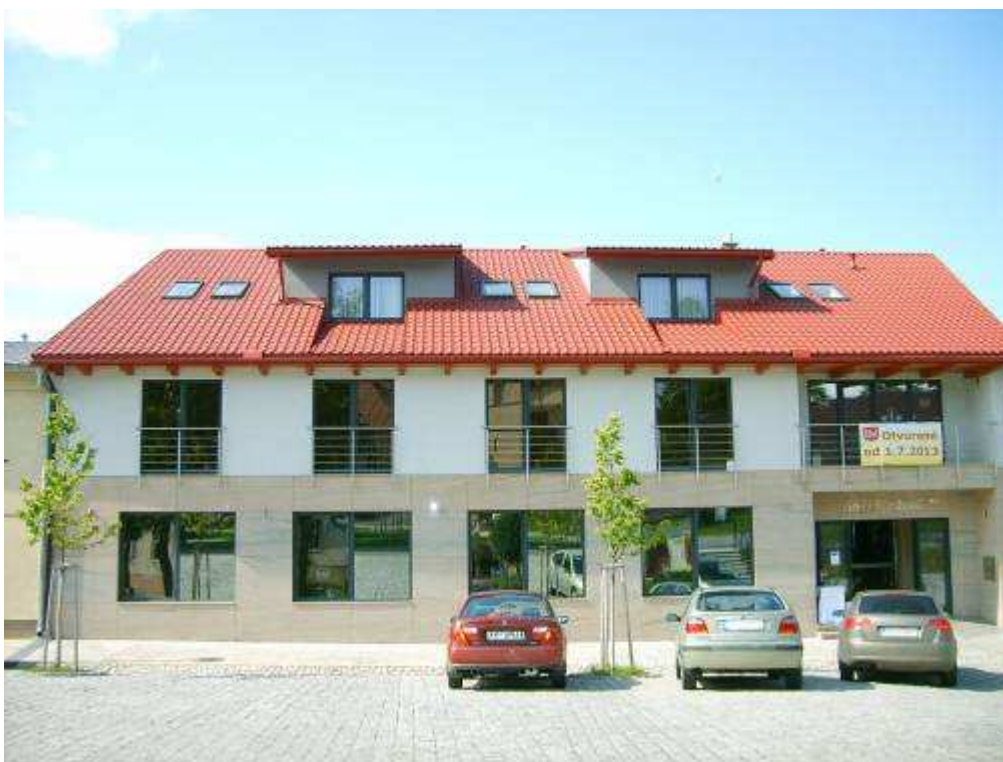
50. objekt súp. č. 196 – objekt nerešpektujúci pamiatkové hodnoty územia
