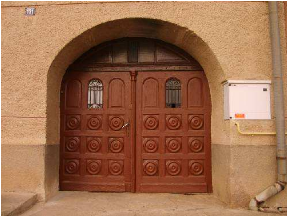
137. výplň vstupného otvoru objektu súp. č. 131
