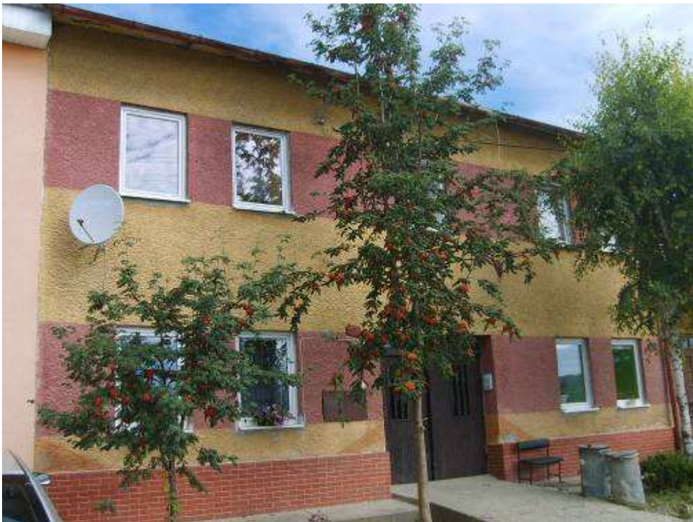
100. objekt súp. č. 122 – objekt s pamiatkovými hodnotami (žiadauce je prinavrátenie historického stvárnenia fasády)
