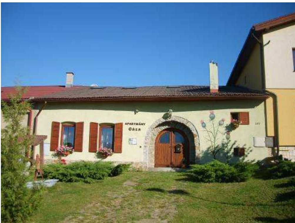
72. objekt súp. č. 137 – objekt s pamiatkovými hodnotami (žiaduce je prinavrátenie historického stvárnenia fasády)
