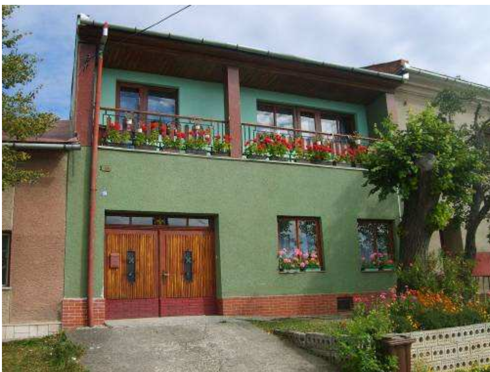
88. objekt súp. č. 128 – objekt nerešpektujúci pamiatkové hodnoty územia
