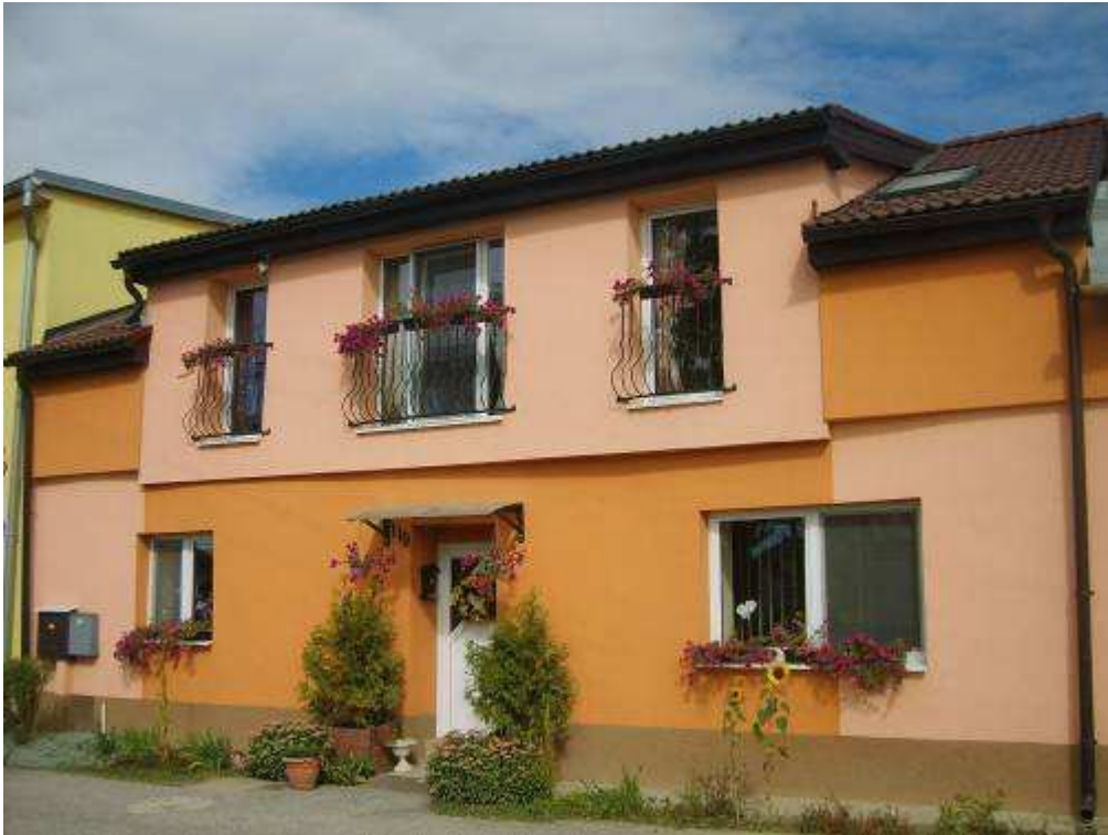
104. objekt súp. č. 119 – objekt nerešpektujúci pamiatkové hodnoty územia
