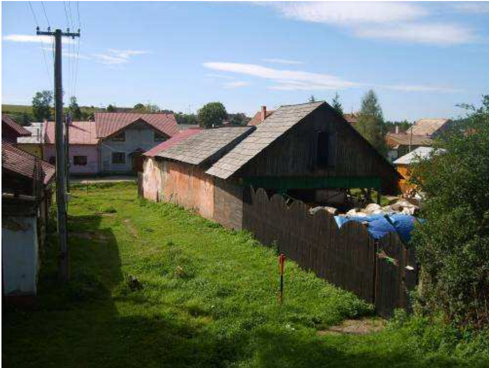
131. zachovaná časť objektu súp. č. 76 – objekt rešpektujúci pamiatkové hodnoty územia
