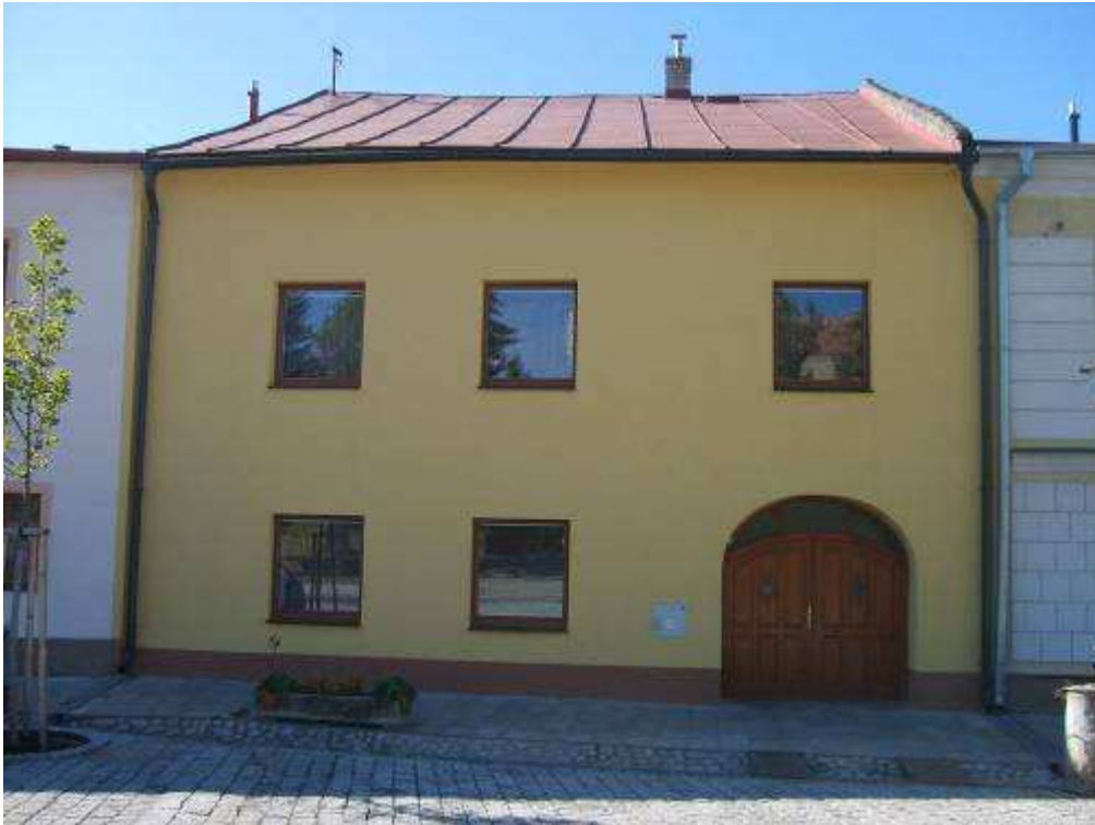
45. objekt súp. č. 200 – objekt s pamiatkovými hodnotami (žiaduce je prinavrátenie historického stvárnenia fasády)
