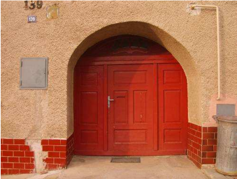
135. výplň vstupného otvoru objektu súp. č. 139
