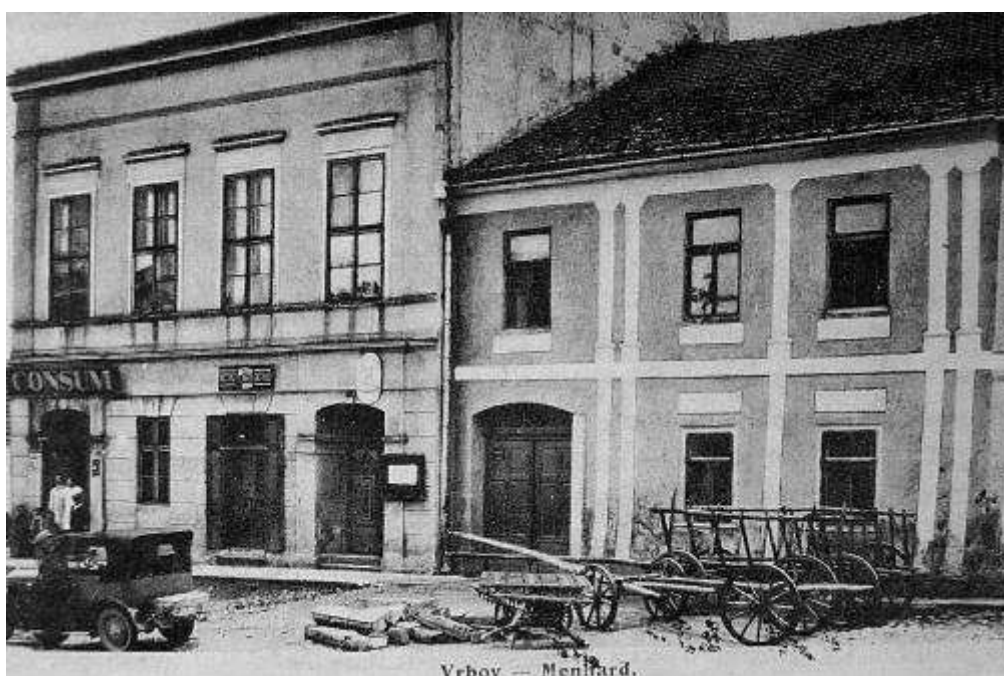
38. objekt súp. č. 204 (bývalá radnica) a objekt súp. č. 203 v 30. r. 20. st. (zdroj: Chalupický, I.: Dejiny Vrbova)
