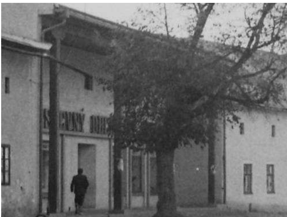
51. objekt súp. č. 196 v roku 1959 (zdroj: Archív Pamiatkového úradu SR, Fialová, výrez z negatívu č. 8626/3)
