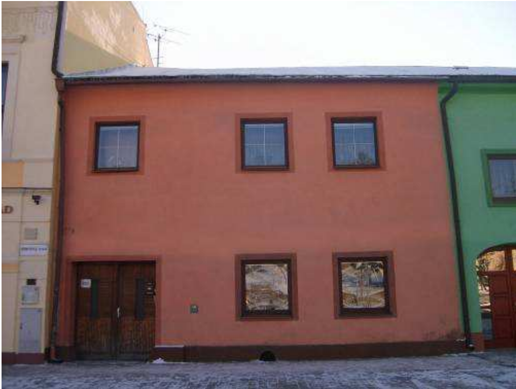
39. objekt súp. č. 203 – objekt s pamiatkovými hodnotami (žiaduce je prinavrátenie historického stvárnenia fasády)
