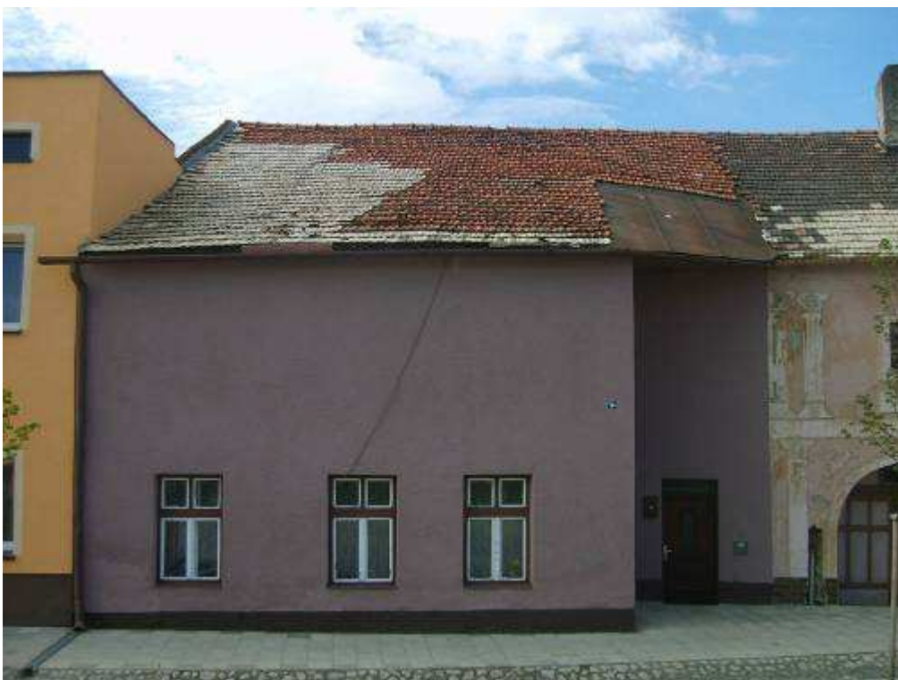
55. objekt súp. č. 194 – objekt s pamiatkovými hodnotami (žiaduce je prinavrátenie historického stvárnenia fasády)
