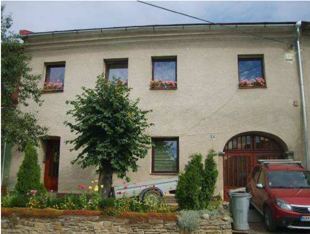
89. objekt súp. č. 127 – objekt s pamiatkovými hodnotami (žiadauce je prinavrátenie historického stvárnenia fasády)
