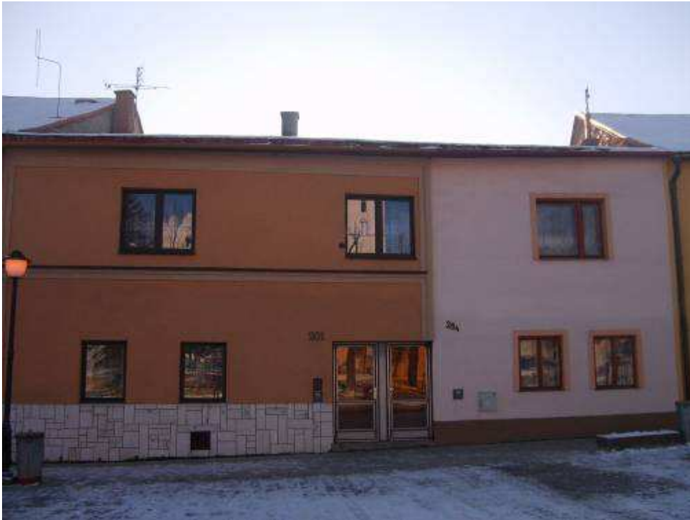
41. objekty súp. č. 201 a 254 – objekty rešpektujúce pamiatkové hodnoty územia (žiaduca je zmena zastrešenia objektov na sedlové a odstránenie nevhodných úprav fasád-šambrán, prvkov falzifikujúcej výzdoby či vysoký a štruktúrovaný obklad sokla)
