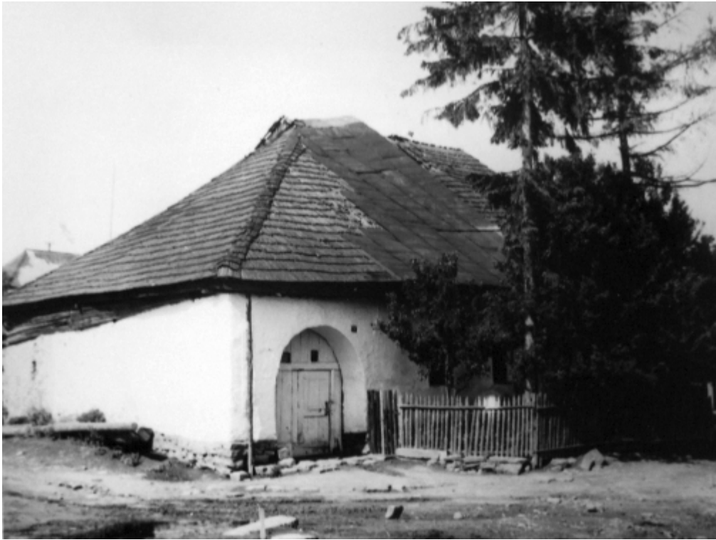
129. zaniknutý objekt súp. č. 78 v roku 1961 (zdroj: Archív Pamiatkového úradu SR, Borodáč, č. negatívu 32411)
