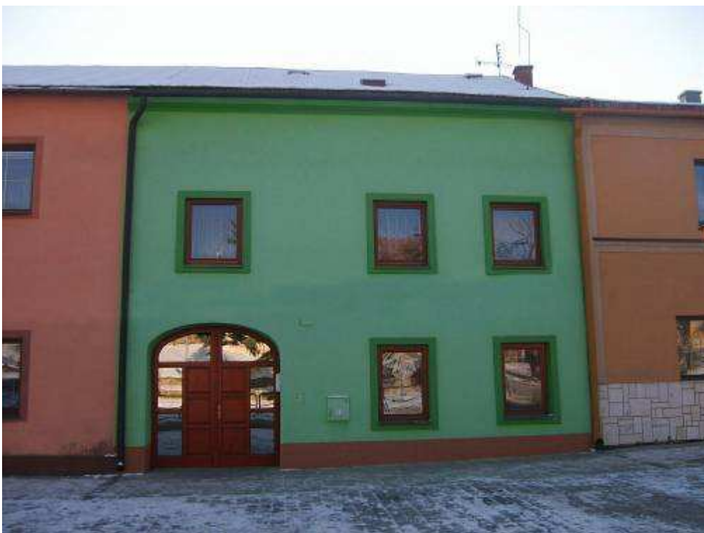
40. objekt súp. č. 202 – objekt s pamiatkovými hodnotami (žiaduce je prinavrátenie historického stvárnenia fasády)
