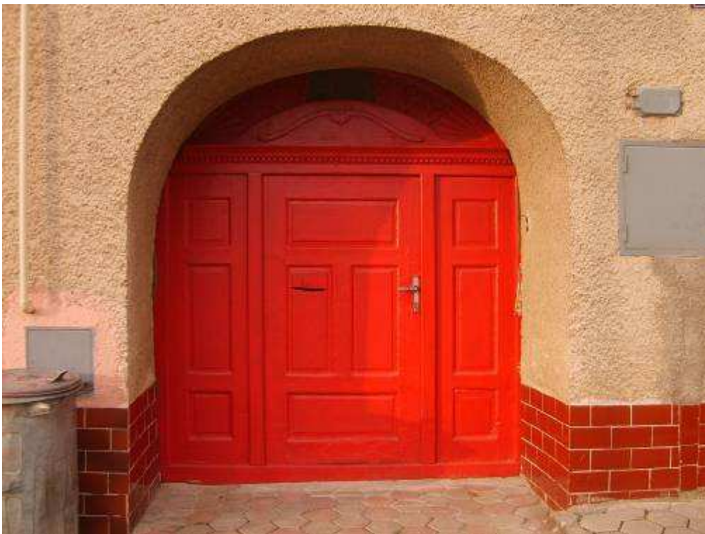
136. výplň vstupného otvoru objektu súp. č. 138
