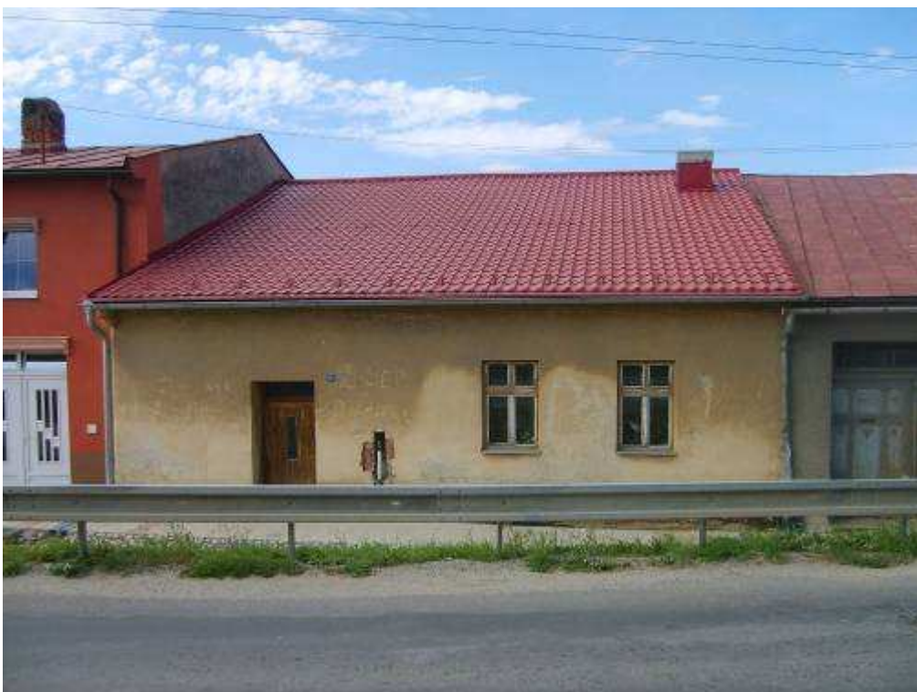
60. objekt súp. č. 191 – objekt s pamiatkovými hodnotami (žiaduce je prinavrátenie historického stvárnenia fasády)
