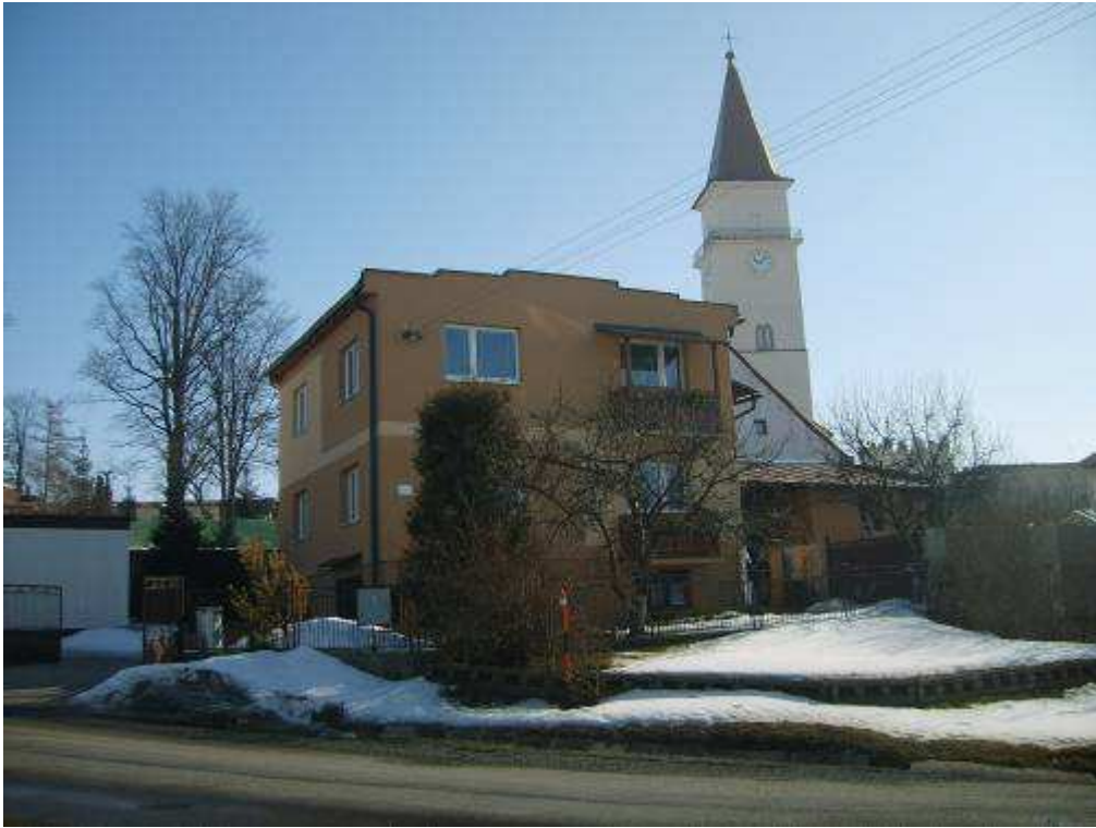
66. objekt súp. č. 277 – objekt nerešpektujúci pamiatkové hodnoty územia
