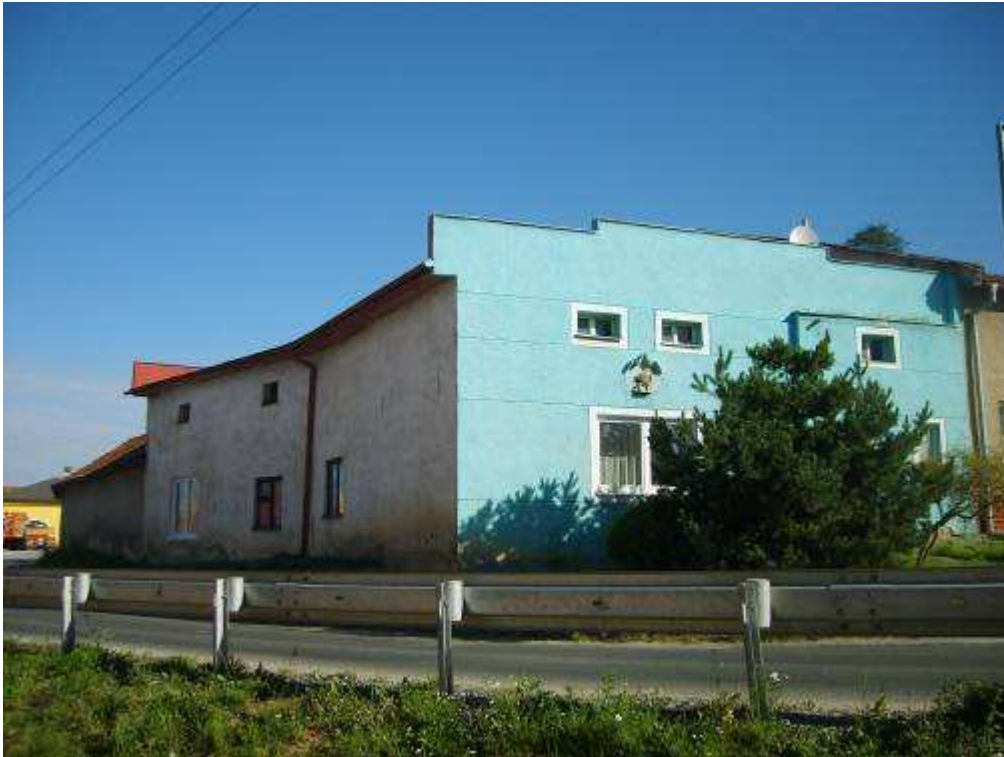
69. objekt súp. č. 140 – objekt rešpektujúci pamiatkové hodnoty územia (žiaduca je korekcia farebného riešenia hlavnej fasády)
