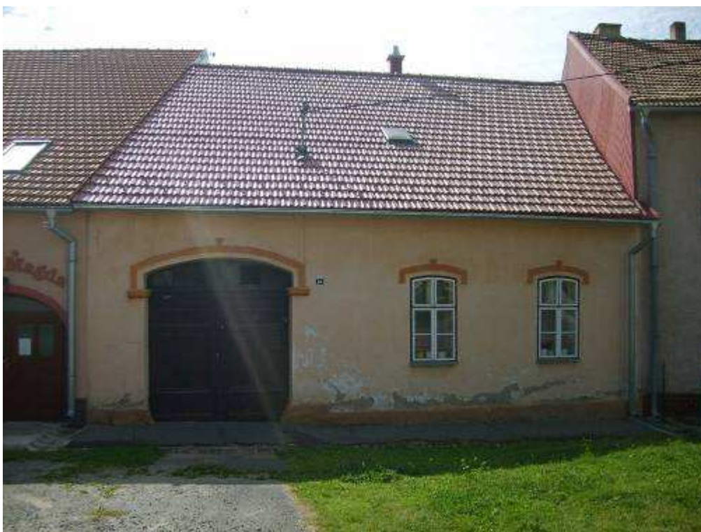
117. objekt súp. č. 84 – objekt vytypovaný na vyhlásenie za NKP
