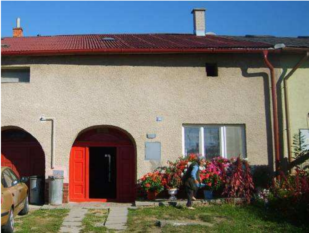
71. objekt súp. č. 138 – objekt s pamiatkovými hodnotami (žiaduce je prinavrátenie historického stvárnenia fasády)
