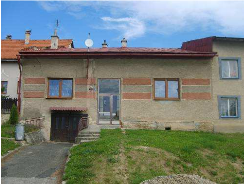
81. objekt súp. č. 132– objekt nerešpektujúci pamiatkové hodnoty územia
