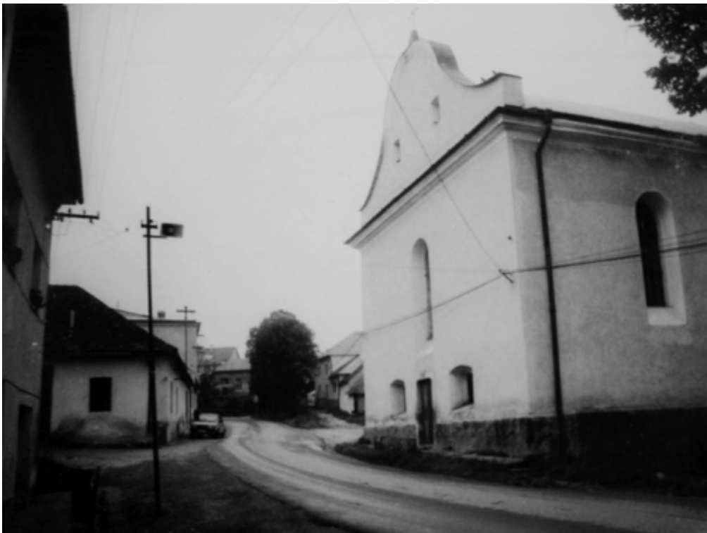
18. objekt obecného úradu súp. č.204 a evanjelický kostol súp. č. 298 v roku 1994 (zdroj: Archív Pamiatkového úradu SR, Jurík, č. negatívu 113669)
