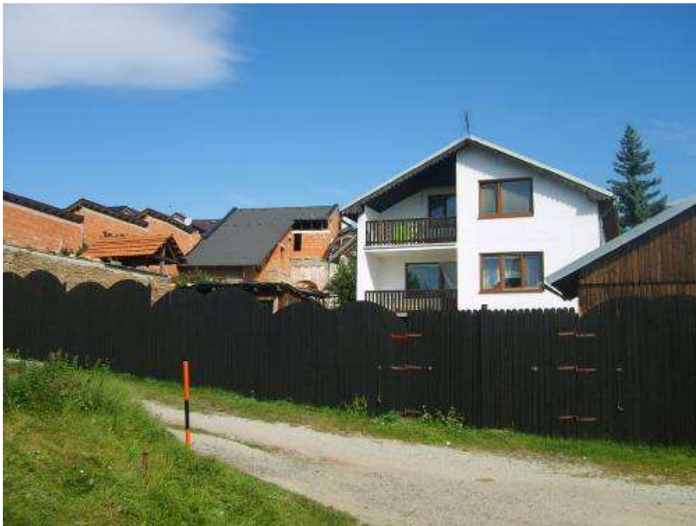
127. objekt súp. č. 77 – objekt nerešpektujúci pamiatkové hodnoty územia
