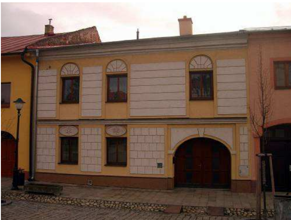
46. objekt súp. č. 199 – objekt vytypovaný na vyhlásenie za NKP
