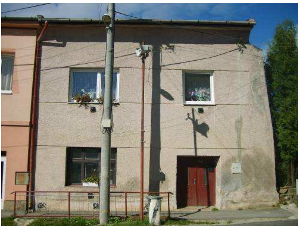
34. objekt súp. č. 206 – objekt rešpektujúci pamiatkové hodnoty územia (žiaduce je prinavrátenie historického stvárnenia fasády)
