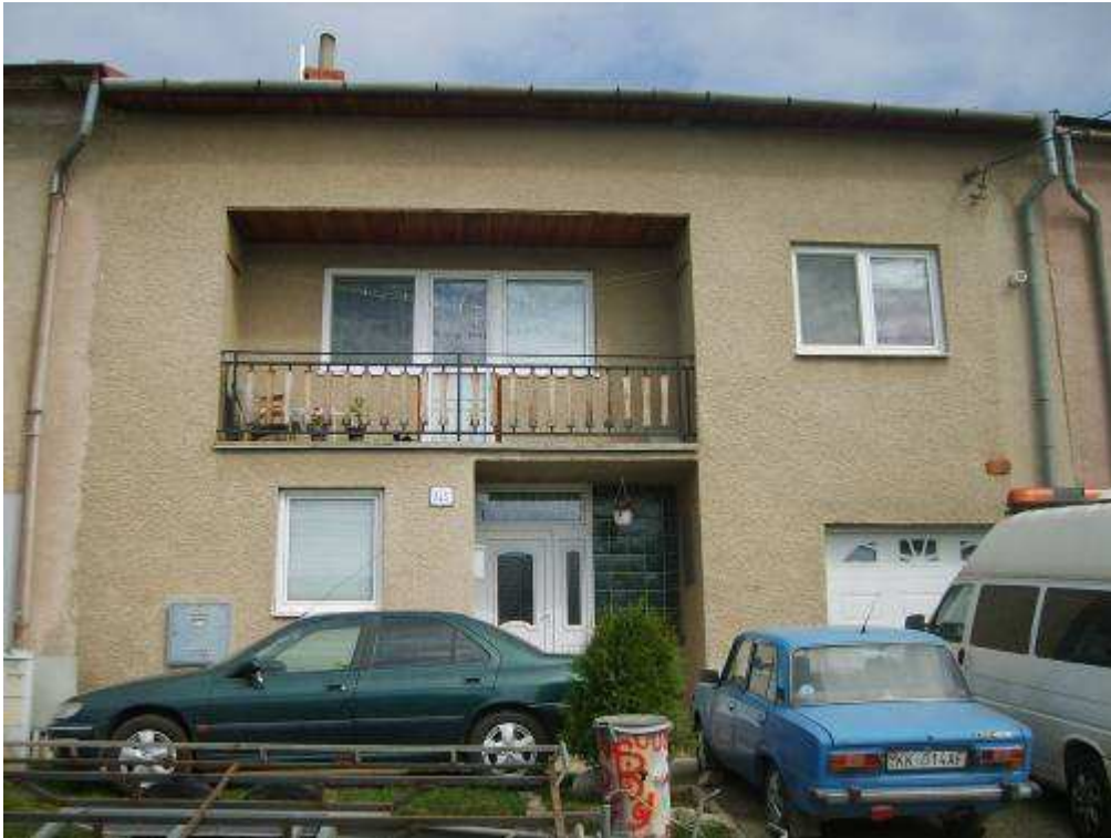
93. objekt súp. č. 125 – objekt nerešpektujúci pamiatkové hodnoty územia
