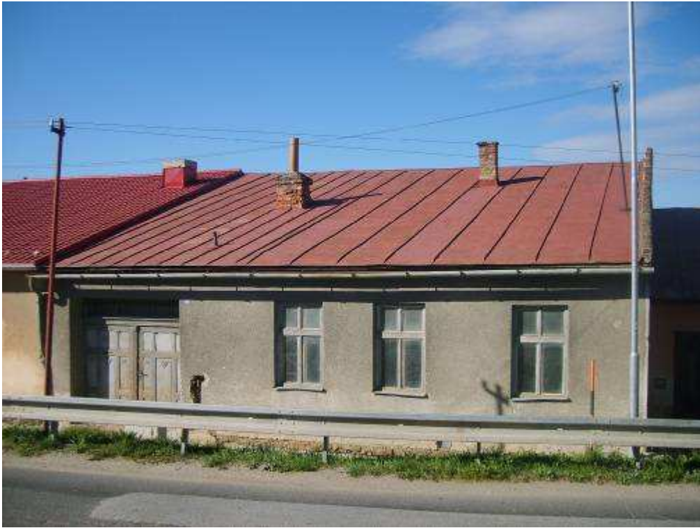
61. objekt súp. č. 190 – objekt vytypovaný na vyhlásenie za NKP
