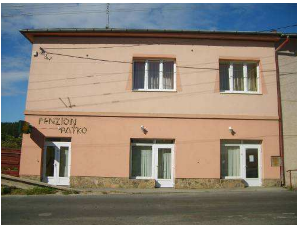
33. objekt súp. č. 207 – objekt nerešpektujúci pamiatkové hodnoty územia
