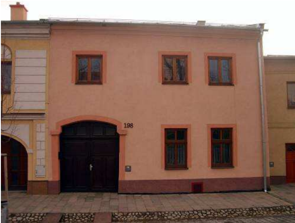
47. objekt súp. č. 198 – objekt vytypovaný na vyhlásenie za NKP
