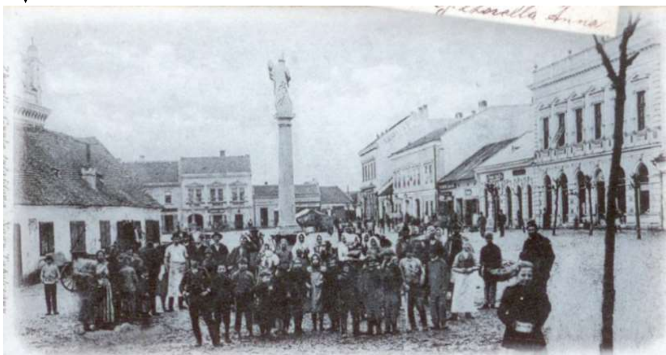
5.3.2. Pohľad do námestia, r.1899-1901, severne od kostola situovaný objekt bývalej radnice, objekt jatiek
