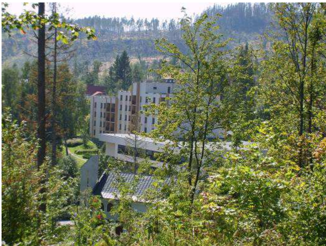
18. Pohľad SV z prístupovej komunikácie ku Grandhotelu na Rímskokatolícky kostolík a Hotel Slovan
