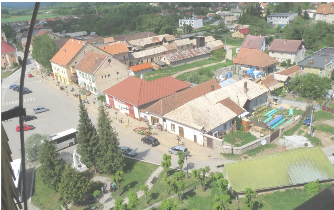
3. Pohľad z veže ev. a. v. kostola smerom na sever
