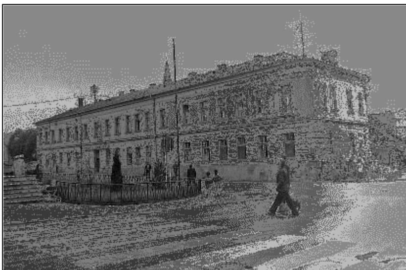
87 Bývalý hotel Dukla (Námestie sv. Mikuláša č. 27), dlhšia západná fasáda – pohľad z ul. 1. Mája r. 1981
