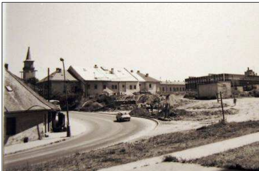
79 Popradská ulica- pohľad na západné fasády zástavby západného bloku Námestia sv. Mikuláša (už bez dvorových krídel) r. 1981
