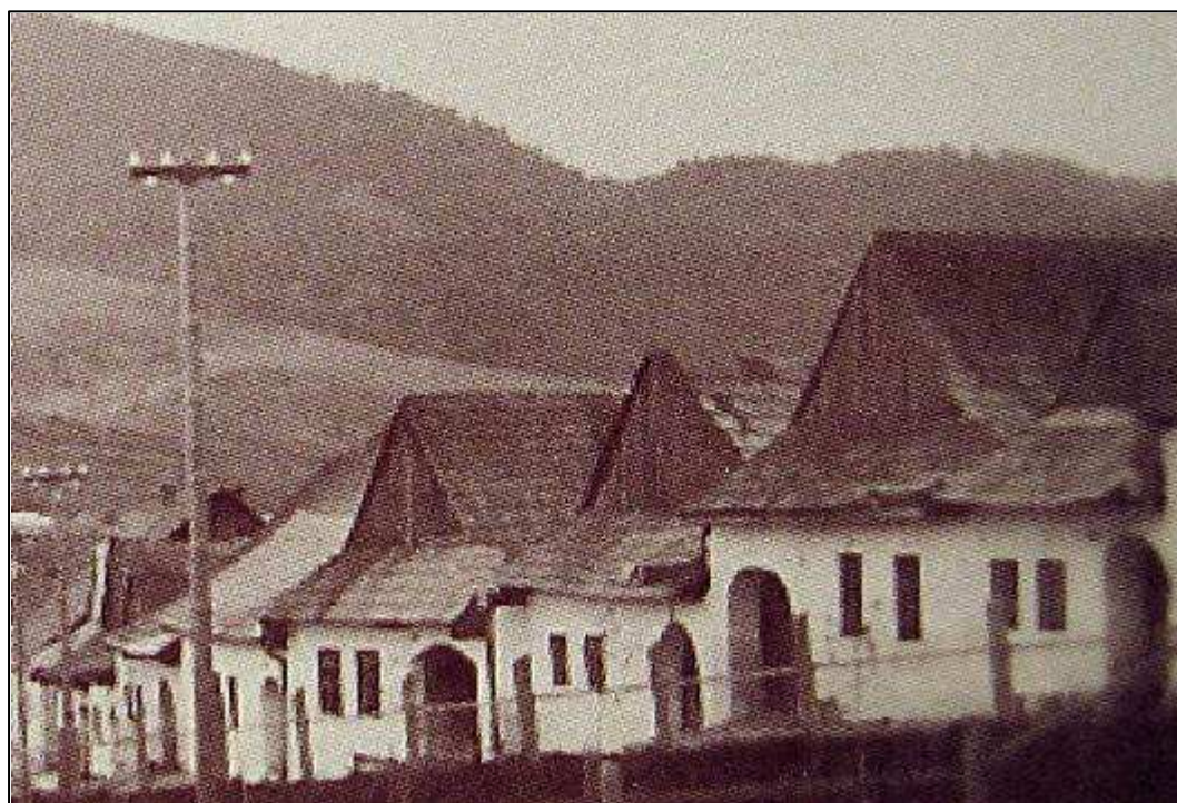
10 - Nižná ulica – pôvodná zástavba so sedlovými strechami s hrebeňom kolným na ulicu a podlomenicou a šindľovými krytinami, 40-té roky 20. stor.
