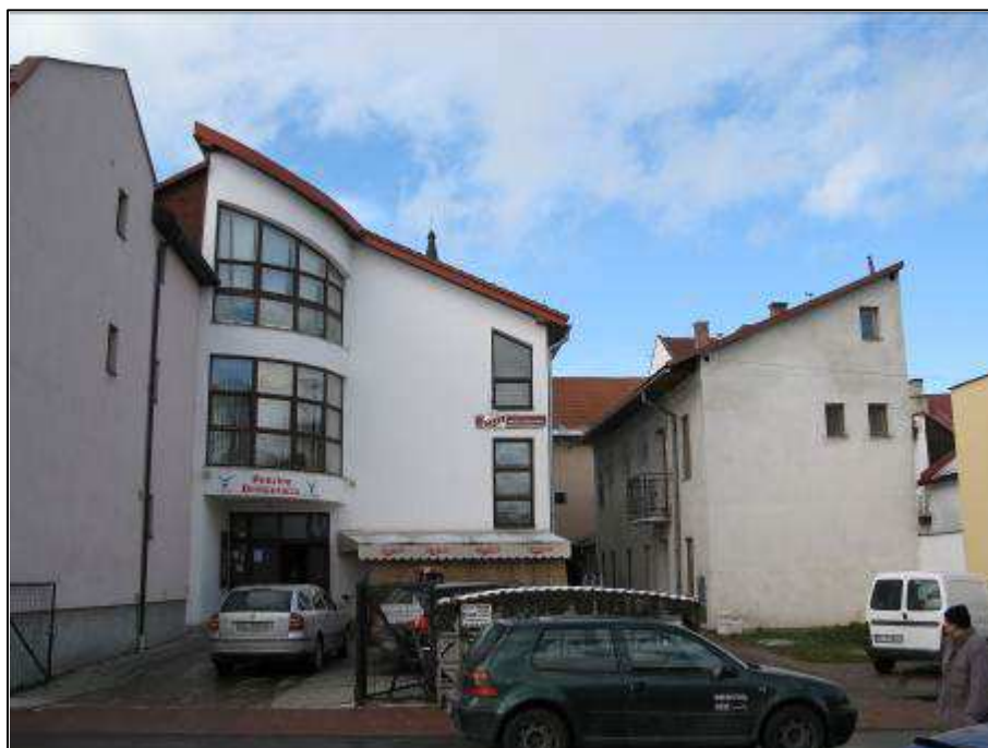
99 Námestie sv. Mikuláša č. 24 - nevhodné novodobé dvorové krídlo v šírke celého hlavného objektu. r. 2007
