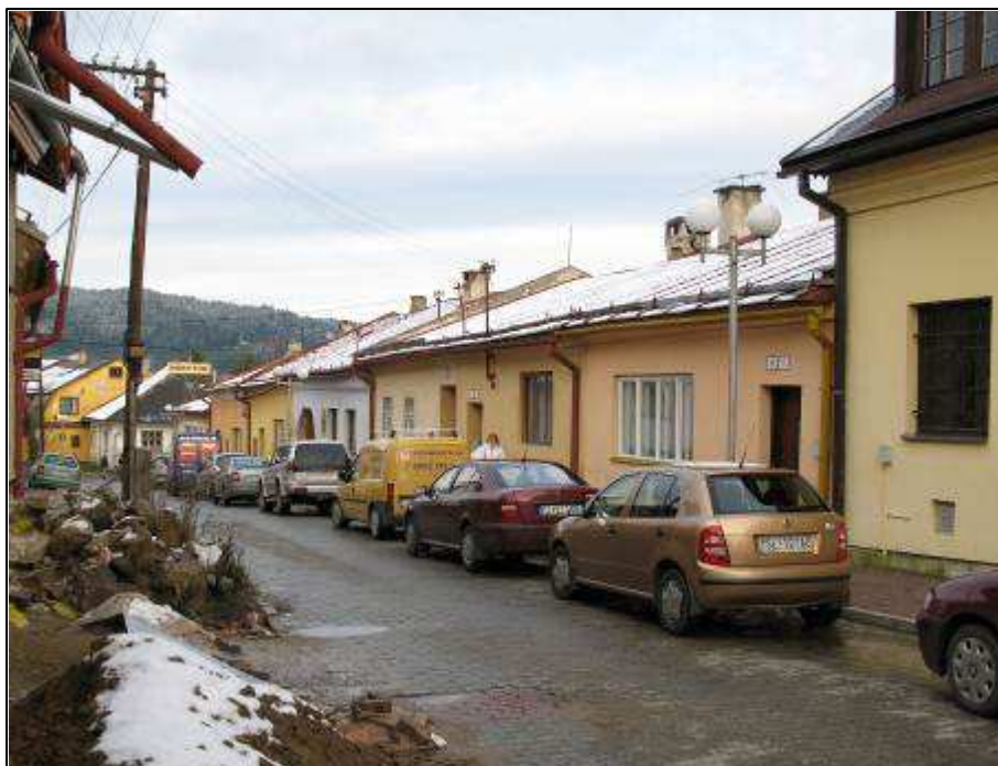
102 Garbiarska ulica, severné fasády južnej zástavby západného bloku ulice, pohľad na východ
