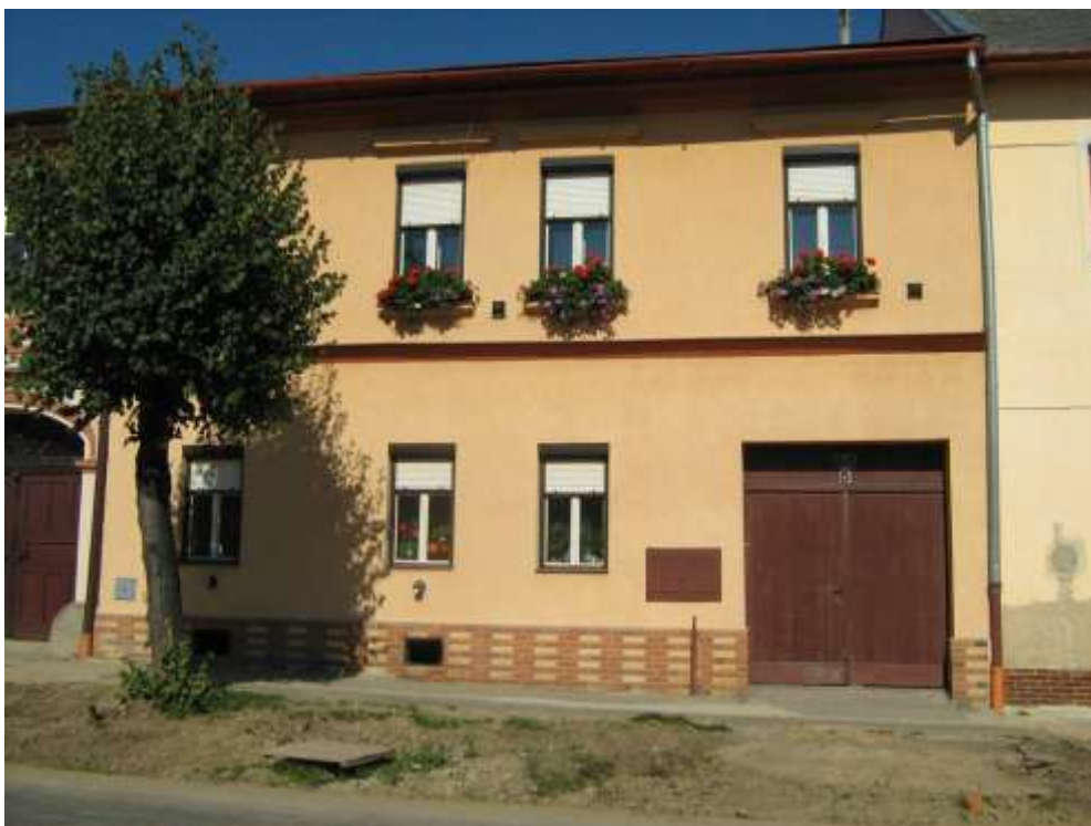
337. Slnčná ulica č. 5, parc. č. 654, 09/2010 – objekt s pamiatkovými hodnotami, vytypovaný na zápis do ÚZPF
