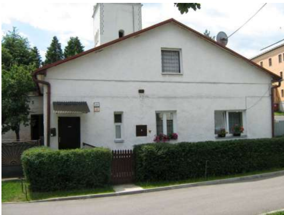
264. Petzvalova ulica č. 23, parc. č. 1063, 09/2010 – objekt rešpektujúci pamiatkové hodnoty územia, svojím situovaním, hmotovo – priestorovým usporiadaním, vyžadujúci úpravu architektonického vzhľadu
