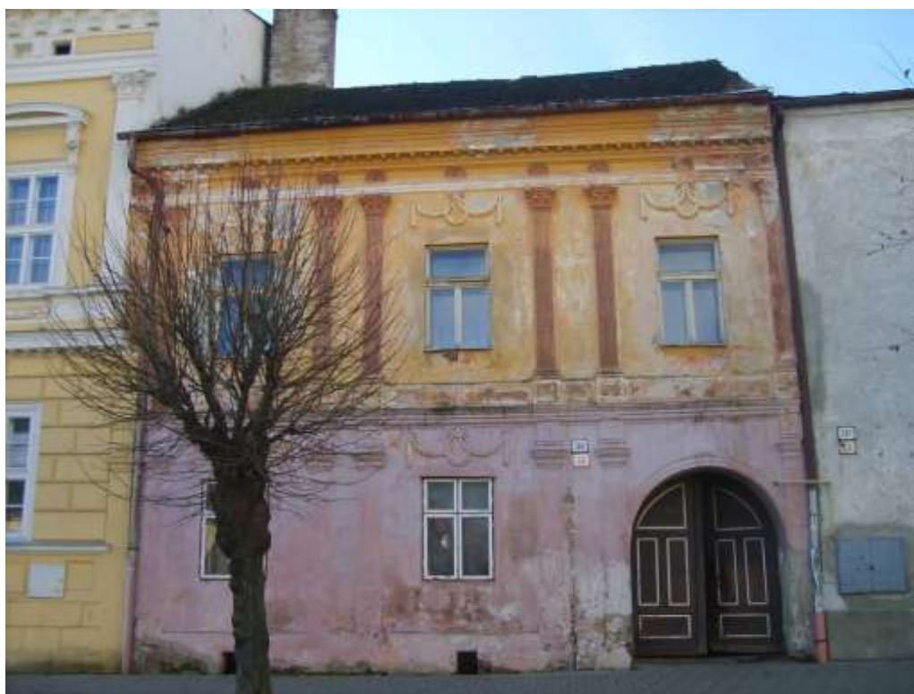
213. Hviezdoslavova ulica č. 20, parc. č. 1268, 10/2010 – objekt NKP
