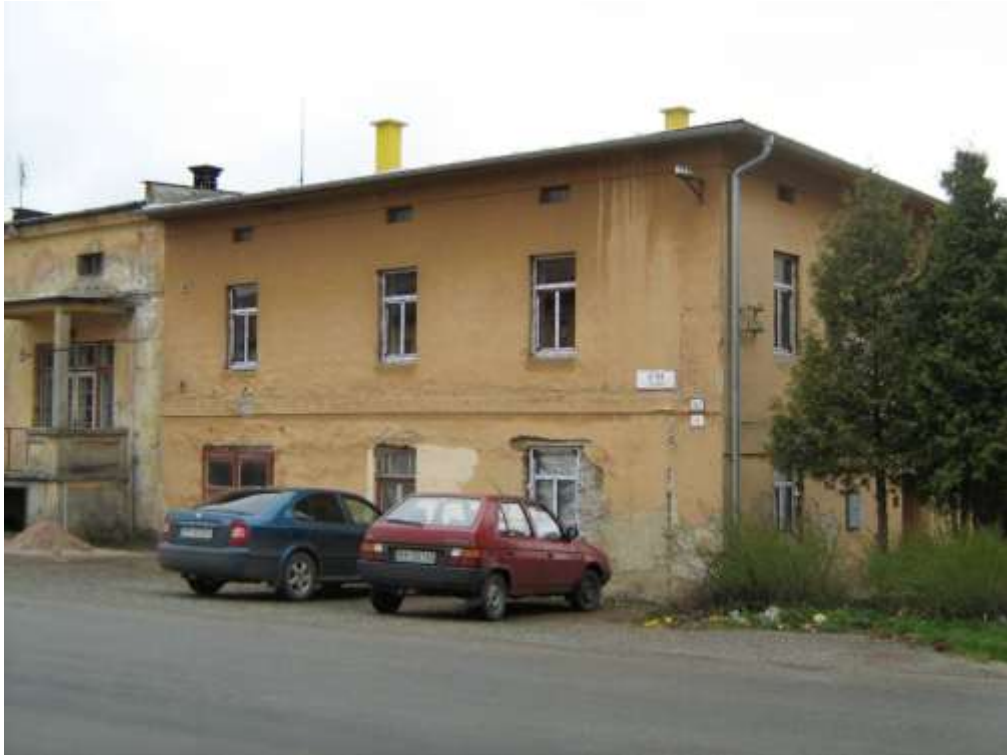
388. Letná ulica č. 17, parc. č. 1036/1, 2008 – objekt rešpektujúci pamiatkové hodnoty územia svojím situovaním, hmotovo – priestorovým usporiadaním a architektonickým stvárnením
