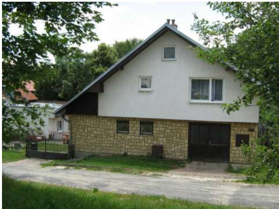
417. Letná ulica, súp. č. 887, parc. č. 1868/17, 09/2010 – objekt rešpektujúci pamiatkové hodnoty územia svojím situovaním a hmotovo – priestorovým usporiadaním
