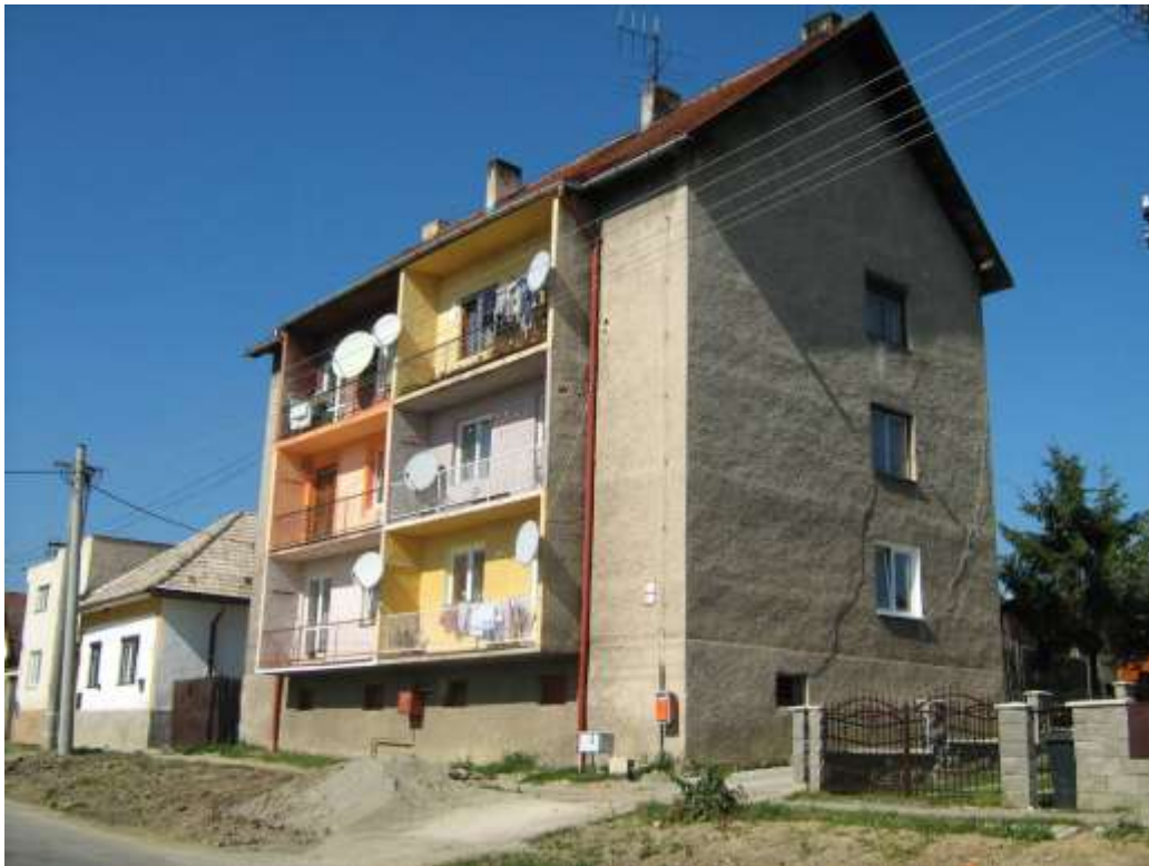
367. Slnčná ulica č. 35, parc. č. 735/1, 09/2010 – objekt nerešpektujúci pamiatkové hodnoty územia, svojím situovaním a hmotovo – priestorovým usporiadaním
