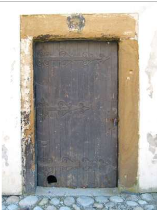
470. Petzvalova ulica, zvonica, kamenný portál vstupného otvoru, 11/2012
