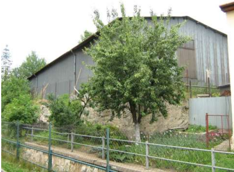
390. Letná ulica, súp. č. 280, parc. č. 1035/4, 09/2010 – objekt nerešpektujúci pamiatkové hodnoty územia svojím hmotovo – priestorovým usporiadaním a materiálovým riešením
