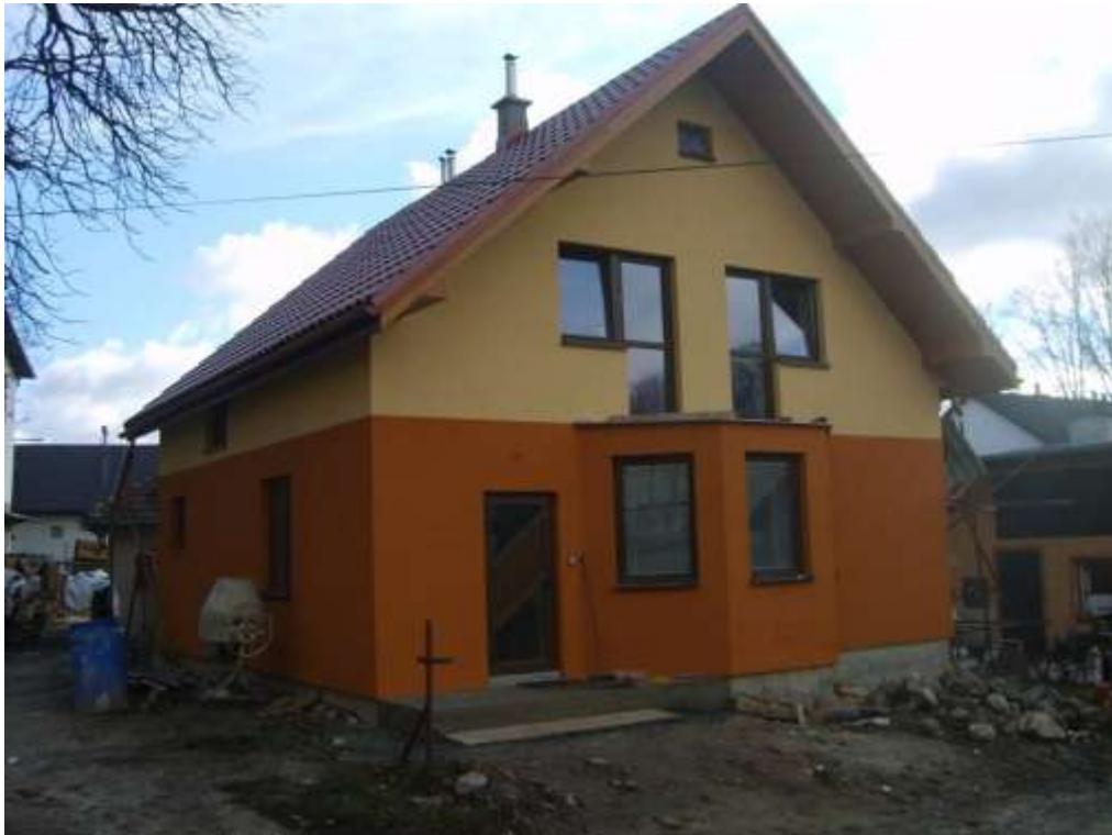
411. Letná ulica, parc. č. 998, 999, 09/2010 – objekt rešpektujúci pamiatkové hodnoty územia svojím situovaním a hmotovo – priestorovým usporiadaním
