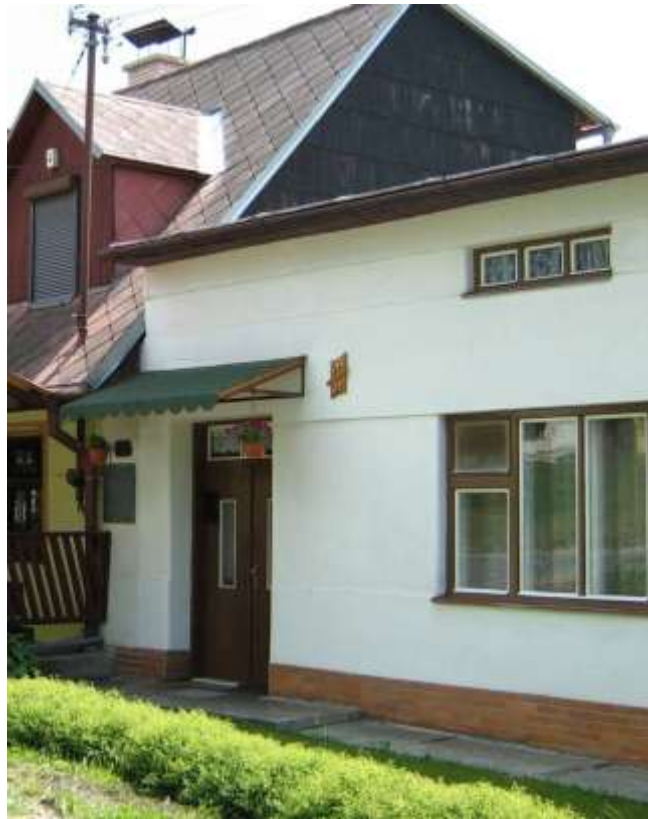
400. Letná ulica č. 31, parc. č. 1019, 09/2010 – objekt rešpektujúci pamiatkové hodnoty územia svojím situovaním a hmotovo – priestorovým usporiadaním
