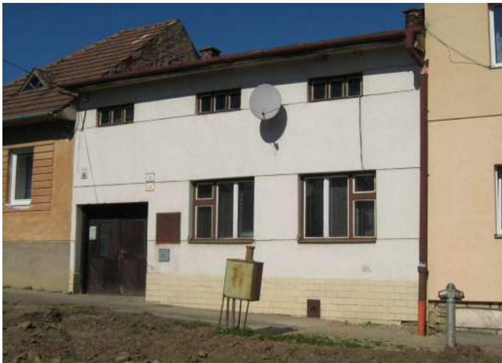
360. Slnčná ulica č. 28, parc. č. 715, 09/2010 – objekt rešpektujúci pamiatkové hodnoty územia svojim situovaním, hmotovo – priestorovým usporiadaním, vyžadujúci úpravu architektonického vzhľadu (zastrešenie)
