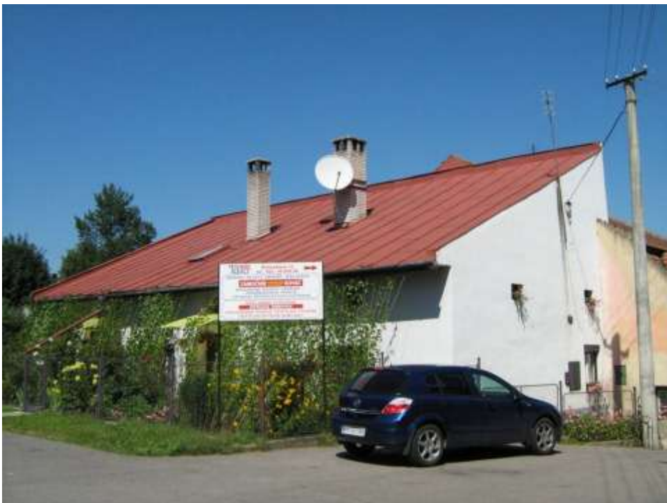
255. Petzvalova ulica č. 11, parc. č. 20/1, 09/2010 – objekt rešpektujúci pamiatkové hodnoty územia svojím situovaním, hmotovo – priestorovým riešením
