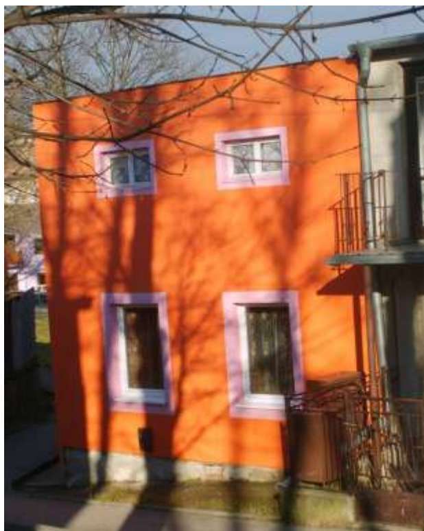
284. Petzvalova ulica č.52, parc. č. 1101/1, 11/2010 – objekt rešpektujúci pamiatkové hodnoty územia svojím situovaním, hmotovo – priestorovým usporiadaním, vyžadujúci úpravu architektonického vzhľadu (farebnosť fasády, úprava okenných otvorov)
