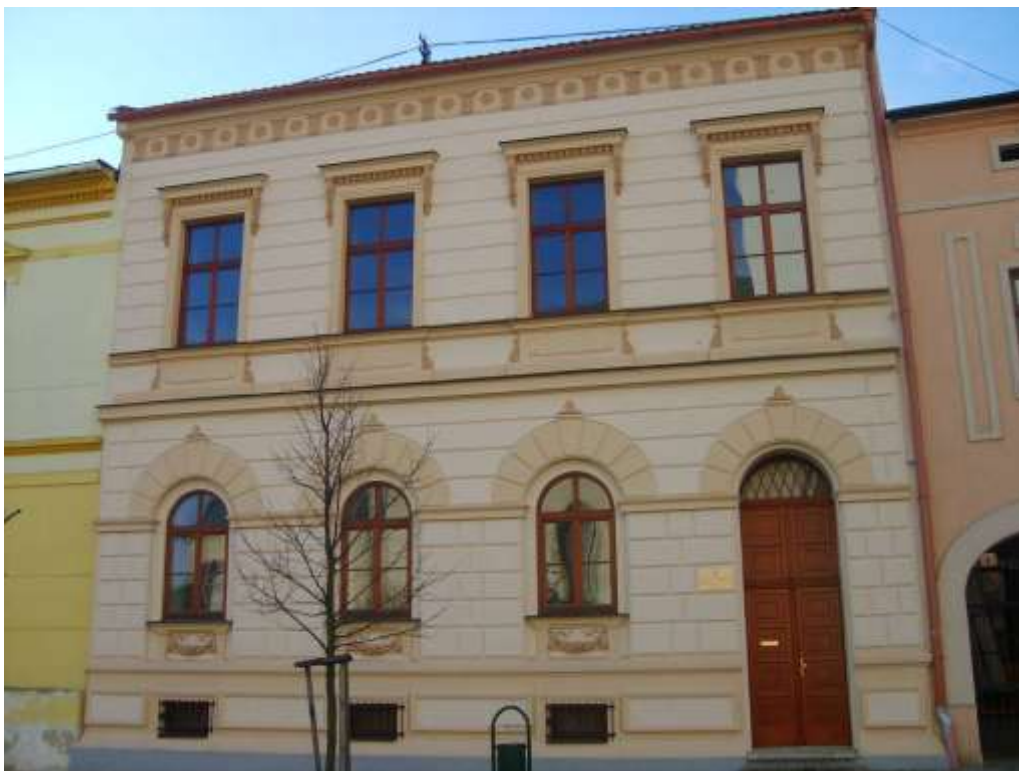
209. Hviezdoslavova ulica č. 16, parc. č. 1278, 10/2010 - objekt s pamiatkovými hodnotami vytypovaný na zápis do ÚZPF, zapísaný v zozname pamätihodností mesta
