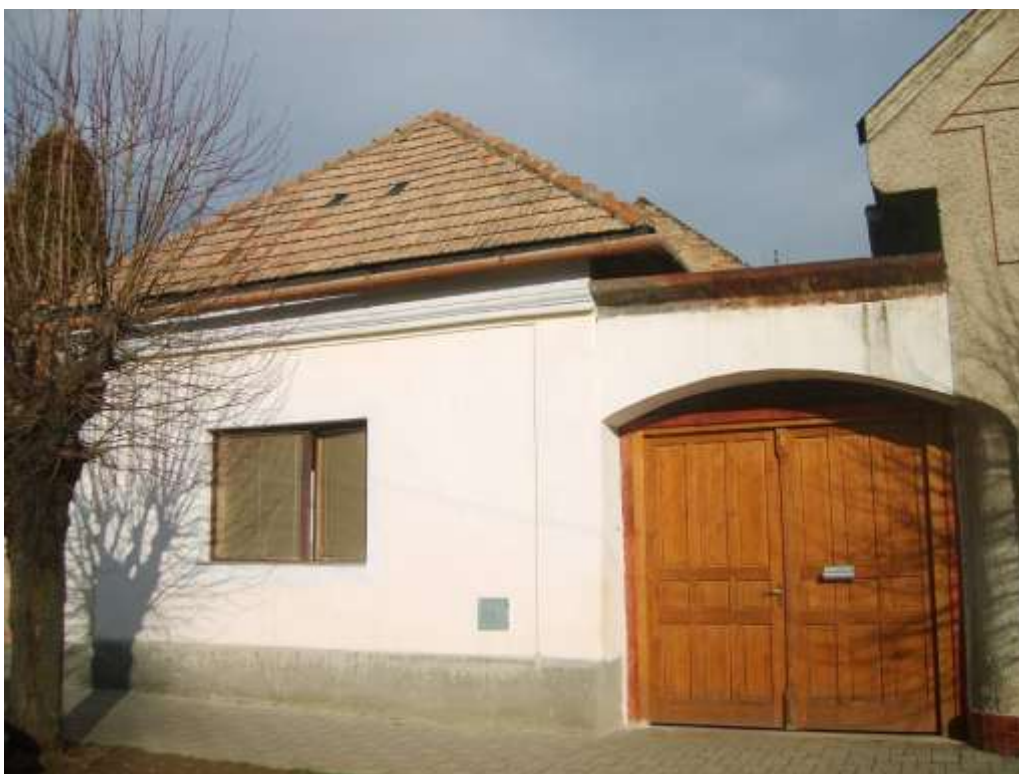
328. Štefánikova ulica č. 35, parc. č. 492, 11/2010 – objekt rešpektujúci pamiatkové hodnoty územia svojím situovaním, hmotovo – priestorovým usporiadaním a architektonickým stvárnením, vyžadujúci úpravu osovosti hlavnej fasády
