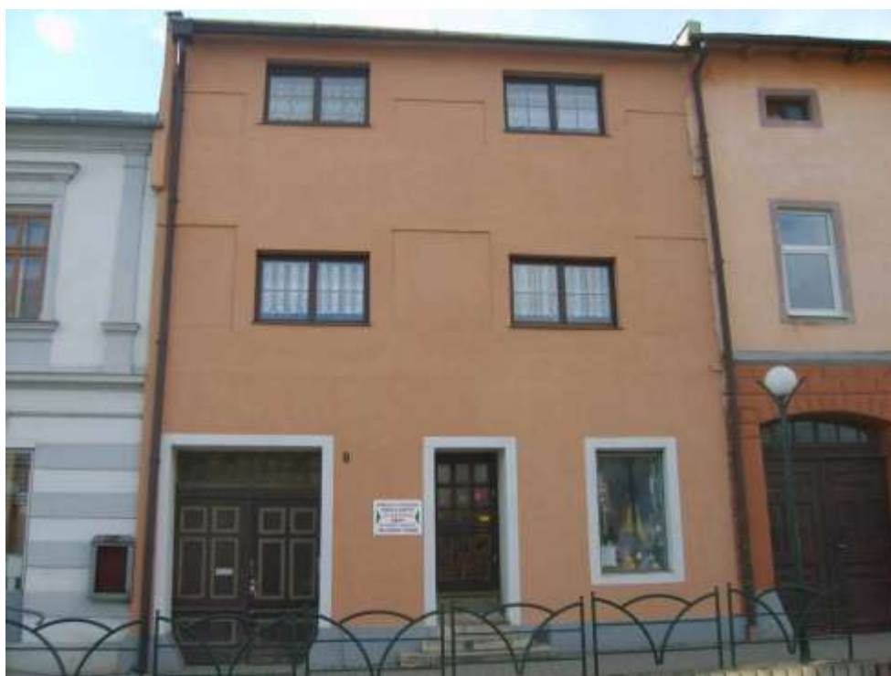
177. Zimná ulica č. 9, parc. č. 72/1, 11/2010 - objekt rešpektujúci pamiatkové hodnoty územia svojím situovaním a hmotovo - priestorovým riešením, vyžadujúci úpravu architektonického vzhľadu (fasáda, okenné otvory)
