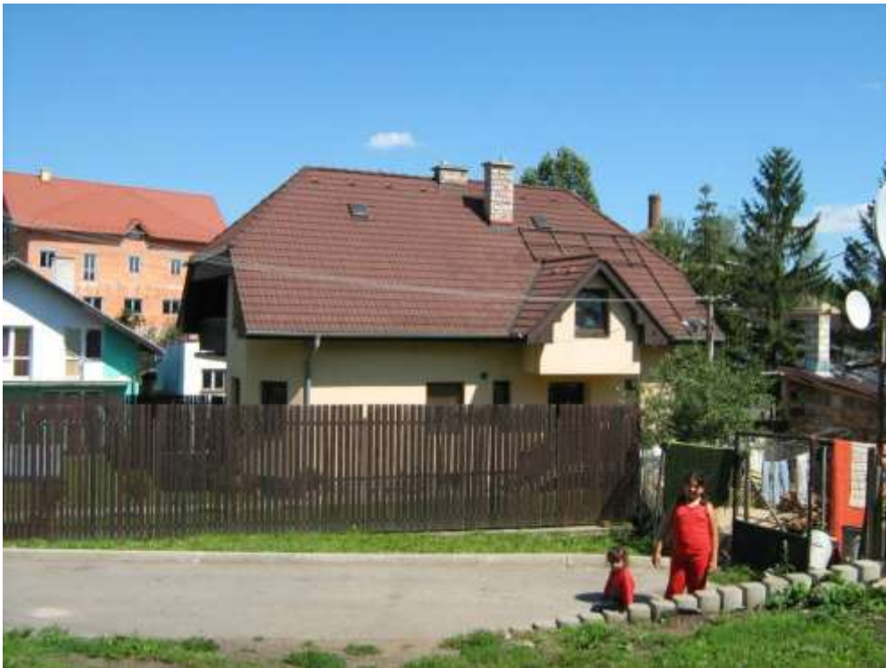
266. Petzvalova ulica, parc. č. 1066/3, 09/2010 – objekt rešpektujúci pamiatkové hodnoty územia svojím situovaním, hmotovo – priestorovým usporiadaním
