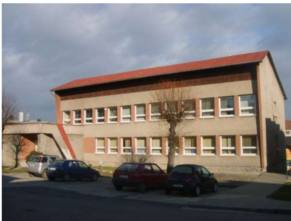
275. Petzvalova ulica č.37, parc. č. 1080/1, 11/2010 - objekt nerešpektujúci pamiatkové hodnoty územia svojím hmotovo – priestorovým usporiadaním
