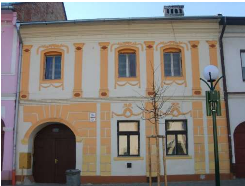
226. Hviezdoslavova ulica č. 34, parc. č. 1222, 10/2010 – objekt NKP
