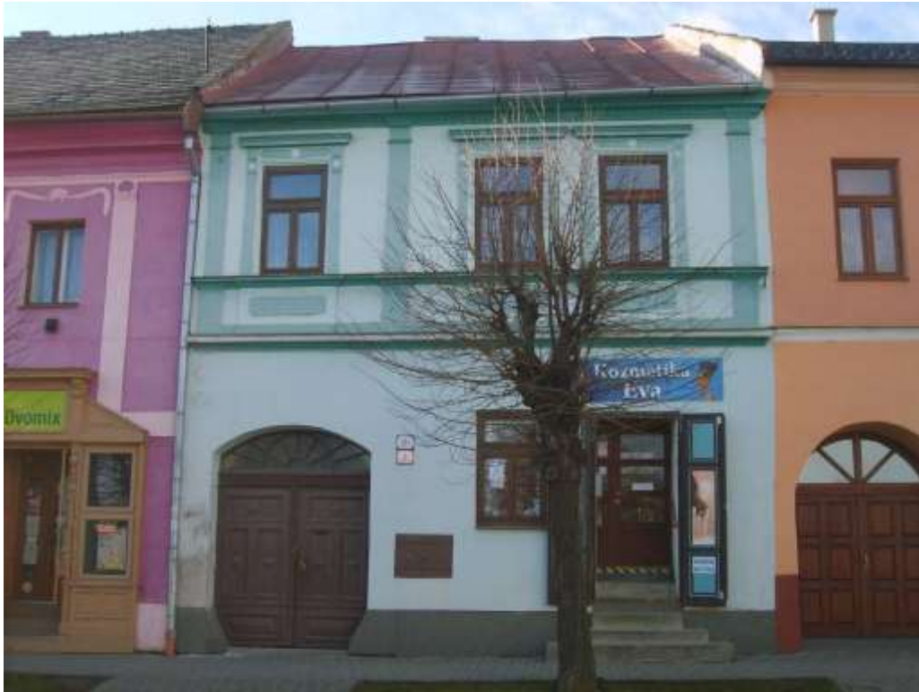
196. Hviezdoslavova ulica č. 3, parc. č. 1308/1, 10/2010 - objekt s pamiatkovými hodnotami vytypovaný na zápis do ÚZPF
