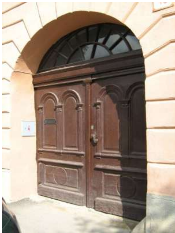
482. Slnecná ulica č. 16, drevená výplň vstupnej brány do prejazdu hlavnej/južnej fasády, 2
