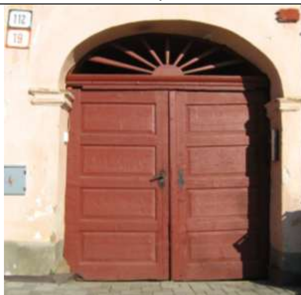
484. Slnecná ulica č. 19, drevená výplň vstupného otvoru do prejazdu hlavnej/južnej fasády 11/2012
