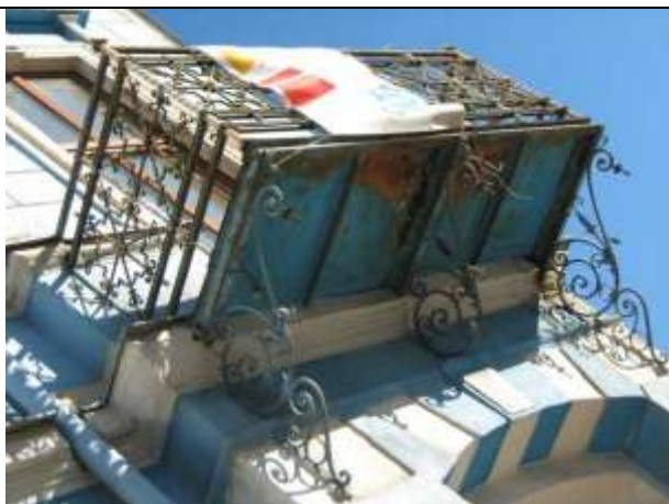
469. Petzvalova ulica č. 16, balkón hlavnej/južnej fasády, 11/2012
