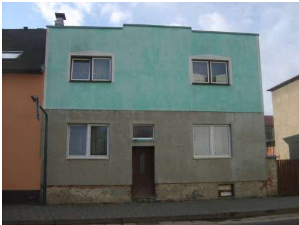
193. Zimná ulica č. 26, parc. č. 54, 11/2010 - objekt rešpektujúci pamiatkové hodnoty územia, svojim situovaním a hmotovo –priestorovým riešením, vyžadujúci úpravu architektonického vzhľadu (fasáda, zastrešenie, otvory)
