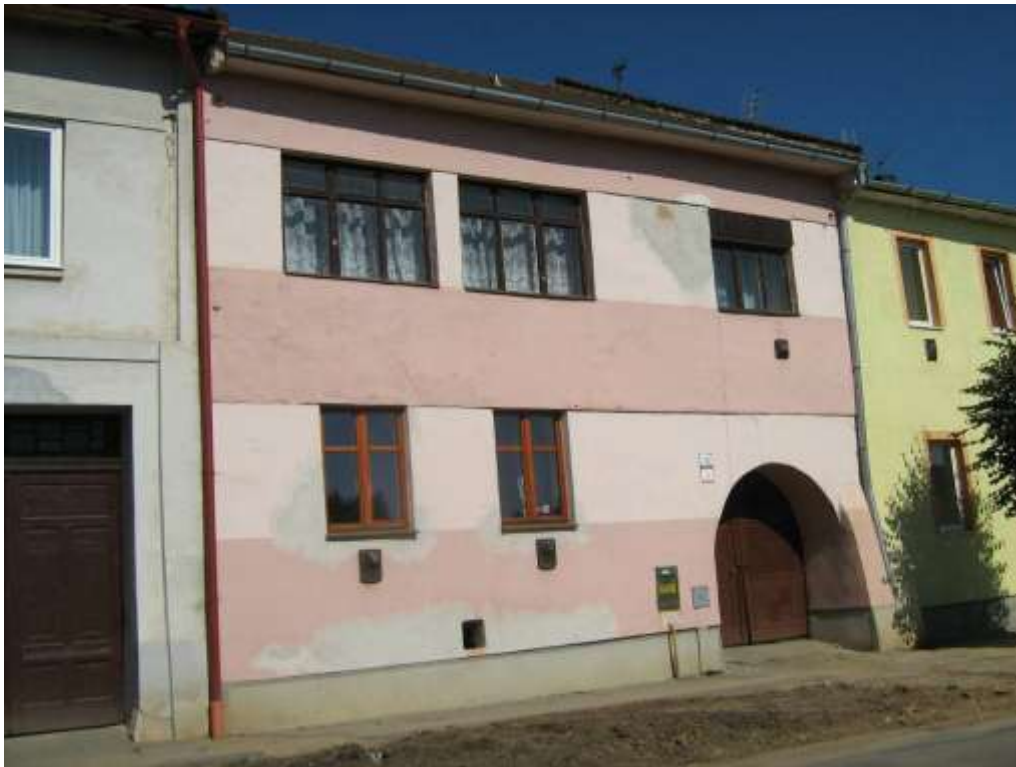
341. Slnčná ulica č. 9, parc. č. 667, 09/2010 – objekt s pamiatkovými hodnotami, vytypovaný na zápis do ÚZPF
