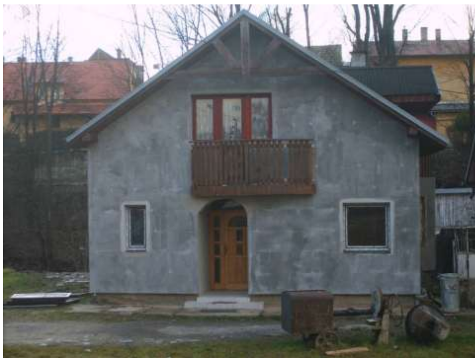
407. Letná ulica č. 40, parc. č. 1007/1, 11/2010 – objekt rešpektujúci pamiatkové hodnoty územia svojím situovaním a hmotovo – priestorovým usporiadaním, vyžadujúci úpravu architektonického vzhľadu
