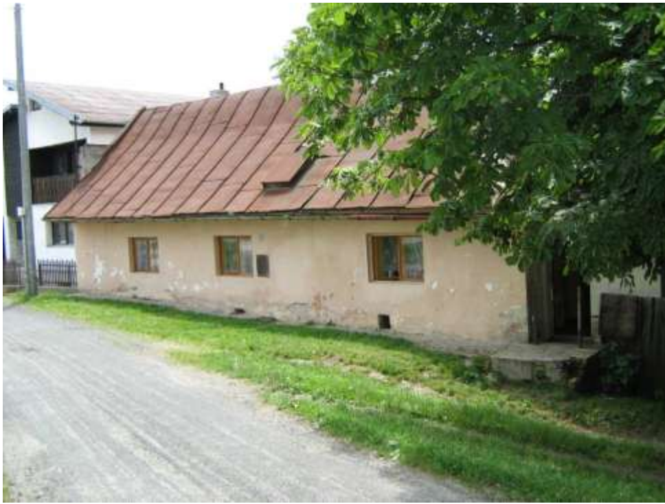
414. Letná ulica č. 61, parc. č. 996, 09/2010 – objekt s pamiatkovými hodnotami
