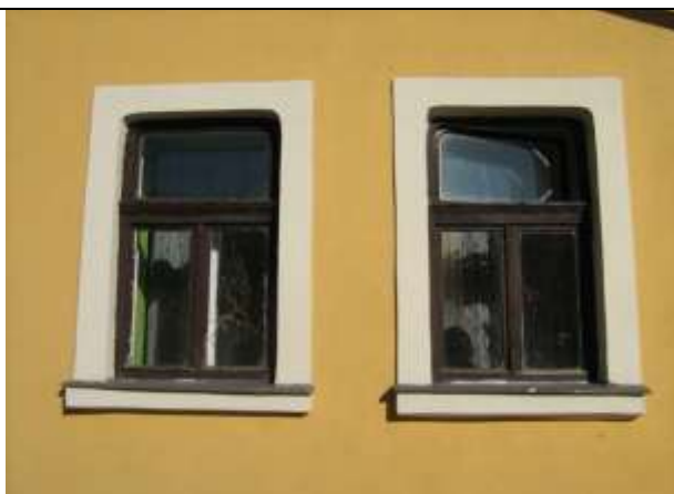
475. Štefánikova ulica č. 22, výplne okenných otvorov hlavnej/južnej fasády, 11/2012
