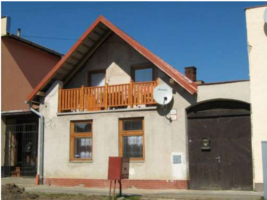
362. Slnčná ulica č. 30, parc. č. 722, 09/2010 – objekt rešpektujúci pamiatkové hodnoty územia svojím situovaním, hmotovo – priestorovým usporiadaním, vyžadujúci úpravu architektonického vzhľadu
