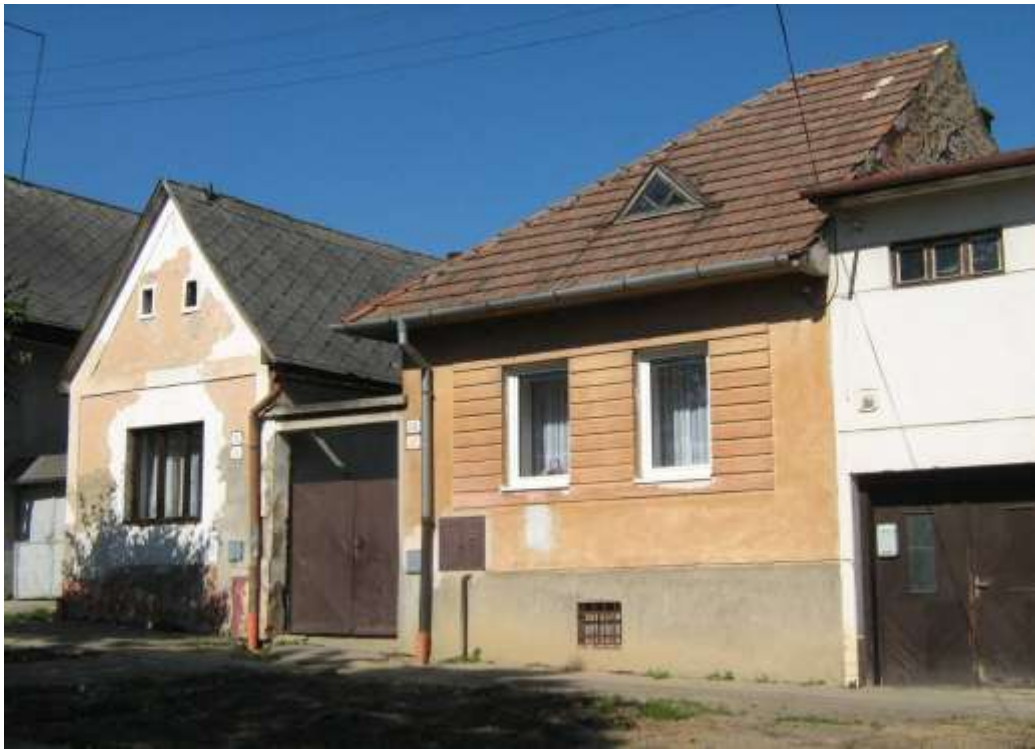
359. Slnčná ulica č. 27, parc. č. 712, 09/2010 – objekt rešpektujúci pamiatkové hodnoty územia, svojim situovaním, hmotovo – priestorovým usporiadaním, vyžadujúci úpravu architektonického vzhľadu (okná, brána)
