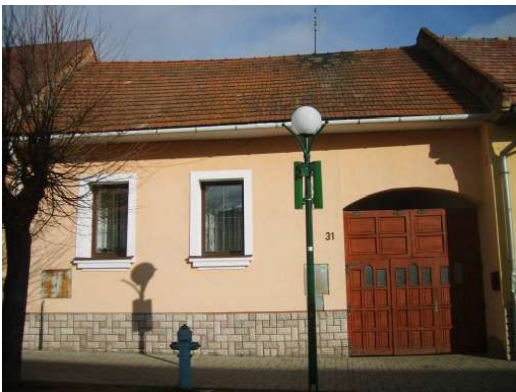
324. Štefánikova ulica č. 31, parc. č. 499, 11/2010 – objekt rešpektujúci pamiatkové hodnoty územia svojím situovaním, hmotovo – priestorovým usporiadaním a architektonickým stvárnením, vyžadujúci úpravu členenia okenných otvorov
