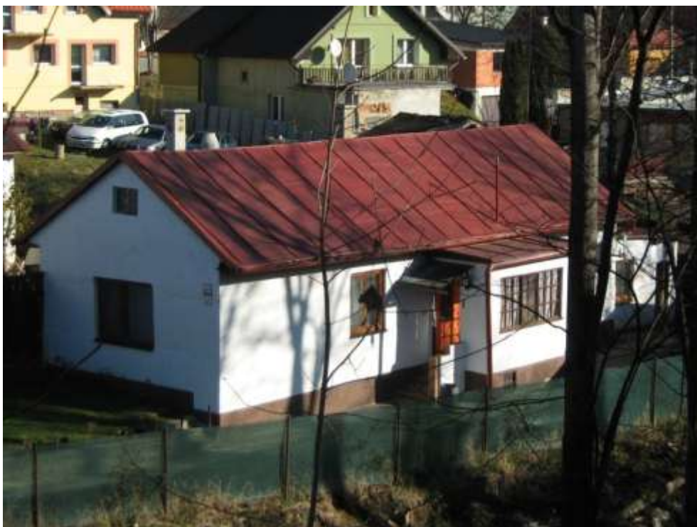
408. Letná ulica č. 42, 11/2012 – objekt rešpektujúci pamiatkové hodnoty územia svojím situovaním, hmotovo – priestorovým usporiadaním a architektonickým stvárnením
