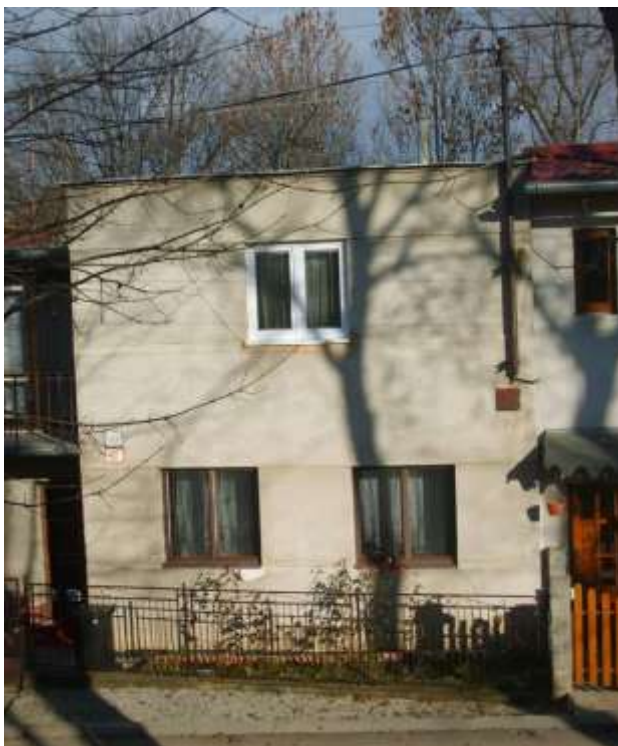
285. Petzvalova ulica č.53, parc. č. 1102, 11/2010 – objekt rešpektujúci pamiatkové hodnoty územia svojím situovaním, hmotovo – priestorovým usporiadaním, vyžadujúci úpravu architektonického vzhľadu (fasáda)
