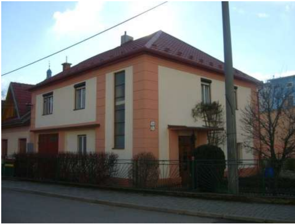
376. Letná ulica č. 3, parc. č. 7, 11/2010 – objekt rešpektujúci pamiatkové hodnoty územia, svojim situovaním, hmotovo – priestorovým usporiadaním a architektonickým stvárnením
