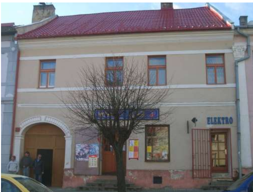
201. Hviezdoslavova ulica č. 8, parc. č. 1299, 10/2010 - objekt s pamiatkovými hodnotami vytypovaný na zápis do ÚZPF, zapísaný v zozname pamätihodností mesta
