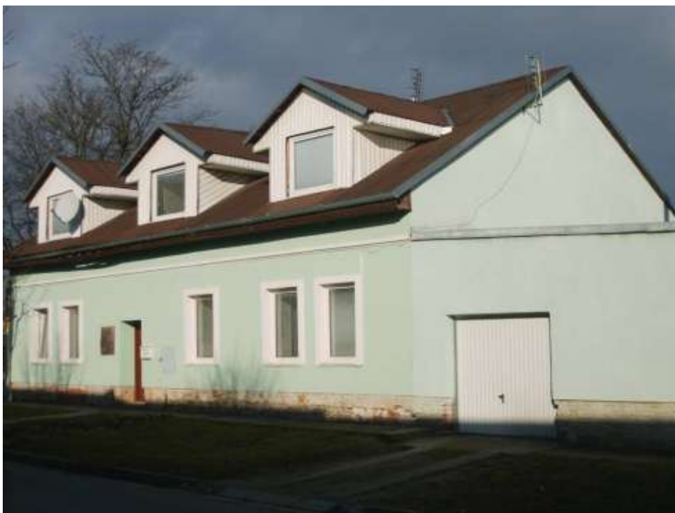
288. Petzvalova ulica č.58, parc. č. 1110, 11/2010 – objekt rešpektujúci pamiatkové hodnoty územia svojím situovaním, hmotovo – priestorovým usporiadaním, vyžadujúci úpravu architektonického vzhľadu (fasáda, strešná krytina, vikiere, výplne otvorov)
