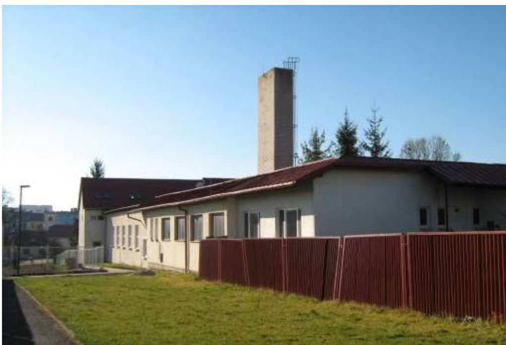
314. Štefánikova ulica, areál základnej školy – telocvičňa, kotolňa, 11/2012 - objekty nerešpektujúci pamiatkové hodnoty územia svojím situovaním, hmotovo – priestorovým usporiadaním
