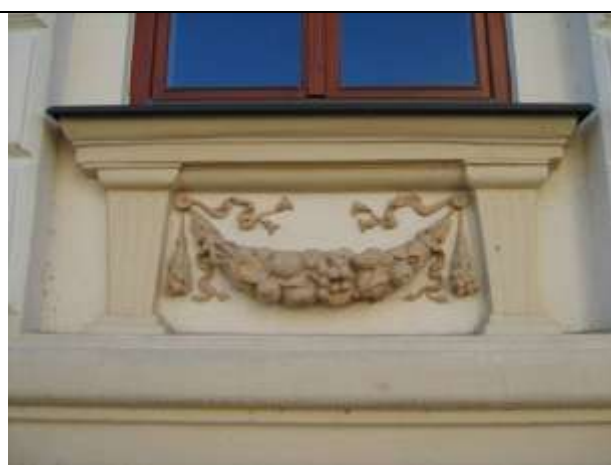
459. Hviezdoslavova 16, detail architektonickej výzdoby, 11/2012
