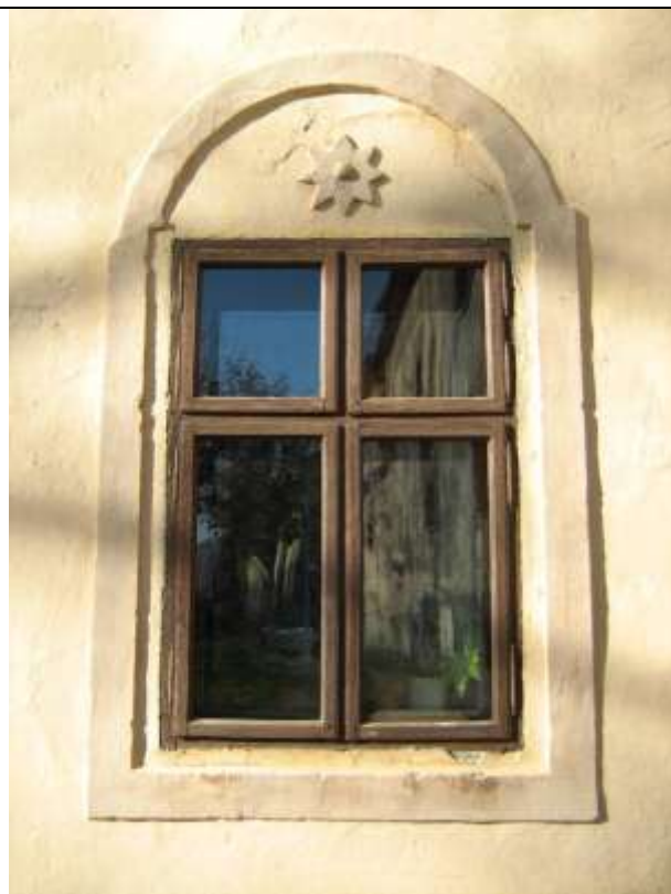
474. Štefánikova ulica č. 17, výplň okenného otvoru a architektonická výzdoba východnej fasády, 11/2012
