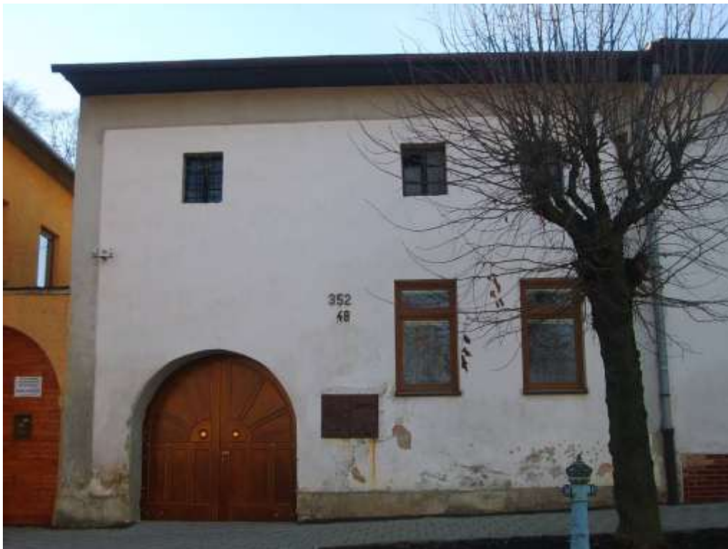
240. Hviezdoslavova ulica č. 48, parc. č. 1167, 10/2010 – objekt NKP
