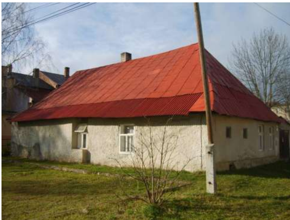
374. Letná ulica č. 1, parc. č. 27, 11/2010 – objekt s pamiatkovými hodnotami
