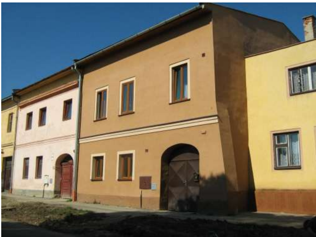
352. Slnecná ulica č. 20, parc. č. 688, 09/2010 – objekt s pamiatkovými hodnotami, vytypovaný na zápis do ÚZPF
