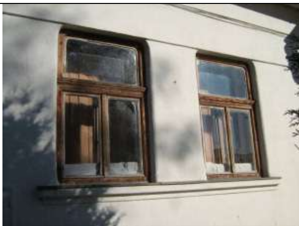
473. Štefánikova ulica č. 5, výplne okenných otvorov hlavnej/južnej fasády, 11/2012
