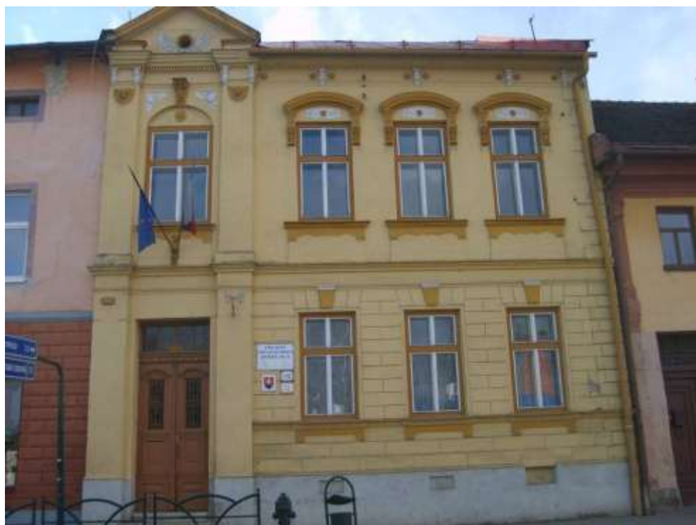
179. Zimná ulica č. 12, parc. č. 70, 11/2010 - objekt s pamiatkovými hodnotami vytypovaný na zápis do ÚZPF, zapísaný v zozname pamätihodností mesta
