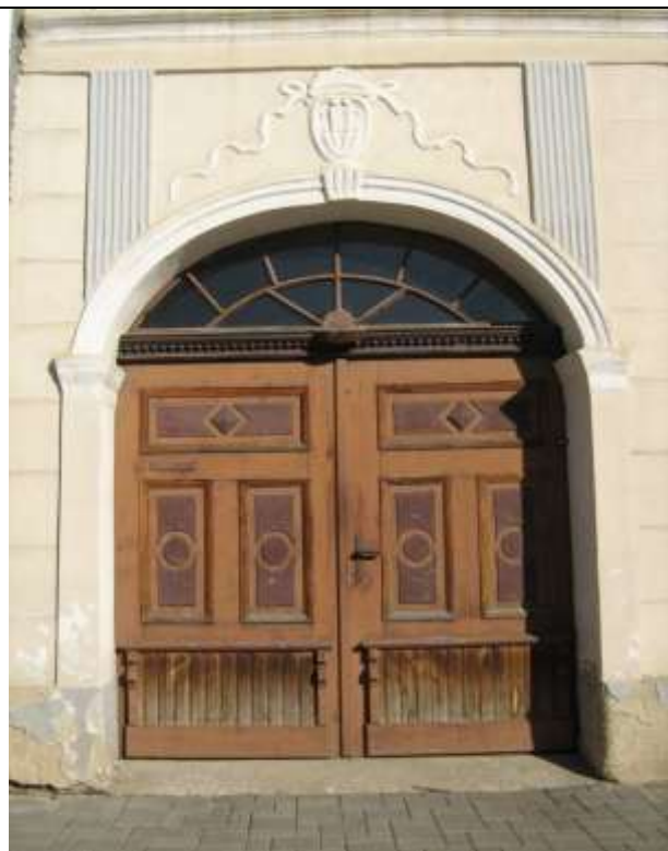
481. Slnecná ulica č. 3, drevená výplň vstupnej brány do prejazdu hlavnej/južnej fasády, 11/2012
