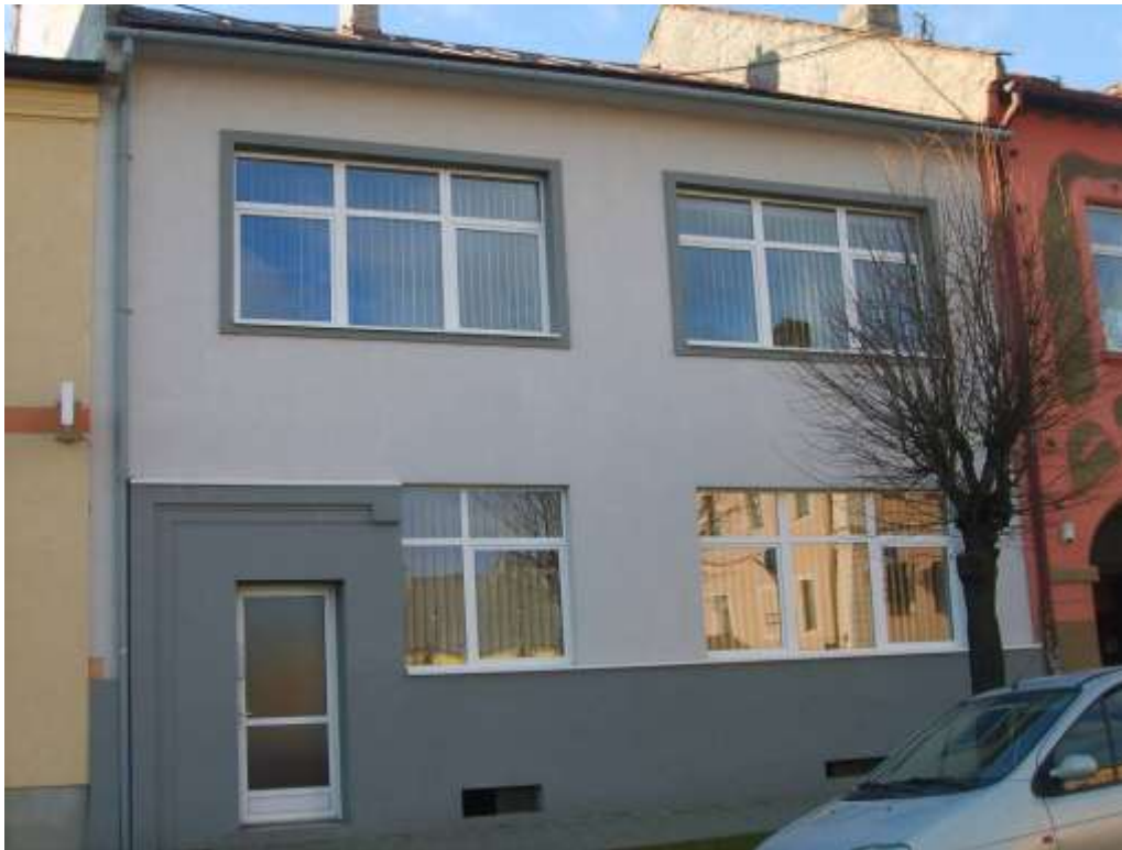
204. Hviezdoslavova ulica č. 11, parc. č. 1291, 10/2010 – objekt rešpektujúci pamiatkové hodnoty územia svojím situovaním, hmotovo - priestorovým riešením a architektonickým stvárnením
