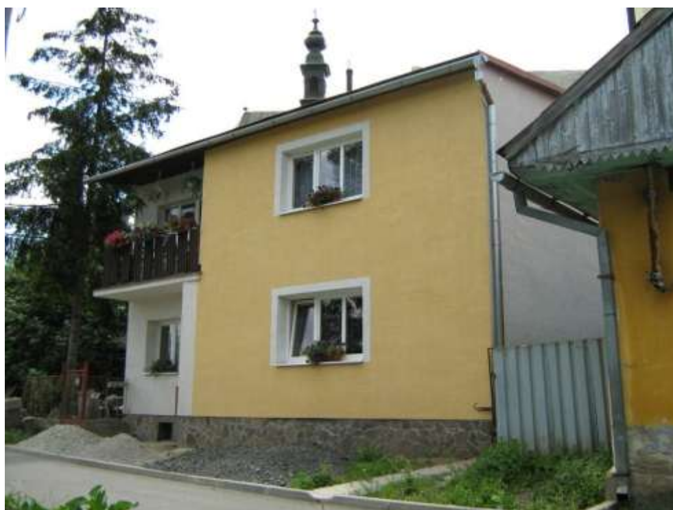
265. Petzvalova ulica č. 25, parc. č. 1065, 09/2010 – objekt rešpektujúci pamiatkové hodnoty územia svojím situovaním, hmotovo – priestorovým usporiadaním
