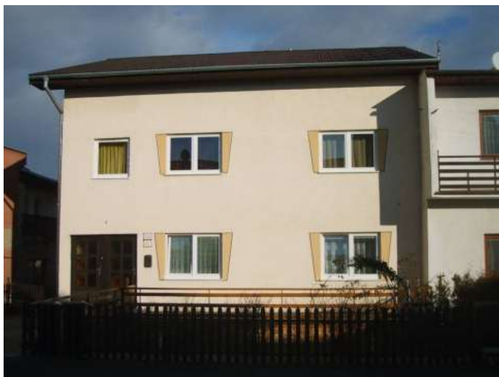
279. Petzvalova ulica č.47, parc. č. 1093/1, 11/2010 – objekt rešpektujúci pamiatkové hodnoty územia svojím situovaním, hmotovo – priestorovým usporiadaním
