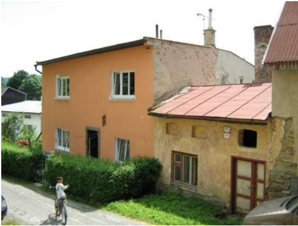
398. Letná ulica č. 29, 28, parc. č. 1022/1, 1023, 09/2010 – objekty rešpektujúce pamiatkové hodnoty územia svojím situovaním a hmotovo – priestorovým usporiadaním, vyžadujúce úpravu architektonického vzhľadu
