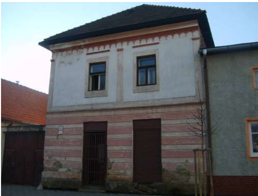
232. Hviezdoslavova ulica č. 40, parc. č. 1191, 10/2010 - objekt s pamiatkovými hodnotami vytypovaný na zápis do ÚZPF
