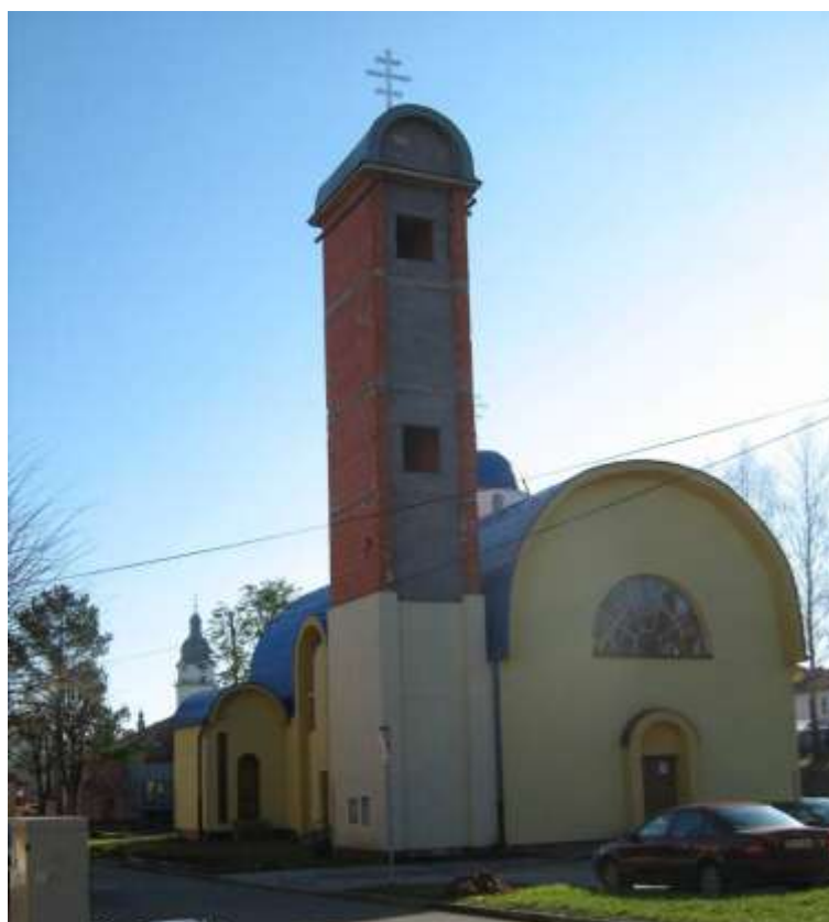
375. Letná ulica, parc. č. 24, 11/2010 – objekt nerešpektujúci pamiatkové hodnoty územia svojím hmotovo – priestorovým usporiadaním a architektonickým stvárnením
