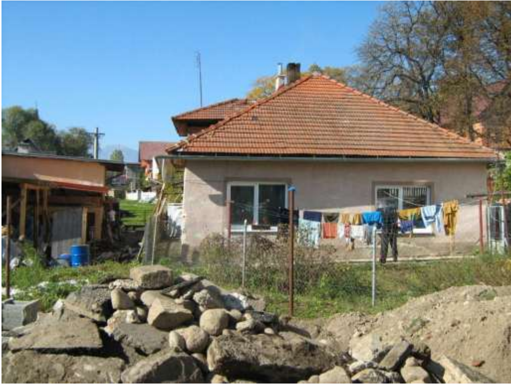
410. Letná ulica č. 47, parc. č. 1000, 09/2010 – objekt rešpektujúci pamiatkové hodnoty územia svojím situovaním a hmotovo – priestorovým usporiadaním
