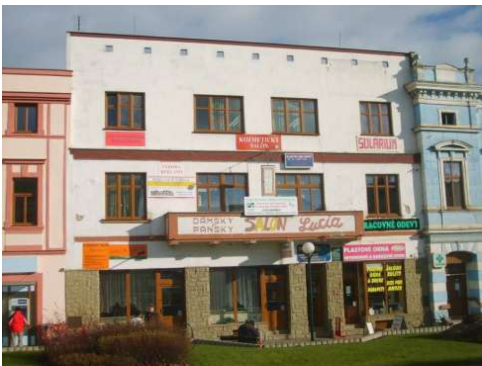
259. Petzvalova ulica č. 15, parc. č. 12, 11/2010 – objekt rešpektujúci pamiatkové hodnoty územia, svojím situovaním, hmotovo – priestorovým usporiadaním a architektonickým stvárnením
