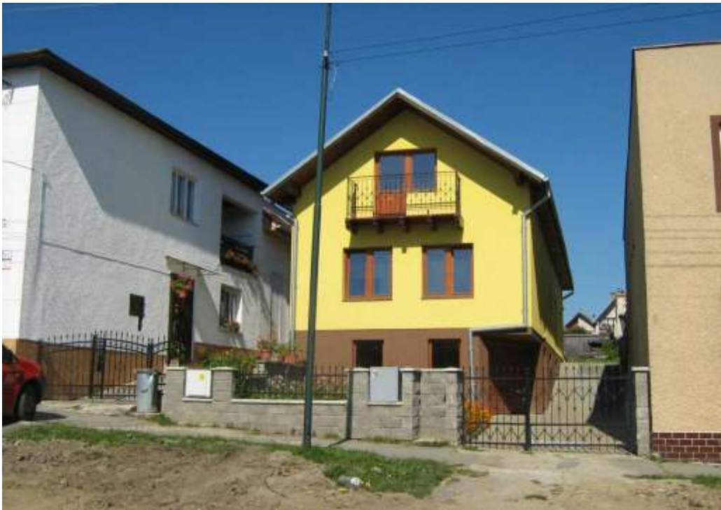
369. Slnčná ulica č. 38, parc. č. 745, 747/2, 09/2010 – objekt nerešpektujúci pamiatkové hodnoty územia, s hlavnou fasádou nerešpektujúcou osadenie na uličnú čiaru
