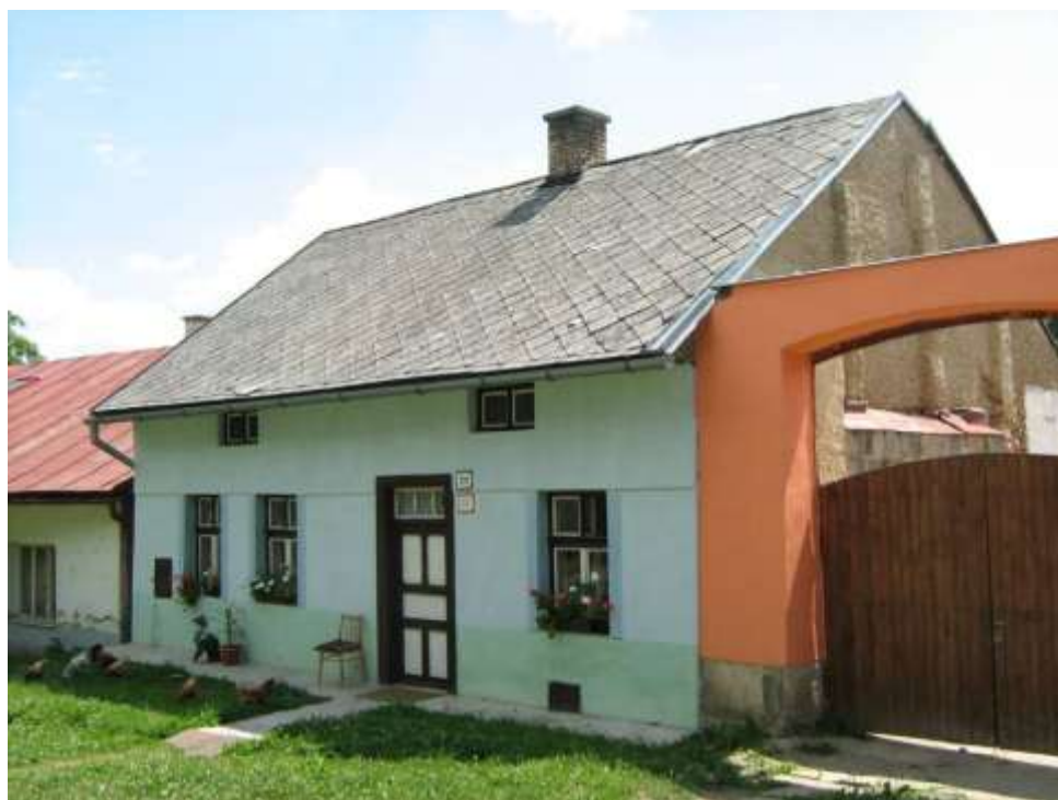
403. Letná ulica č. 35, parc. č. 1015, 09/2010 – objekt s pamiatkovými hodnotami
