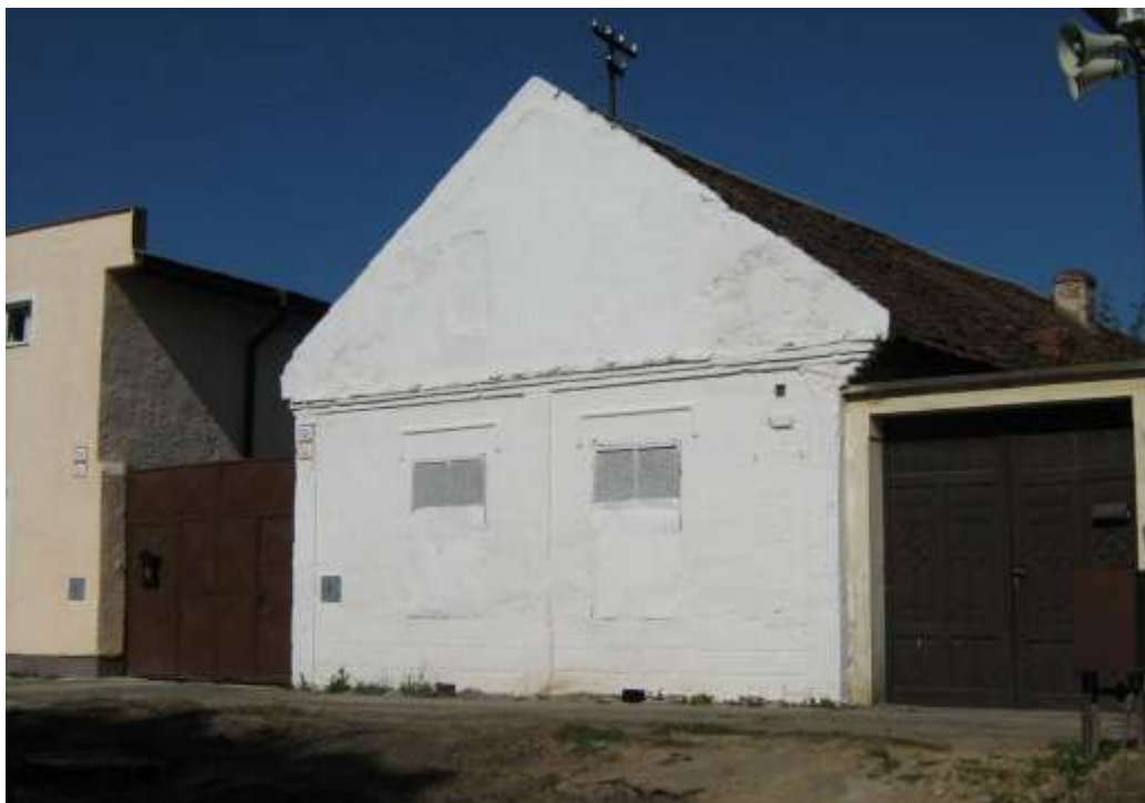
364. Slnčná ulica č. 32, parc. č. 727/1, 09/2010 – objekt rešpektujúci pamiatkové hodnoty územia svojím situovaním, hmotovo – priestorovým usporiadaním architektonickým stvárnením
