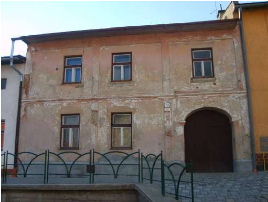
242. Hviezdoslavova ulica č. 50, parc. č. 1160, 10/2010 - objekt NKP
