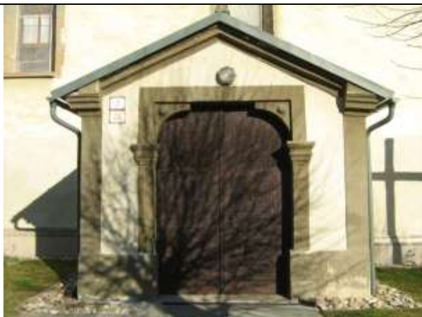
471. Petzvalova ulica č. 20, Rímskokatolícky kostol sv. Antona Pustovníka, kamenný portál vstupného otvoru južnej predsiene, 11/2012
