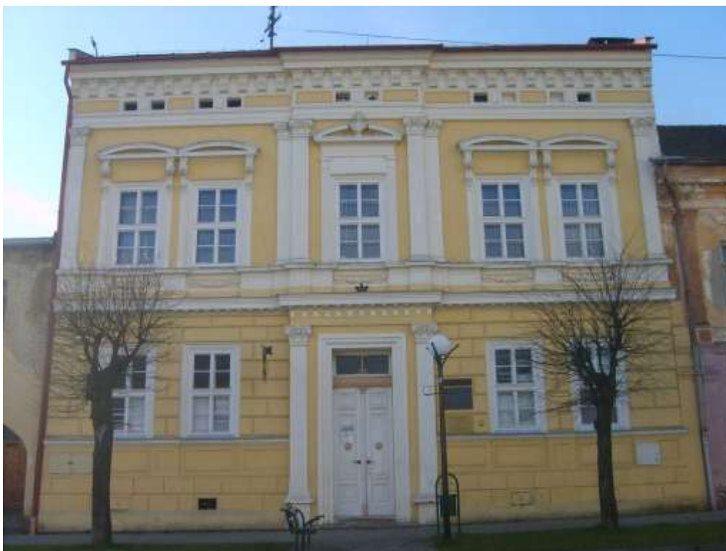
214. Hviezdoslavova ulica č. 21, parc. č. 1265, 10/2010 – objekt NKP
