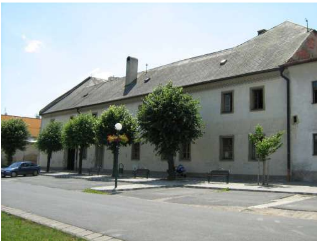
220. Hviezdoslavova ulica č. 27, parc. č. 1252, 07/2008 – objekt NKP
