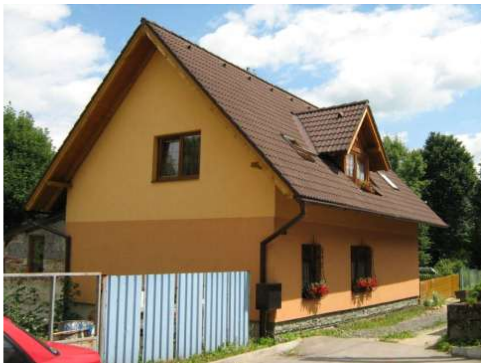
287. Petzvalova ulica č.55, parc. č. 1105/1, 09/2010 – objekt rešpektujúci pamiatkové hodnoty územia svojím situovaním, hmotovo – priestorovým usporiadaním a architektonickým stvárnením
