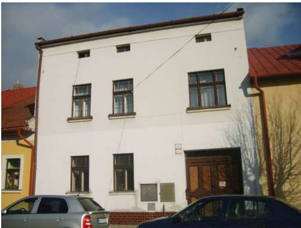
315. Štefánikova ulica č. 21, parc. č. 518/2, 11/2010 – objekt rešpektujúci pamiatkové hodnoty územia svojím situovaním, hmotovo – priestorovým usporiadaním a architektonickým stvárnením
