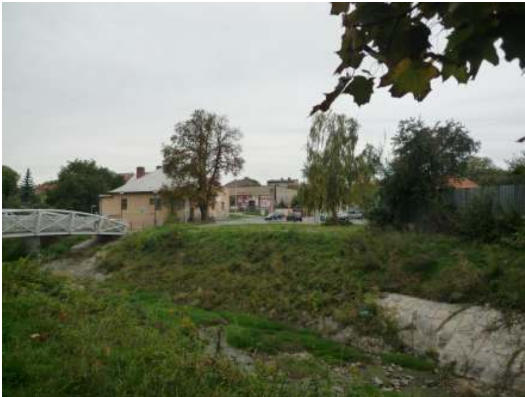
129. Súčasná úprava potoka pri Varni
