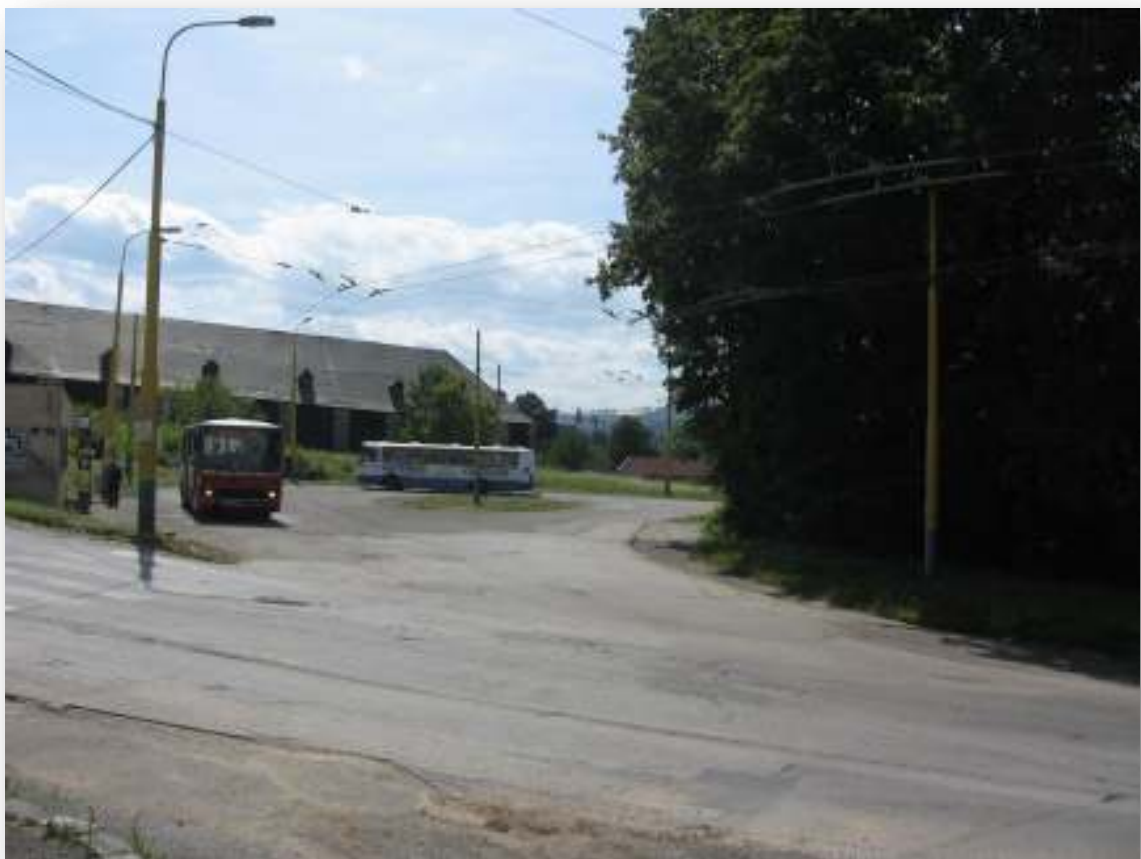
80. Križovatka Zlatobanskej ul. a Zborovskej ul. s nevhodným situovaním otočky trolejbusov
