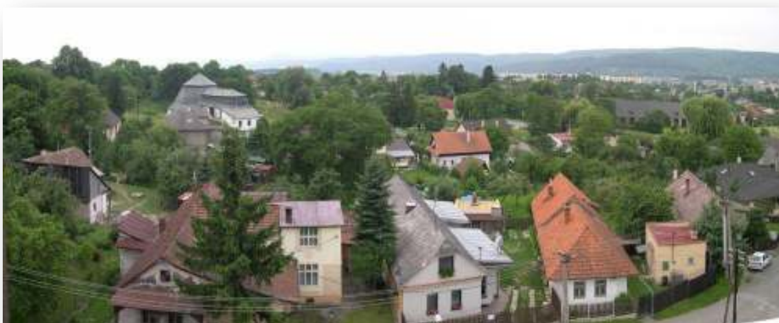
104. Pohľad z klopačky na Čipkársku ul., v popredí NKP ľudové domy č. 14 až 18
