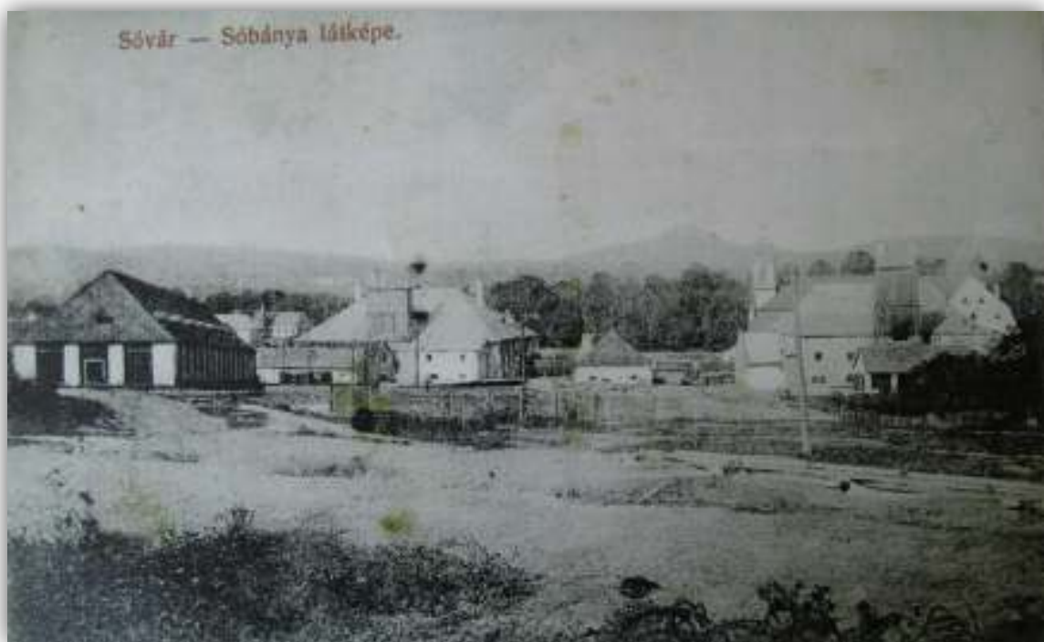
33a. Pohľad z terajšej ul. Zlatobanská smerom na SZ (četerne, strojovňa, varňa František, dielne, komory, varňa Ferdinand), 1. štvrtina 20. stor.
