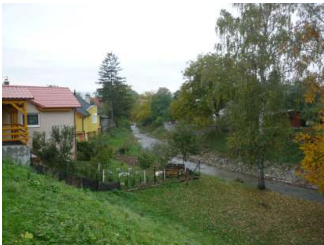
128. Novodobá úprava potoka v časti Pri Hati
