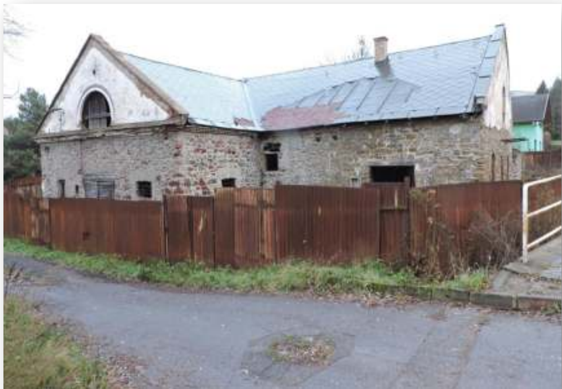
50b. Vozovňa, r. 2015
