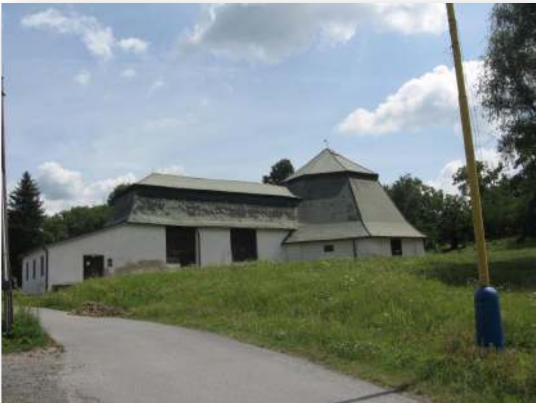
47b. Gápeľ, západná fasáda, r. 2009
