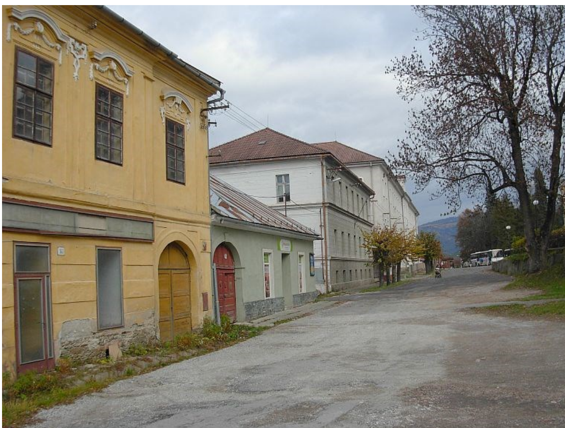
6. Pohľad zo začiatku Medenej ulice smerom na námestie
