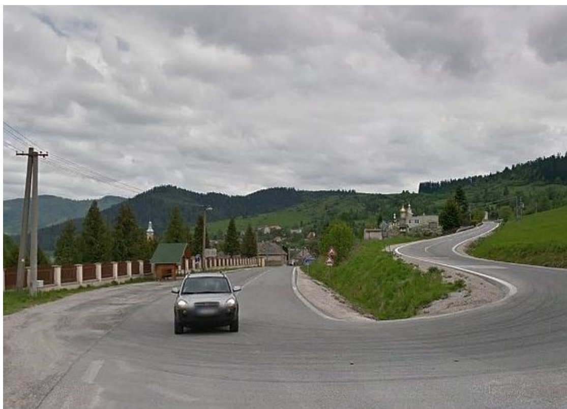
1. Pohľad z križovatky Uhorná - Štós smerom na východ
