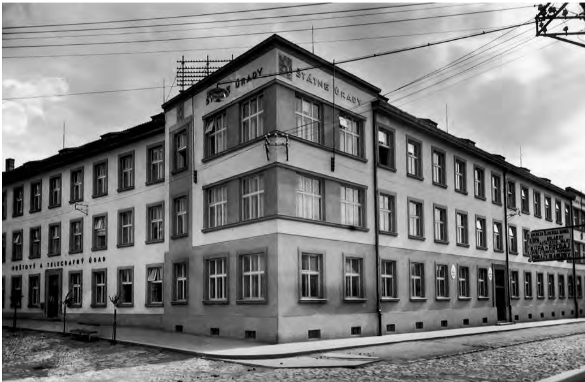
Budova Štátnych úradov na Lichardovej ulici, námestí a Jatočnej, 30.r.-pol.20.stor., (internetová stránka mesta Skalica)
