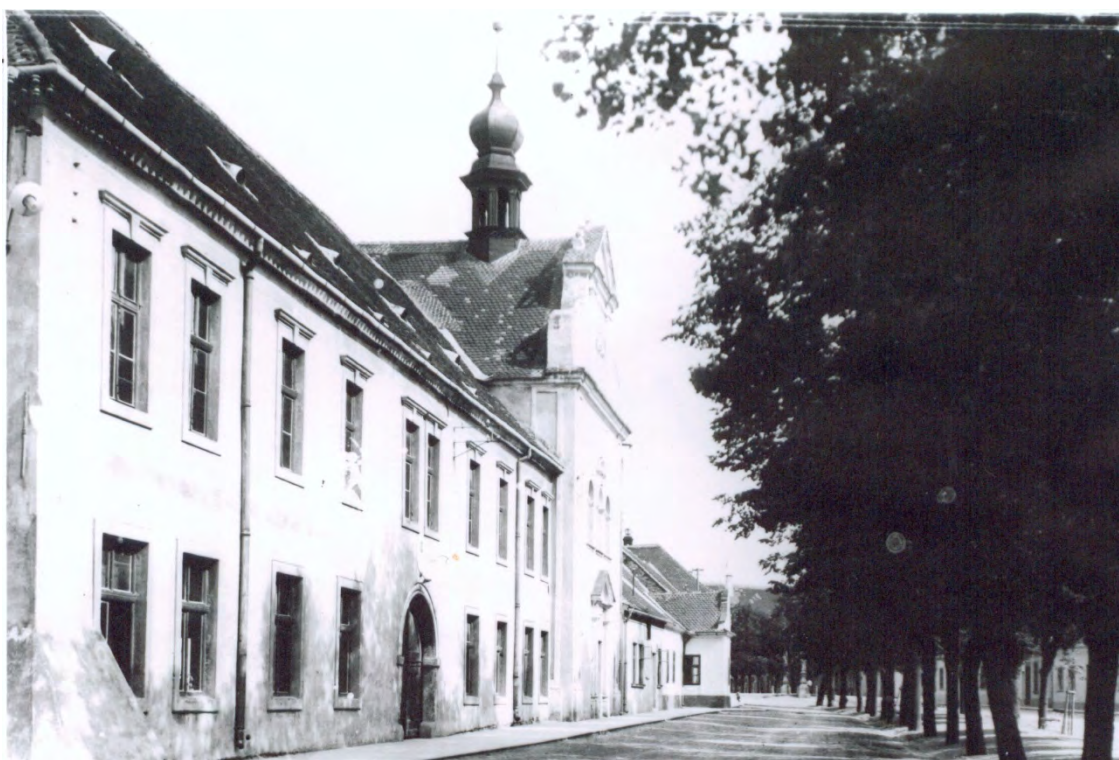
Budova paulínskeho kláštora s kostolom na západnej uličnej fronte Potočnej ulice (Dolnopotočná ul.), 30.r.,20.stor. (archív PÚ SR)
