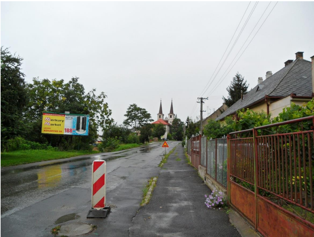
č. 3 – vonkajší pohľad z východu na vstup do mesta (smerom z Tešmaku)
