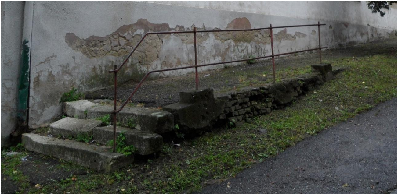
Kapitulská ulica, terasa s tehlovým oporným múrikom.
