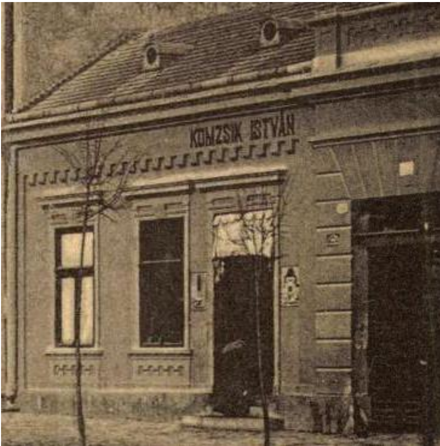
Hontianska cesta (bývalá Mostová ulica), výkladec okenného typu, r. 1915. zdroj: http://www.archivportal.hu/
