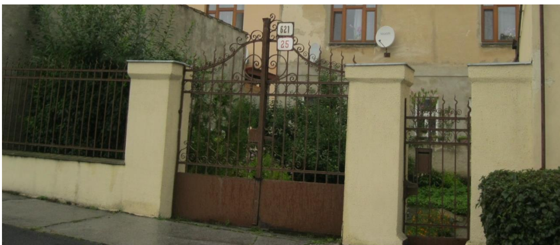
Školská ul. č. 25, kovaná brána s murovanými stĺpikmi s hlavicami.
