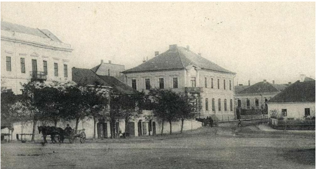
Hlavné námestie, pohľad na zapustený objekt súčasnej autobusovej stanice so vstupmi do prevádzok, s dvojkřídlovými verajami, r. 1906. zdroj: http://www.archivportal.hu/
