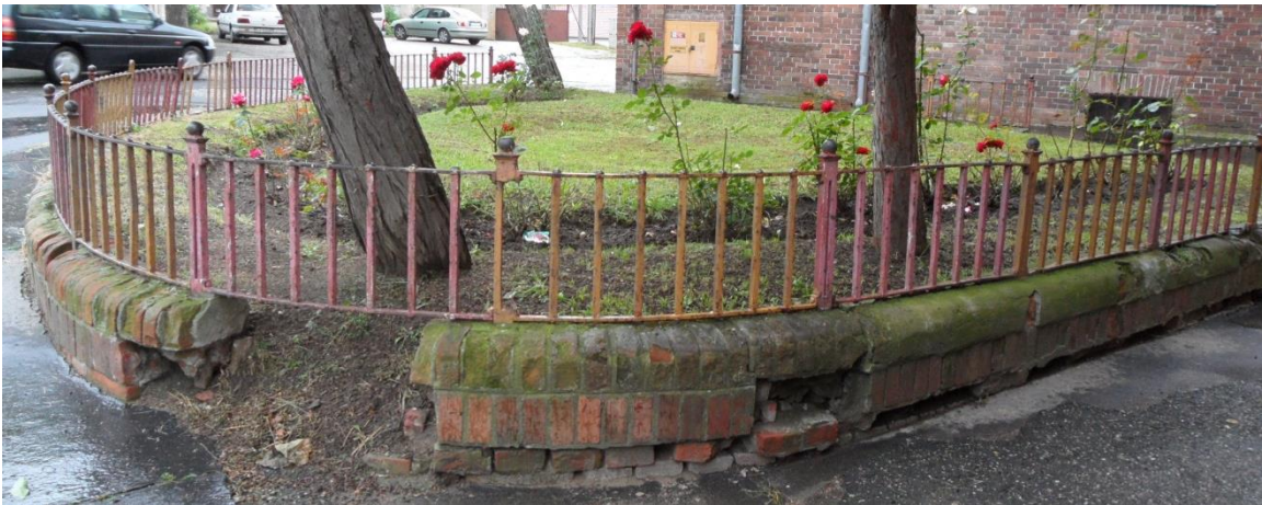
Školská ul., parc. č. 1674, bývalá pošta, stĺpikový kovový plot na tehlovej podmurovke.
