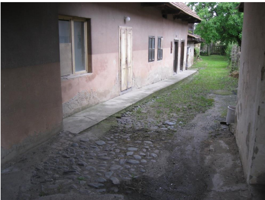
Mlynská ul., parc. č. 163, 164/1, pôvodná valúnová dlažba v prejazde a vo dvore.
