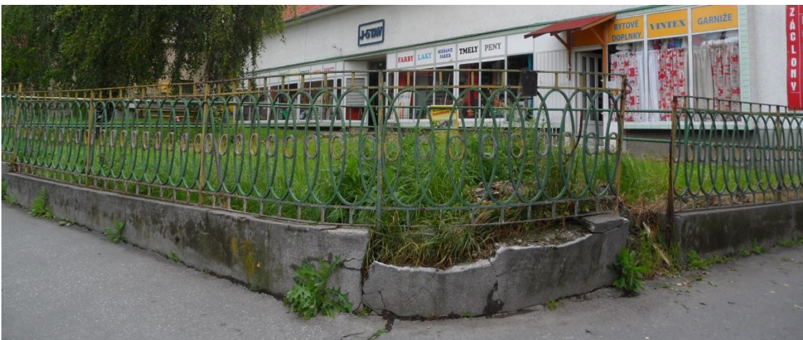
Hlavné námestie, parc. č. 1586/1, kovaný plot s geometrickým motívom na betónovej podmurovke.
