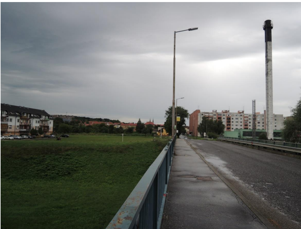
č. 4 – vonkajší pohľad zo západu z príjazdovej komunikácie do mesta
