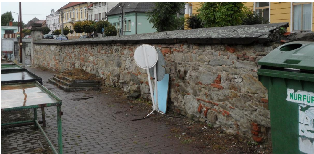
Školská ul., parc. č. 1666/1, mestská tržnica, časť murovaného kamenného oplatenia so sekundárnou betónovou strieškou.
