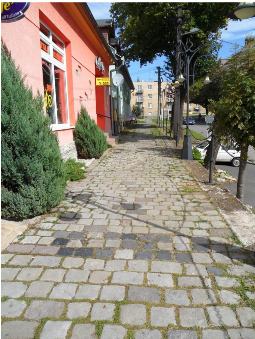
Ulica E. Boleslava Lukáča, obnovená kamenná dlažba terénnej terasy, prelom 19. a 20. storočia.
