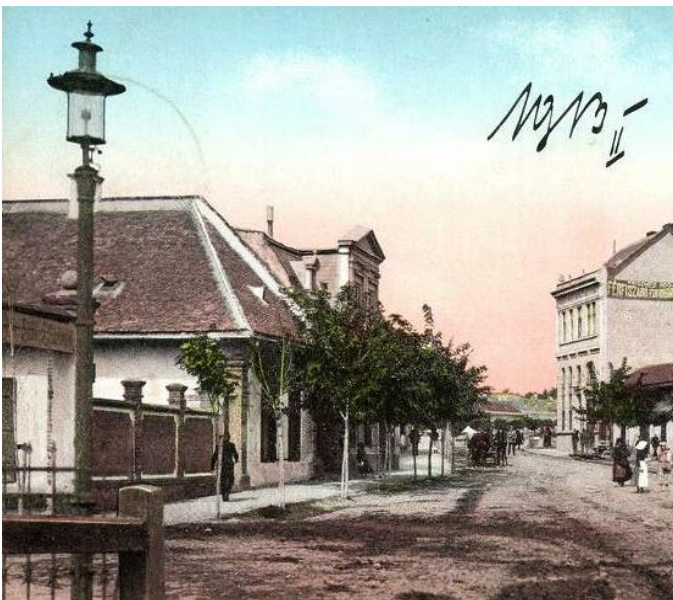
Hontianska cesta (bývalá Mostová ulica), stožiarové lucernové svietidlo, 1913 zdroj: http://www.archivportal.hu/
