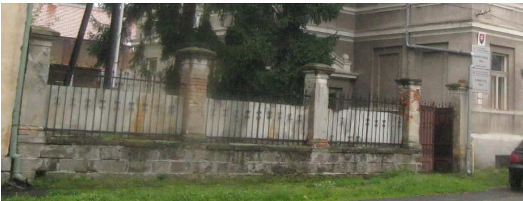
Ul. F. Rákocziho II. č. 7, parc. č. 1772/2, pôvodné oplotenie s podmurovkou, stĺpikmi so strieškami a kovanou mrežou.
