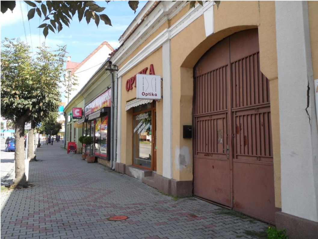
Hlavné námestie, lokálne realizovaná betónová zámková dlažba s geometrickými obrazcami, začiatok 21. storočia.
