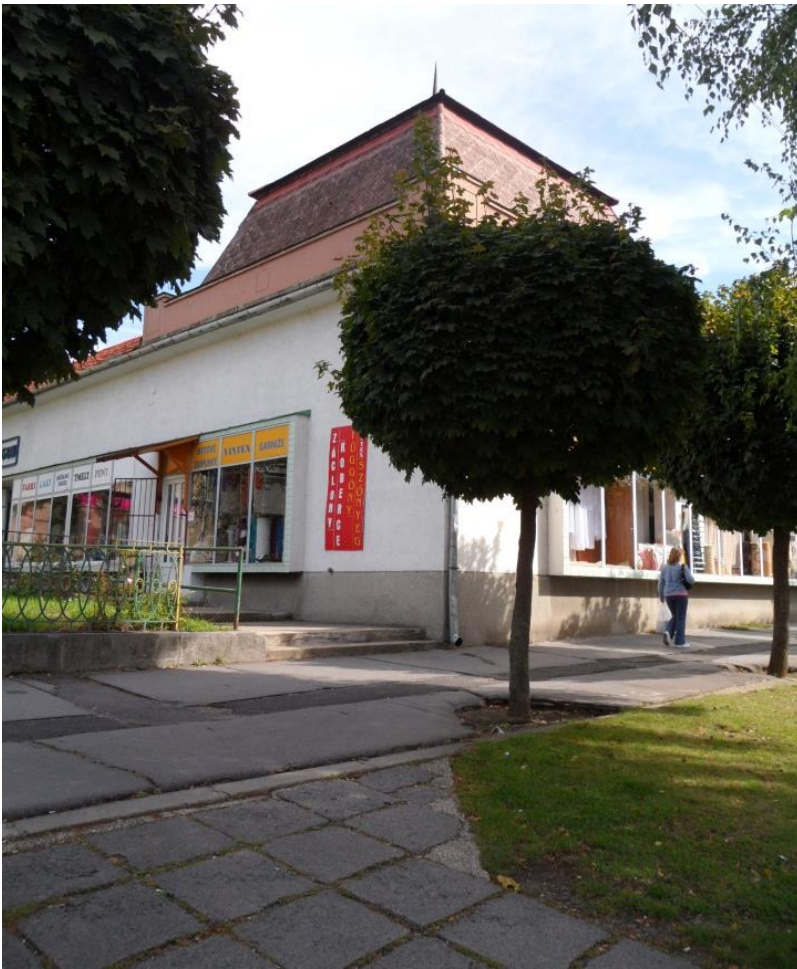
Hlavné námestie, morálne zastaralé povrchy chodníkov, kombinácia betónovej dlažby a asfaltu, 2. polovica 20. storočia.
