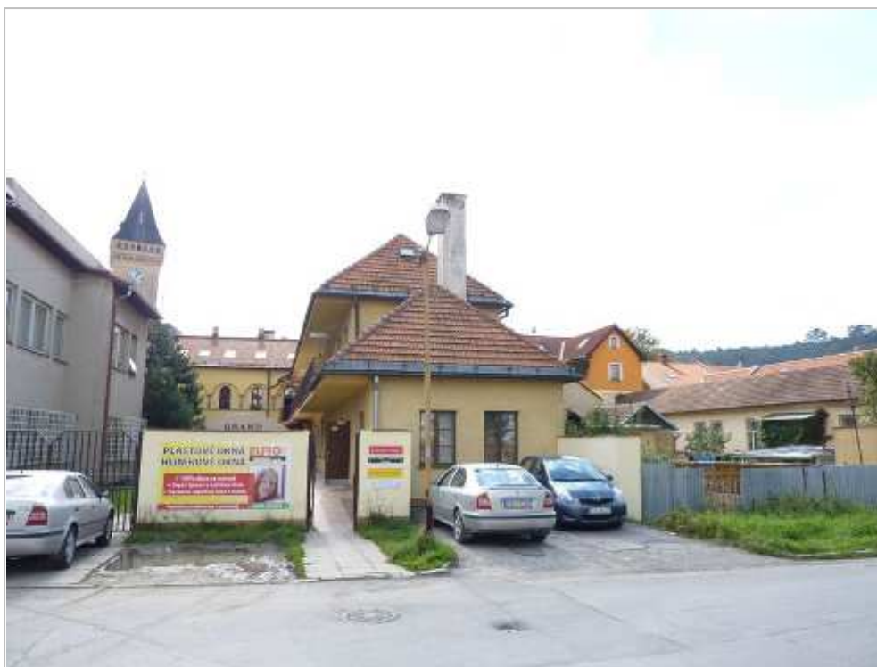
146. Dvorová část objektu na Náměstí slobody č. 27, r. 2010
