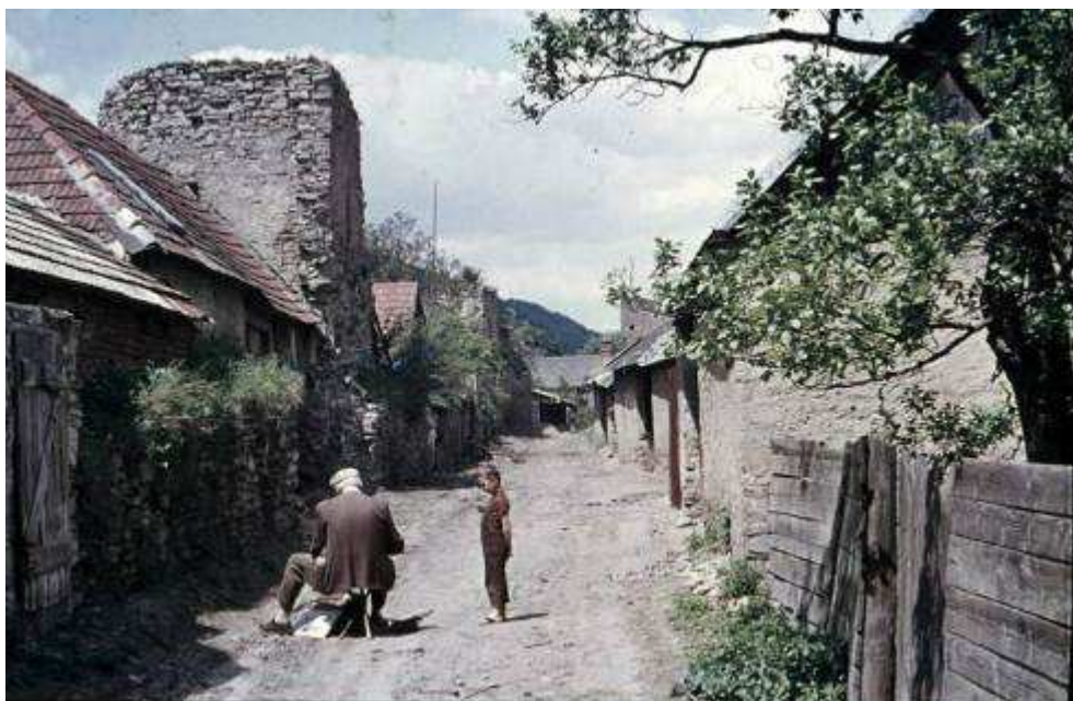
132. Prihradobná ulička, pohľad od bašty č. 4 na západ, r. 1964
