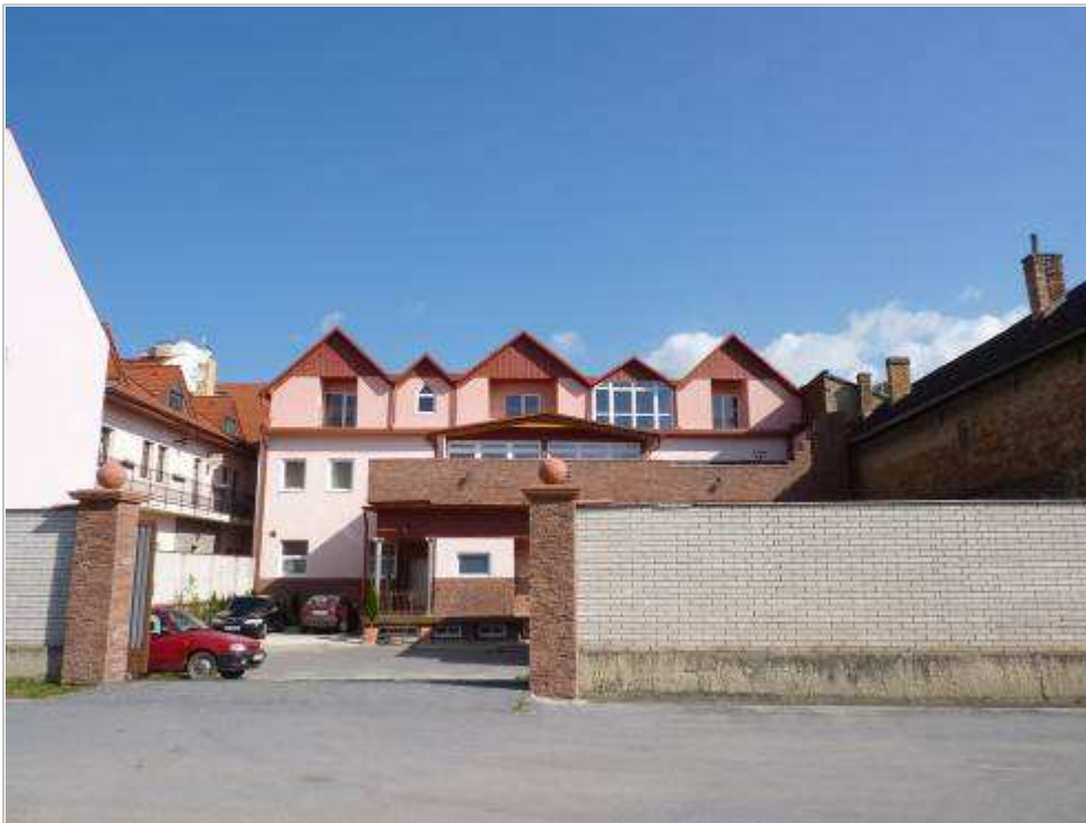
153. Dvorová fasáda objektu na Nám. slobody č. 56, r. 2010
