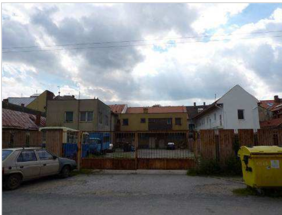
149. Dvorové časti objektov na Nám. slobody č. 53, 51 a 47, r. 2010
