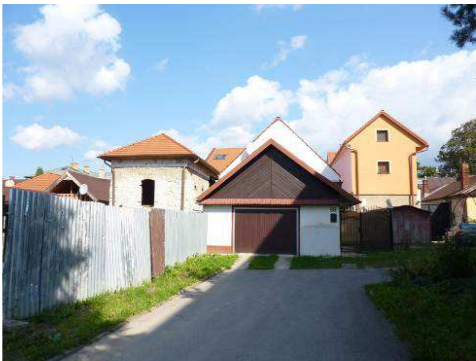
159. Dvorové křídla objektů na Nám. slobody č. 8 až 12, r. 2010
