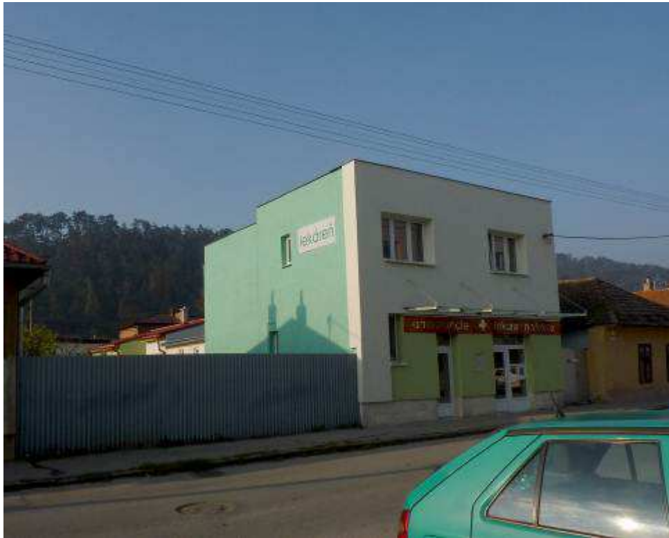
112. Ružová 27 – objekt nerešpektujúci pamiatkové hodnoty územia, r. 2010
