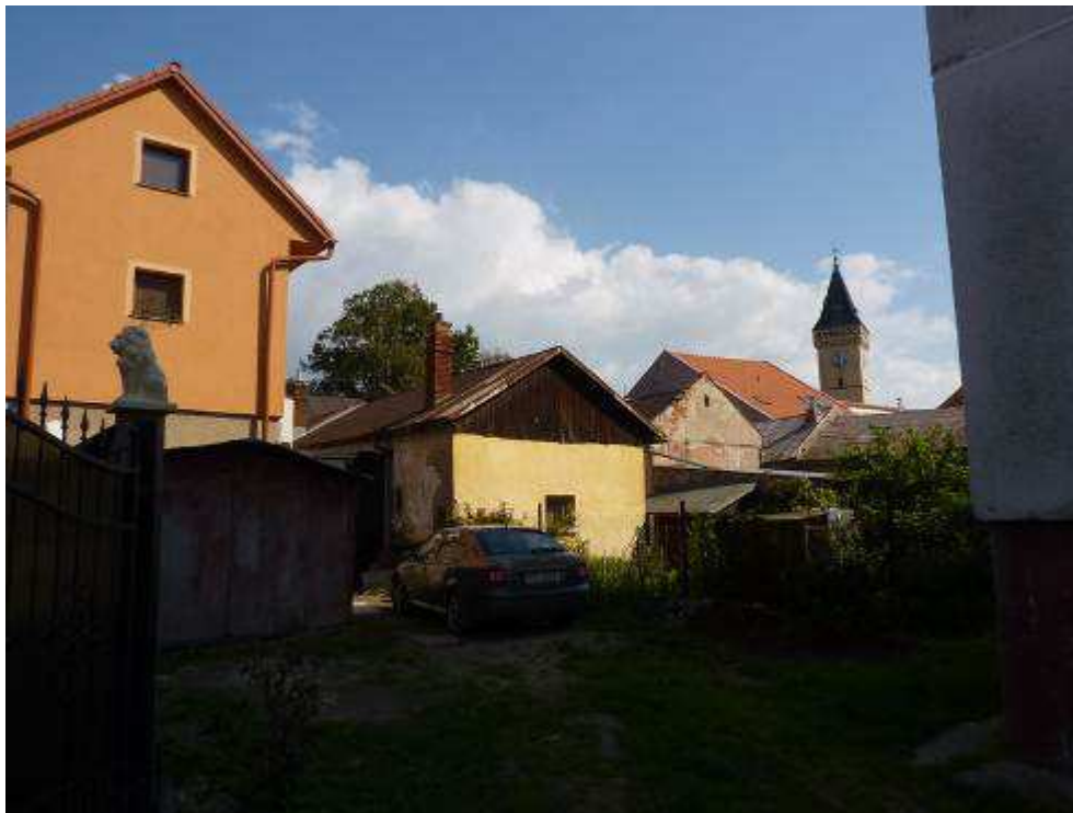
158. Dvorové křídla objektů na Nám. slobody č. 12 až 16, r. 2010
