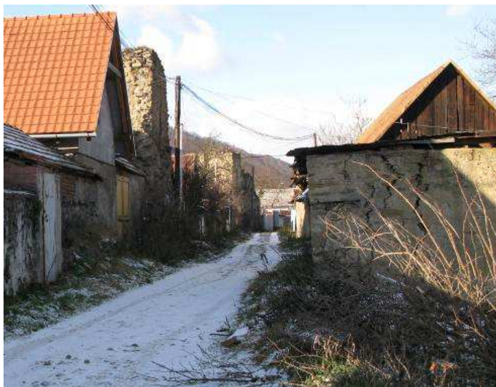
133. Prihradobná ulička, pohľad od bašty č. 4 na západ , r. 2010
