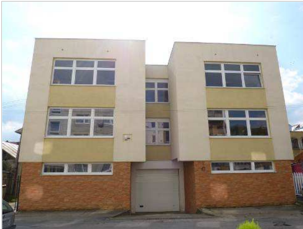
150. Severná fasáda prístavby za objektom na Námestí slobody č. 63, r. 2010
