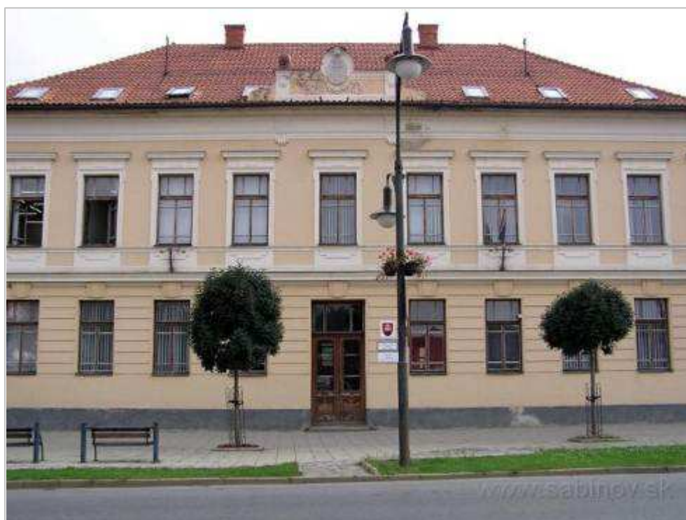
18. Námestie slobody č. 85, Bývala škola, južná fasáda, r. 2010
