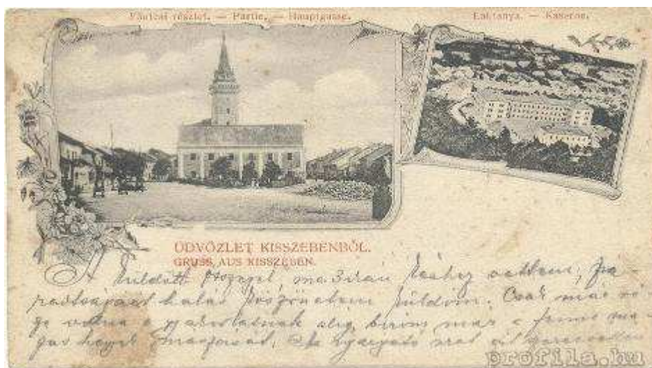
7. Historická pohľadnica s rím. kat. kostolom a lýceom, zač. 20. stor.
