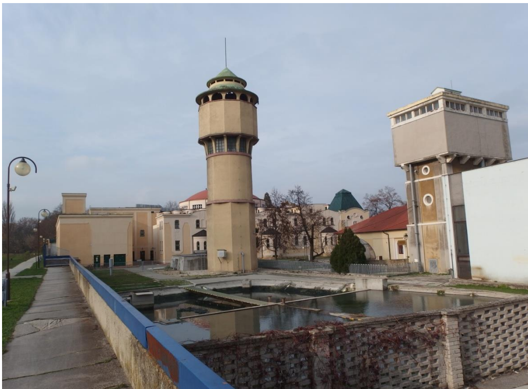
15 Vodárenská veža /vežový vodojem / Kúpeľný ostrov š.č. 8018
