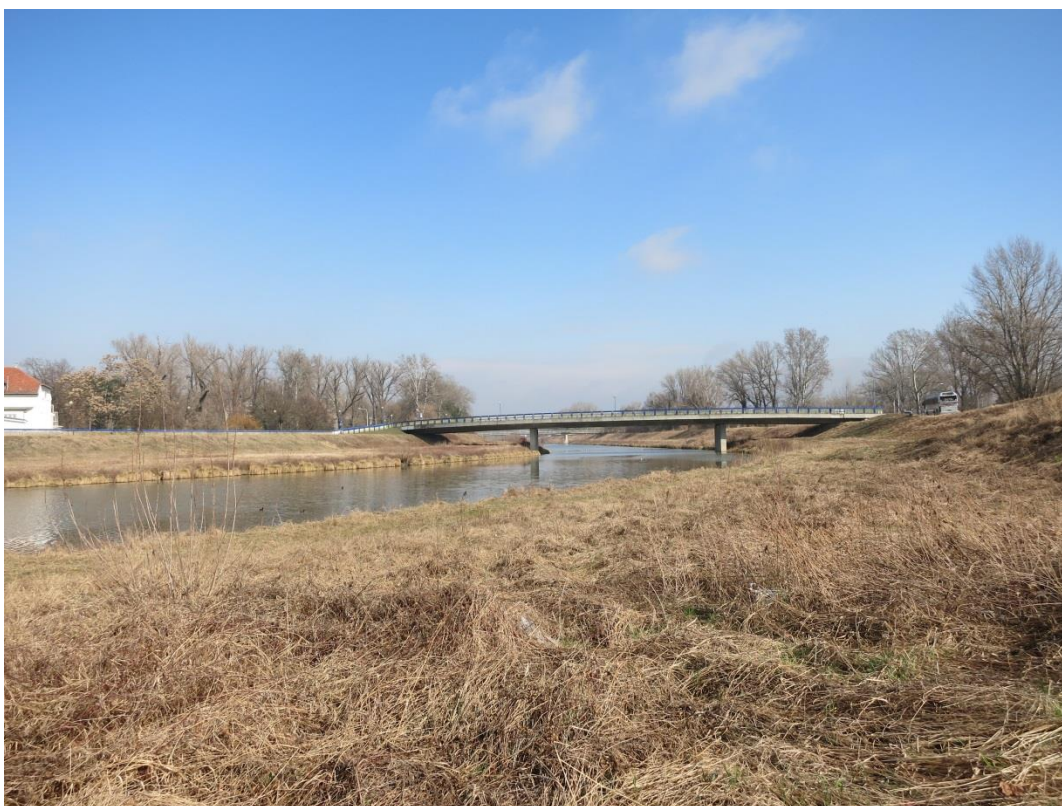
04 Kúpeľný ostrov, Kúpeľný most - cestný most z Kúpeľného ostrova do Banky
