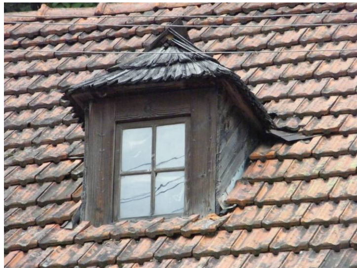
Č. 12. a 13. Pohľady na typické druhy zachovaných starších presvetľovacích vikierov podstreší hospodárskeho objektu č. súpisné 9 a objektu hostinca č. 4
