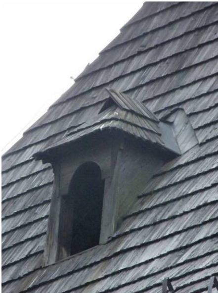
Č. 12. a 13. Pohľady na typické druhy zachovaných starších presvetľovacích vikierov podstreší hospodárskeho objektu č. súpisné 9 a objektu hostinca č. 4
