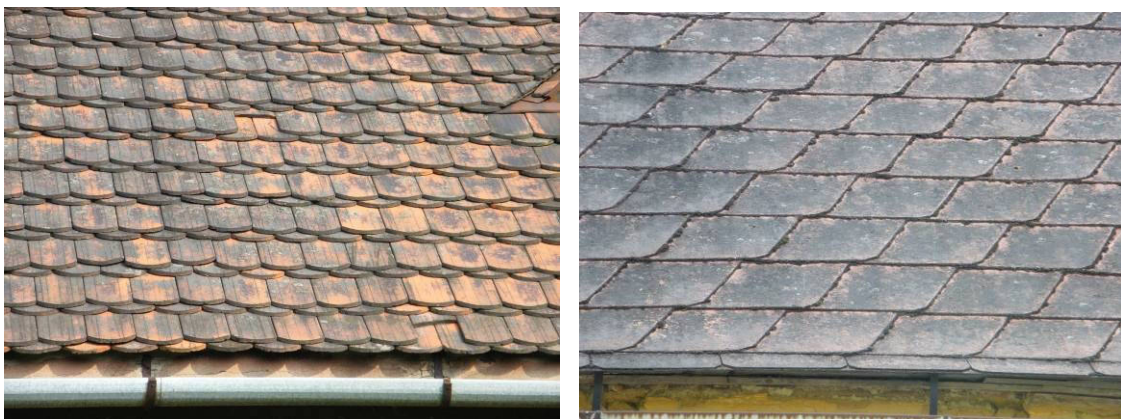
Č. 20., 21, 22. a 23. Pohľady na typy krytín uplatnených na objektoch v pamiatkovom území - šindel jednoduché kladenie (hospodársky objekt č. súp. 9), dvojitá drážková keramická krytina typ. francúzska (hostinec č. súpisné 4), bobrovka dvojité kladenie (rodinný dom č. súpisné 46) a AZC šablóny (rodinný dom s obchodom č. 196)
