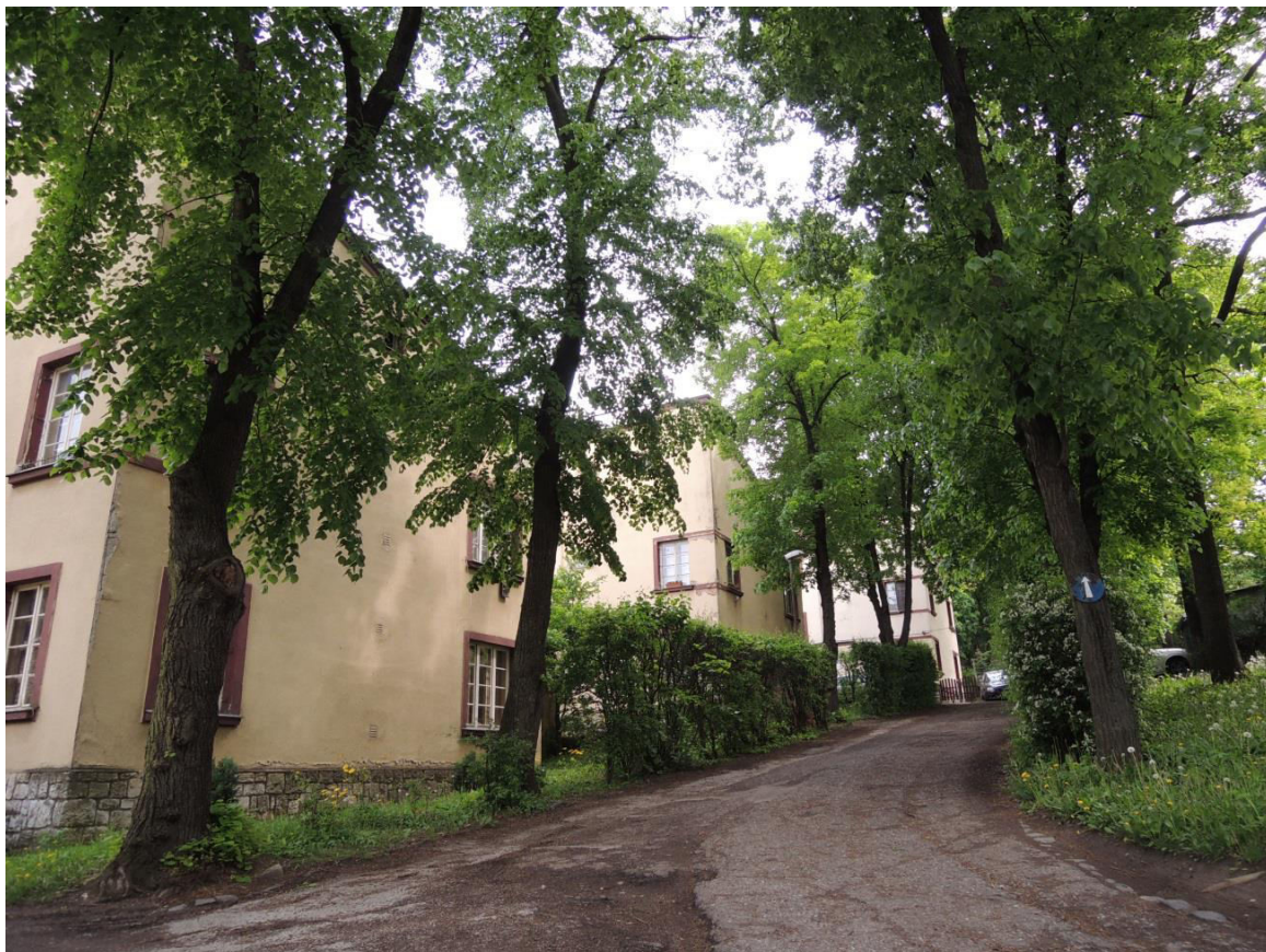
O. 23 Pohľad do areálu súboru bytových domov zoskupených do radov, tzv. krajinských domkov na ulici Misionárska. Obytný súbor je umiestnený v severozápadnej časti sektora na úpätí severných svahov Kalvárie.
