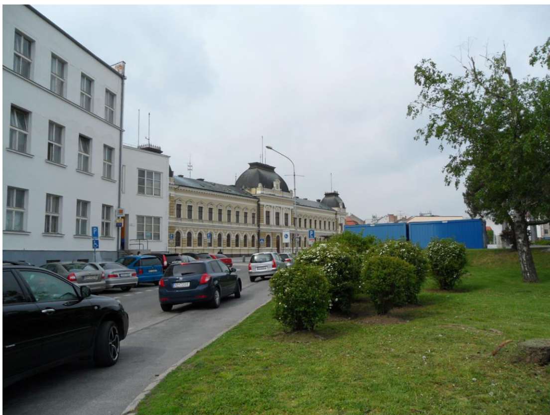
B. 11 Pohľad na Svätoplukovo námestie z ulice B. Němcovej
