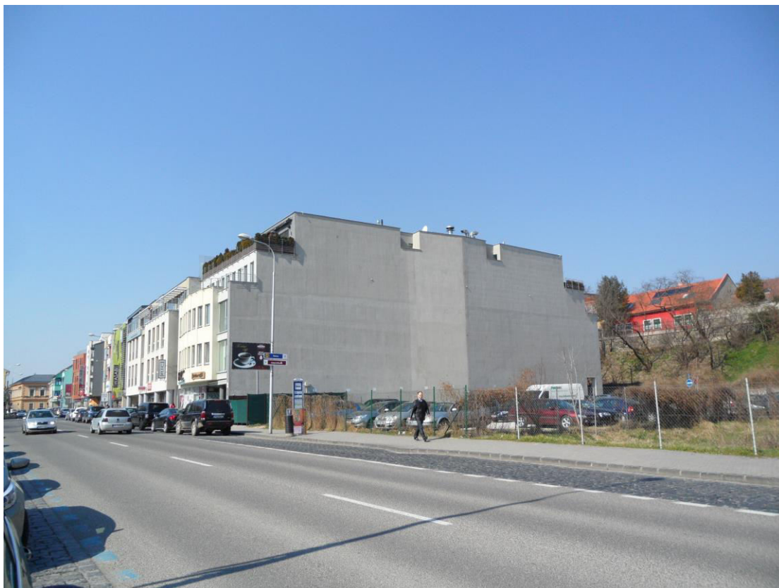
B. 15 Pohľad na novodobú zástavbu ulice Mostná (zač. 21. storočia)
