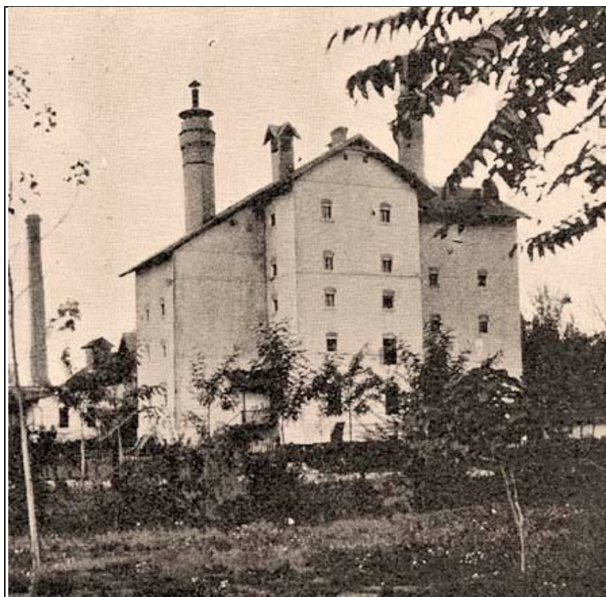
168. Pohľad na bývalú sladovňu z juhovýchodu, koniec 19. storočia (sektor N)
