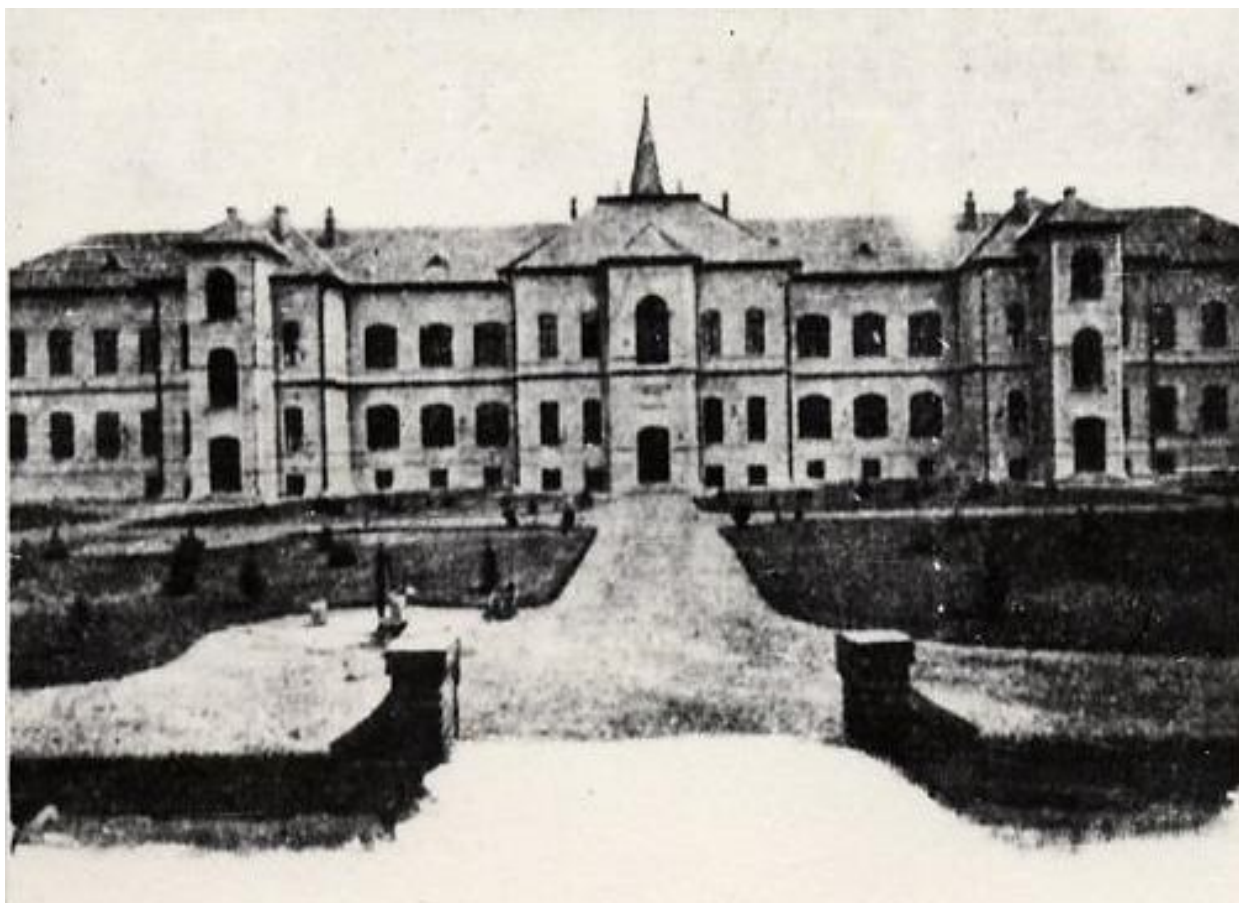
176. Pohľad od pavilónu psychiatrického oddelenia na juhozápadnú fasádu hlavnej budovy areálu bývalej Župnej nemocnice, koniec 19. storočia (sektor N)
