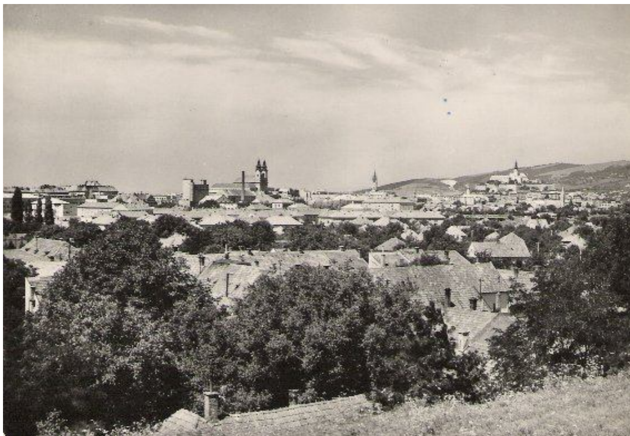
163. Pohľad zo severovýchodných svahov kopca Kalvárie nad Pútnickou ulicou na historické jadro mesta Nitry, uprostred zástavba na ploche starého letiska, dole zástavba pod Kalváriou (Pútnická ulica, Kasalova ulica a Robotnícka ulica), prelom 50. a 60. rokov 20. storočia (sektor M)
