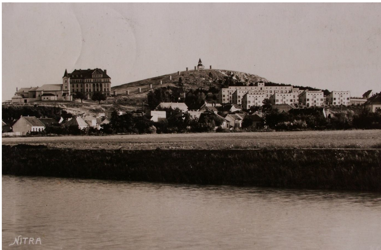
156. Pohľad od zregulovaného koryta rieky Nitry na zástavbu Robotníckej ulice a Mariánskej doliny, v pozadí vľavo r. k. Kostol Nanebovzatia Panny Márie s bývalým kláštorom nazarénov a Misijný dom Matky Božej, v strede kopec Kalvárie s kaplnkami zastavení krížovej cesty a vpravo obytný súbor na Misionárskej ulici, 30. roky 20. storočia (sektor M, O)
