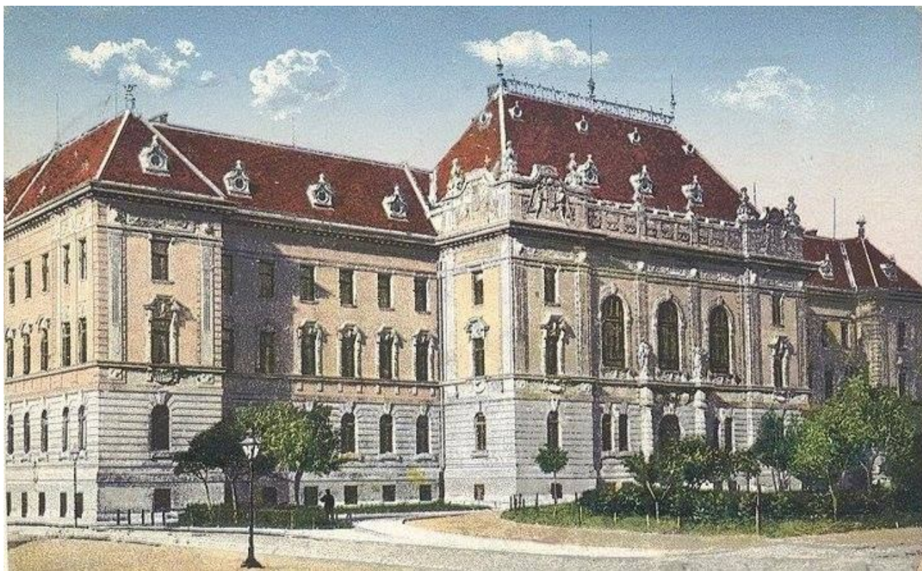
132. Pohľad na bývalý Justičný palác (dnes Krajský a okresný súd) – Sedria s parkovou úpravou predpočia, začiatok 20. storočia (sektor K)
