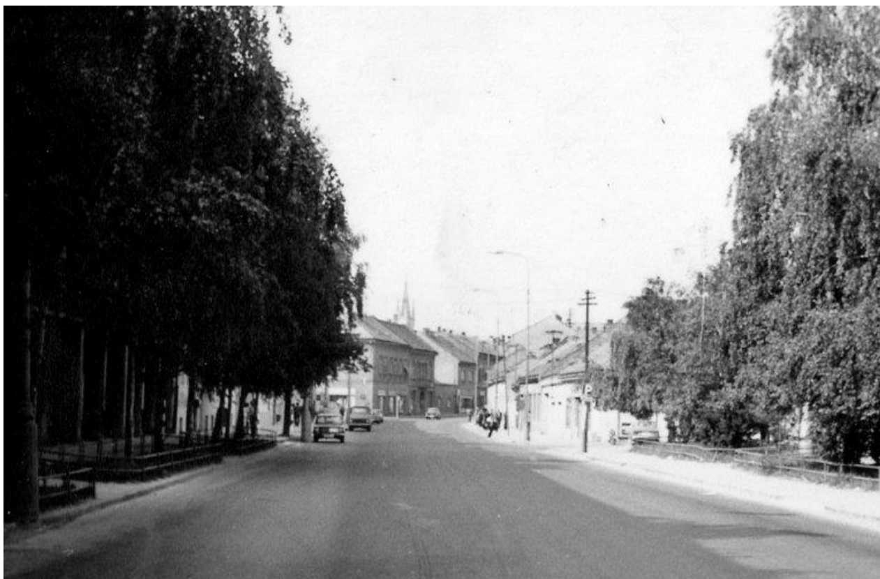
103. Pohľad na ulicu Mostná smerom z Predmostia, zachovaná časť pôvodnej zástavby, 70. roky 20. storočia (sektor D)
