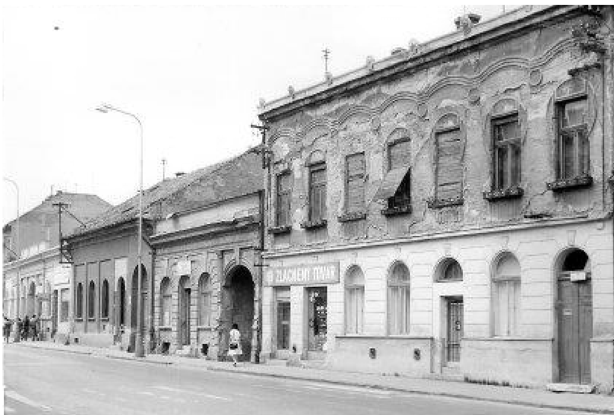
92. Pohľad na dodnes zachované objekty Mostná č. 36 – 42 v radovej zástavbe, 70. roky 20. storočia (sektor D)
